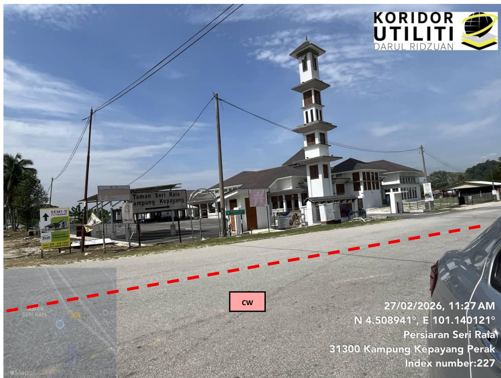
JAJARAN KOREKAN TERBUKA JALAN BERTURAP DI PERSIARAN SERI RAI 2
