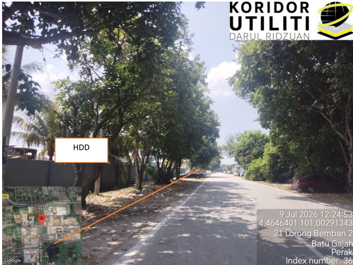
KAEDAH HDD DI LORONG BEMBAN 2
