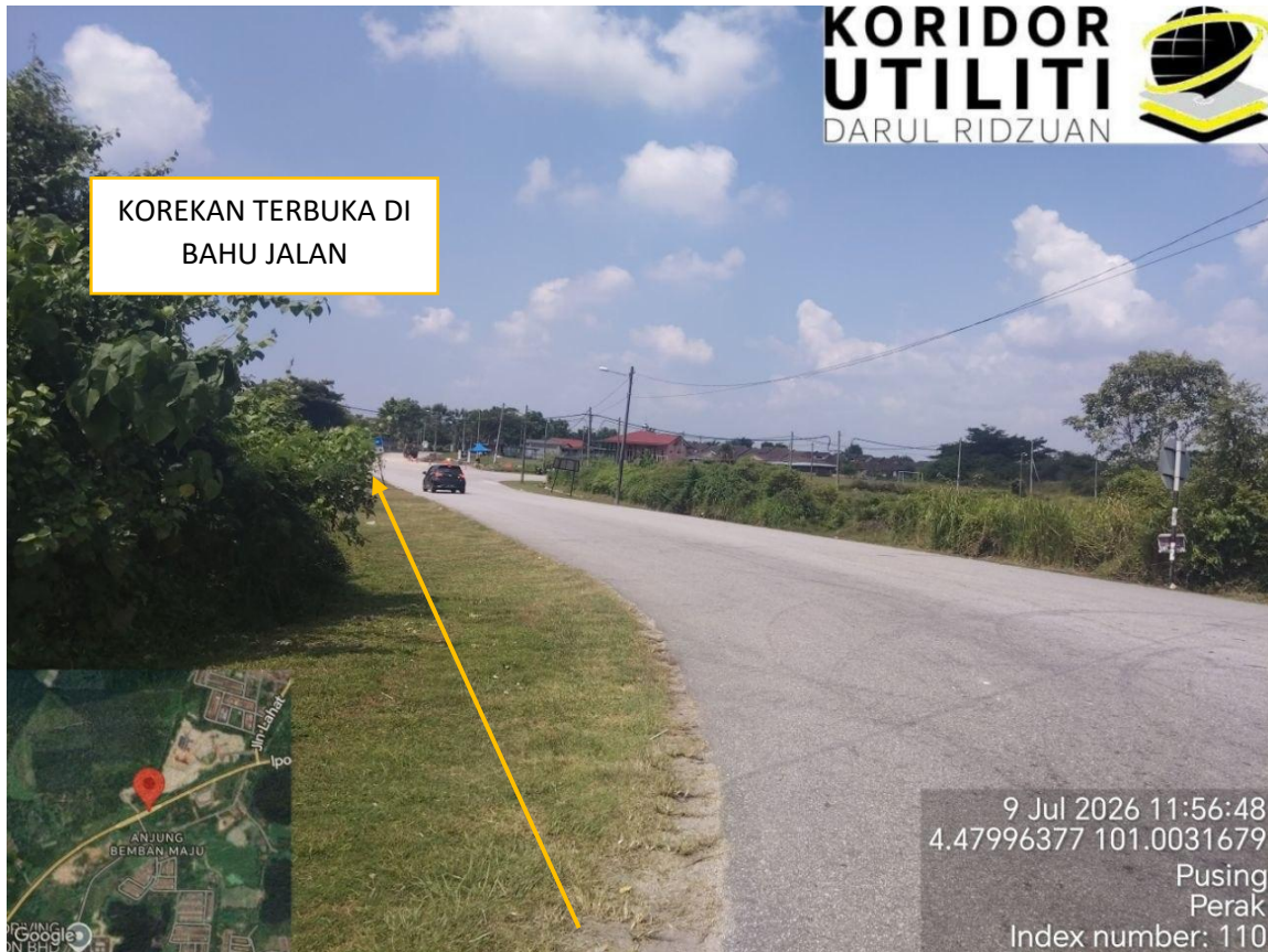
LOKASI DI JALAN DATARAN BEMBAN UTAMA
