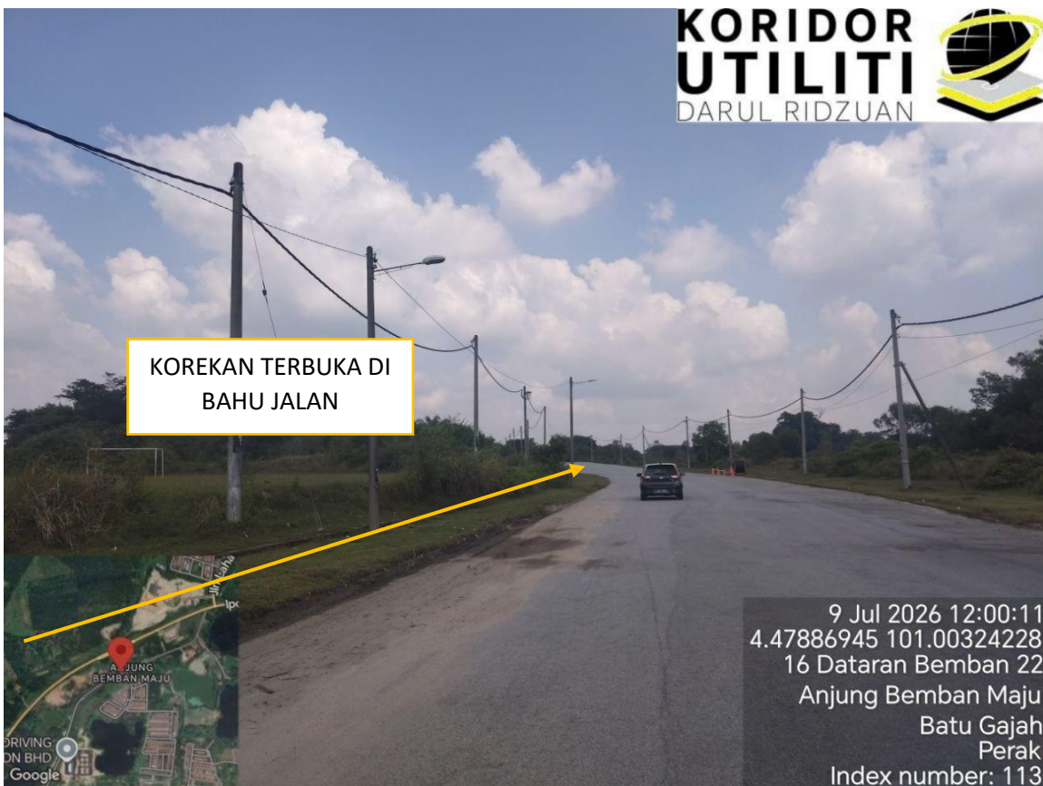
LOKASI DI JALAN DATARAN BEMBAN UTAMA
