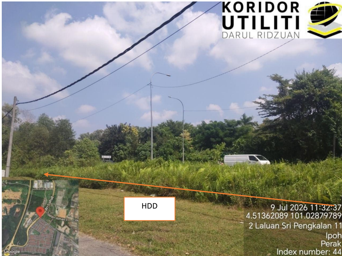
LOKASI DI JALAN LAHAT - PUSING (A2)
