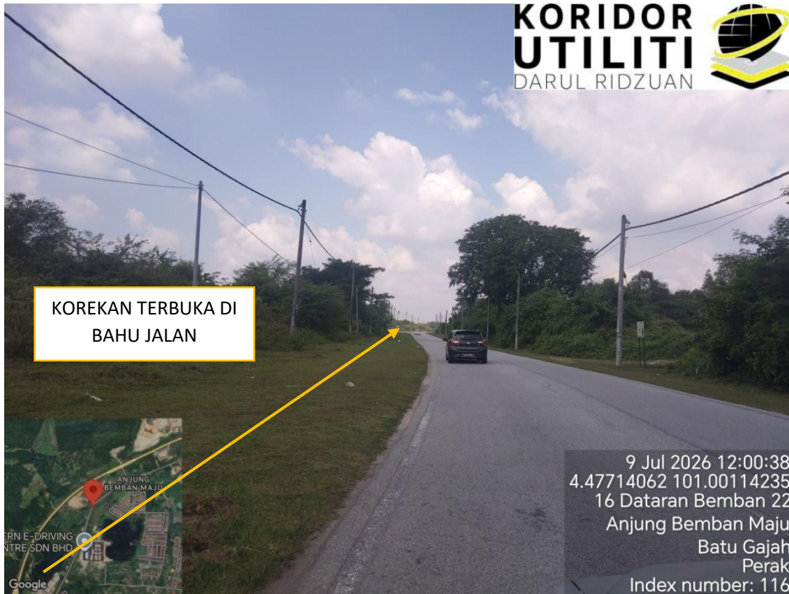
LOKASI DI JALAN DATARAN BEMBAN UTAMA
