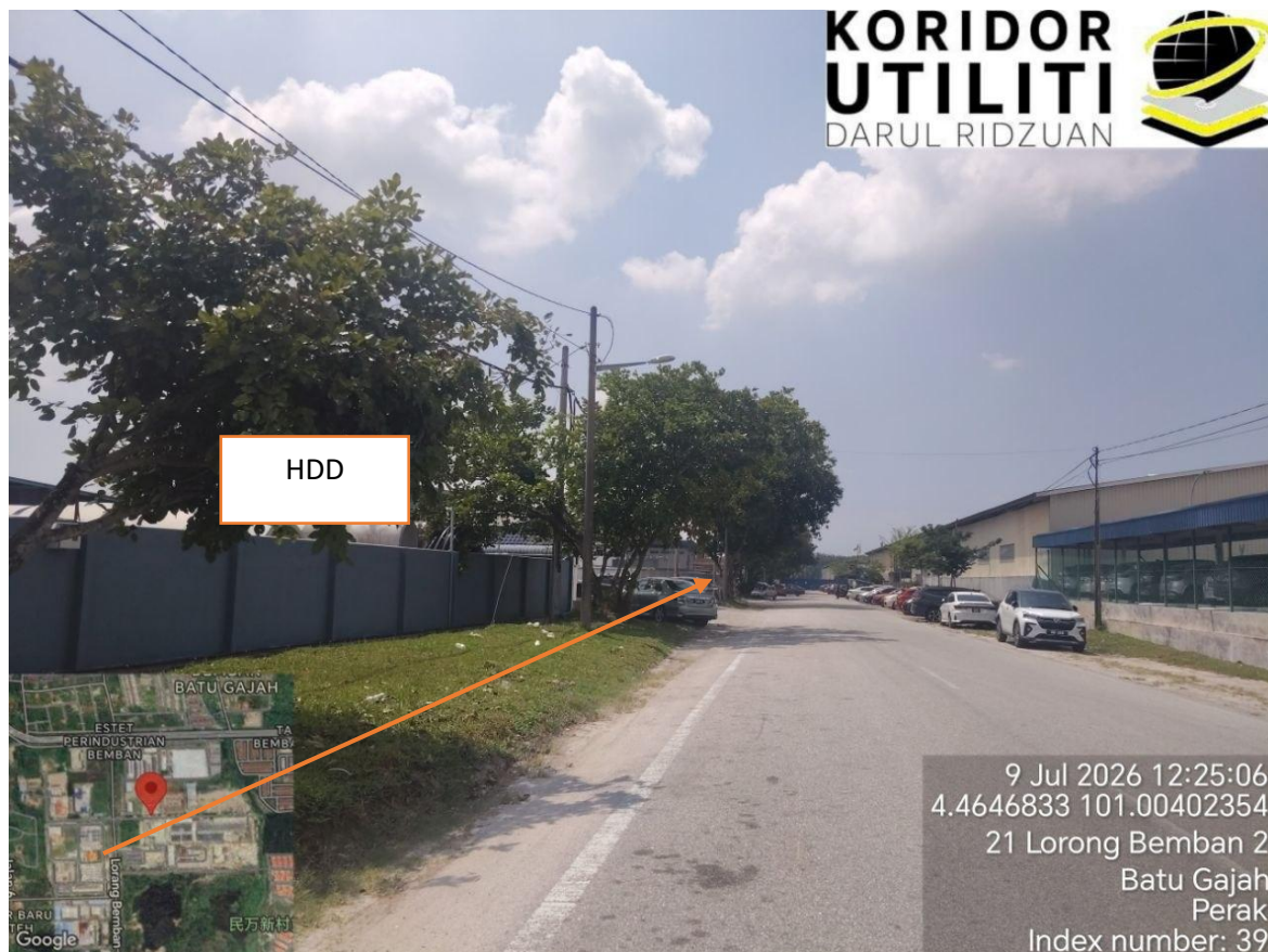
KAEDAH HDD DI LORONG BEMBAN 2
