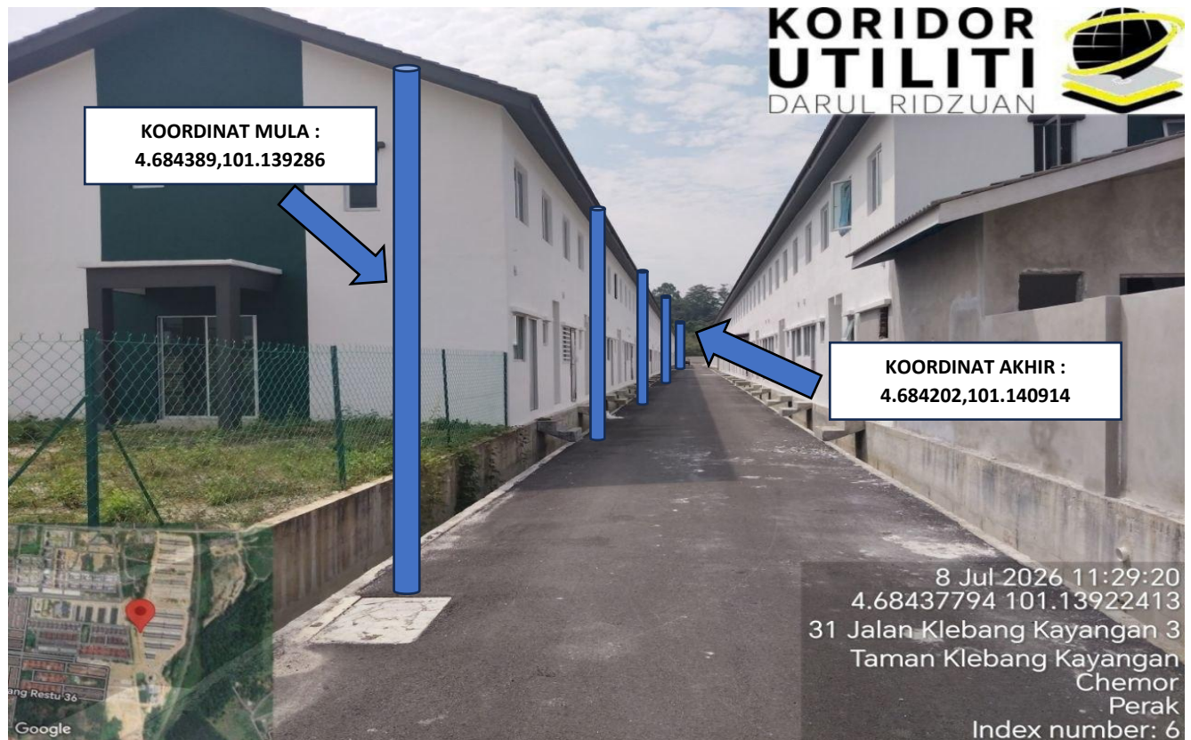
LOKASI KERJA PENANAMAN TIANG DI JALAN KLEBANG KAYANGAN 3 ( LORONG BELAKANG)
