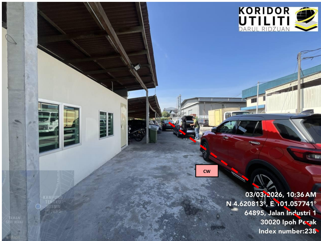
JAJARAN KOREKAN TERBUKA JALAN BERTURAP DI JALAN INDUSTRI 1
