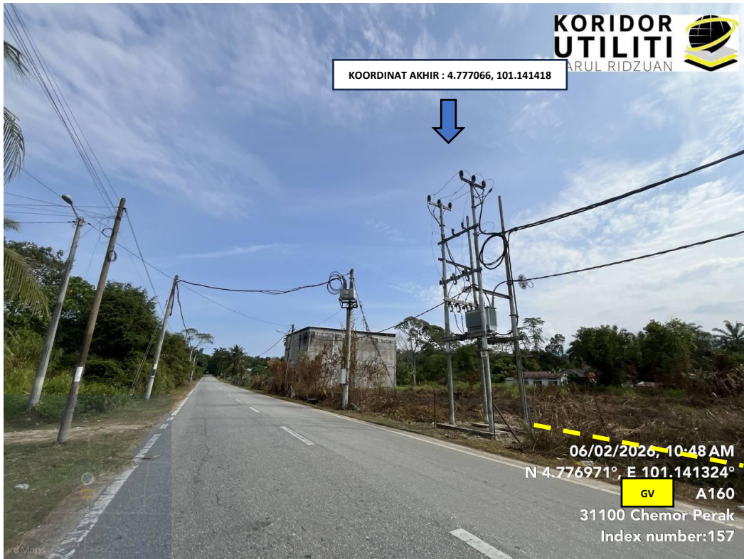
LOKASI KOORDINAT AKHIR KERJA KOREKAN TERBUKA BAHU JALAN (Sambungan kepada tiang TNB sedia ada)
