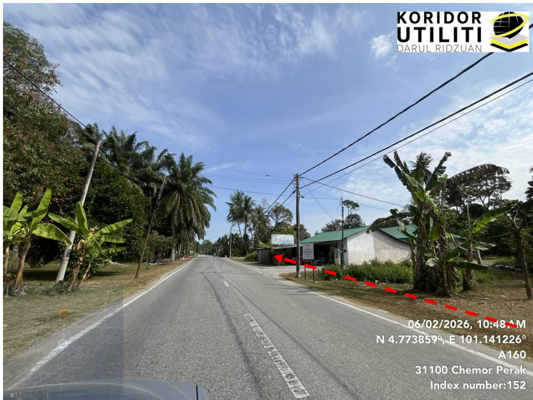
JAJARAN KERJA PENANAMAN TIANG DAN PENARIKAN KABEL DI JALAN CHEMOR – ULU KUANG (A160)
