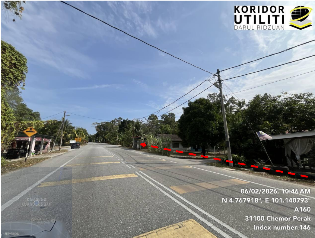
AJARAN KERJA PENANAMAN TIANG DAN PENARIKAN KABEL DI JALAN CHEMOR – ULU KUANG (A160)
