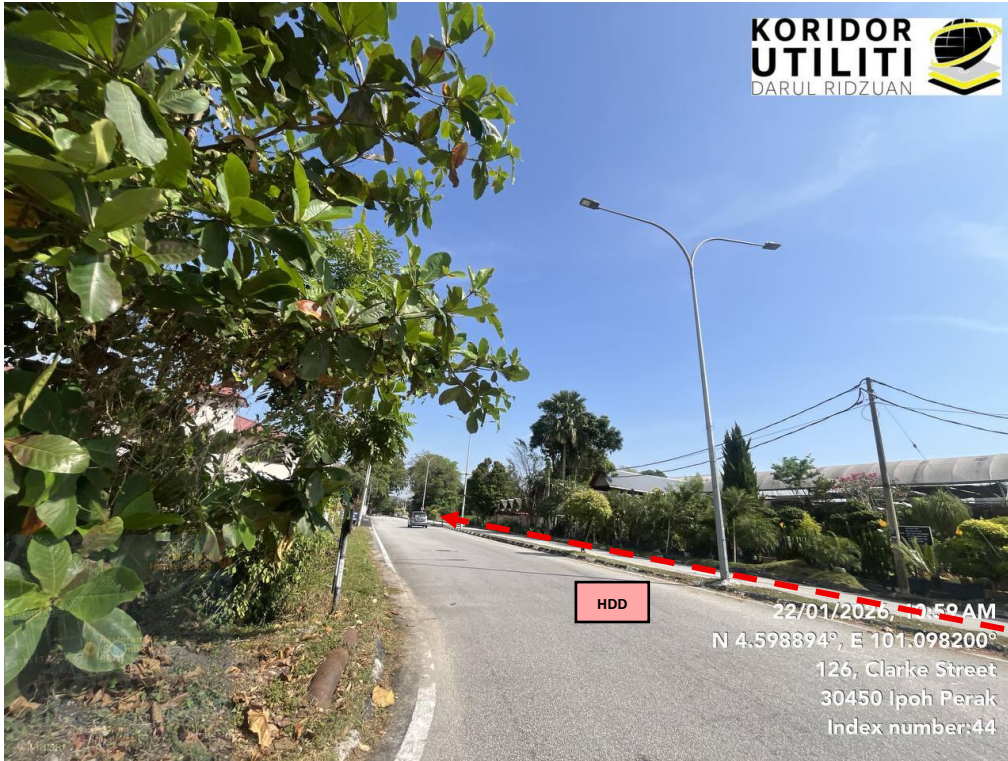
JAJARAN KERJA HDD DI JALAN CHIN CHOON SAM
