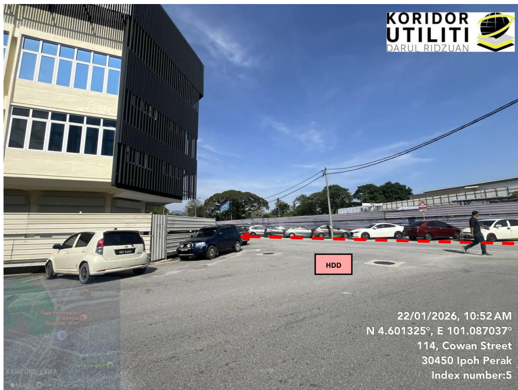
JAJARAN KERJA HDD DI JALAN RAJA EKRAM
