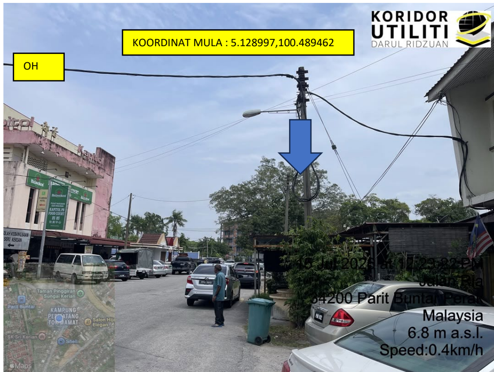
LOKASI DI JALAN RIA
