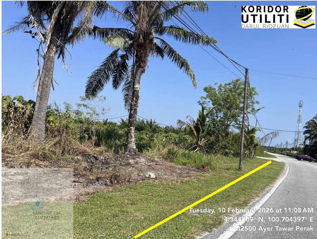
JAJARAN HDD DI JALAN MASUK KG TELAGA NENAS (A235)
