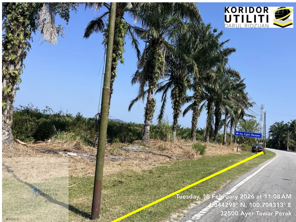
AJARAN HDD DI JALAN MASUK KG TELAGA NENAS (A235)
