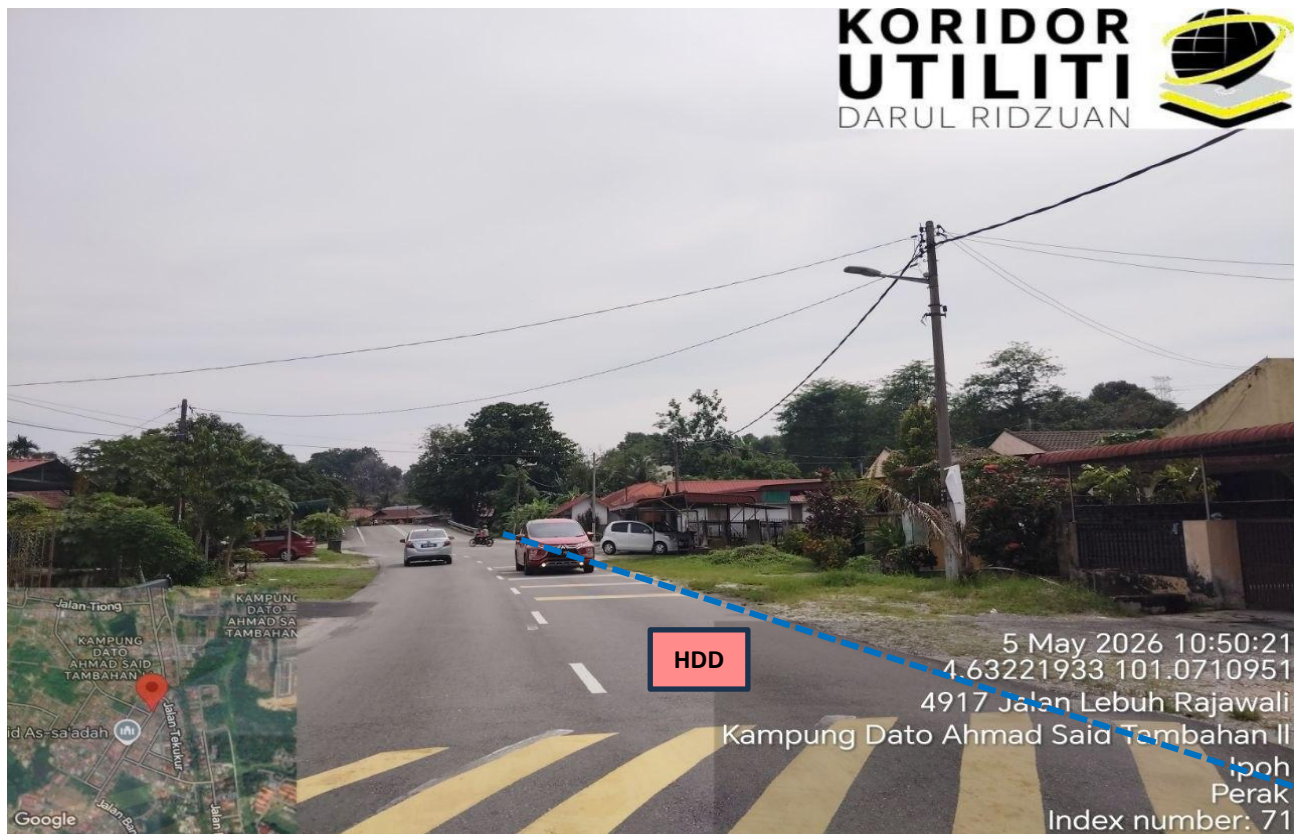
LOKASI KERJA KOREKAN HDD DI JALAN RAJAWALI
