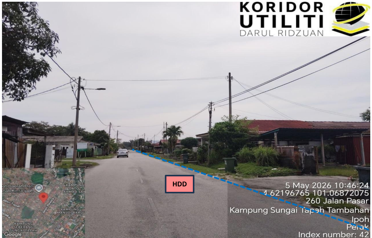
LOKASI KERJA KOREKAN HDD DI JALAN PASAR
