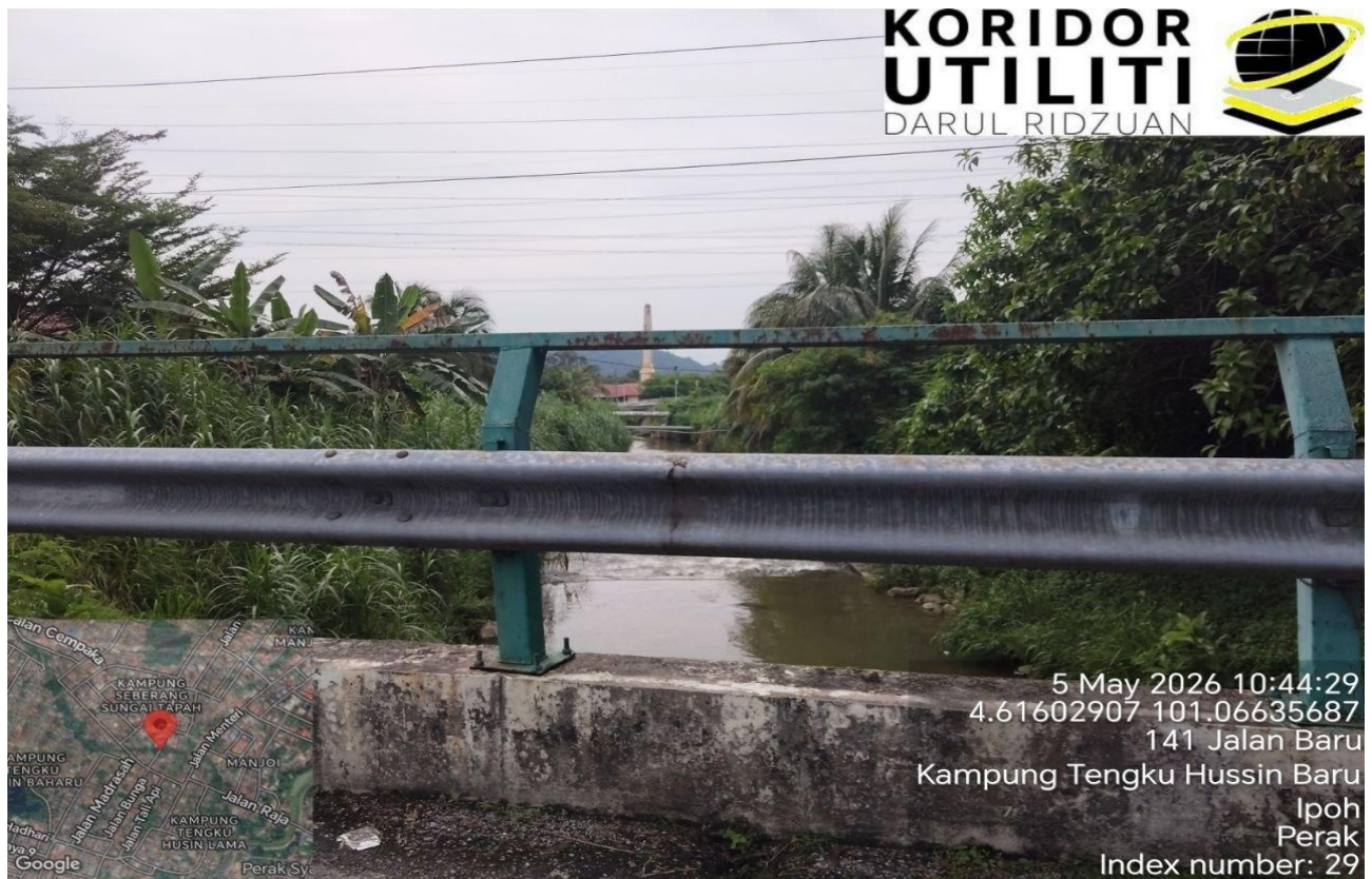
LOKASI KERJA KOREKAN HDD CROSSING DI JALAN SUNGAI TAPAH
