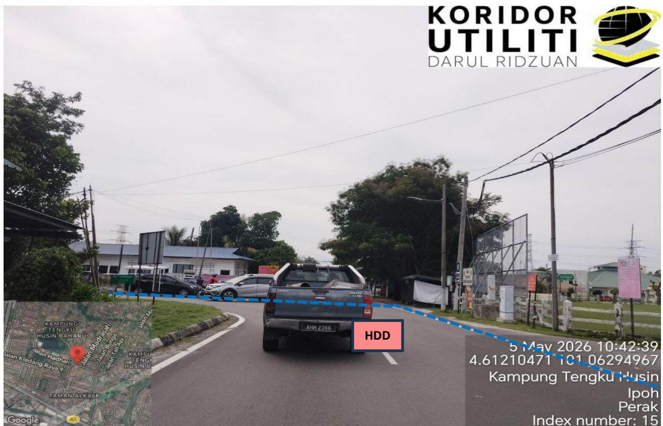
LOKASI KERJA KOREKAN HDD DI JALAN PADANG
