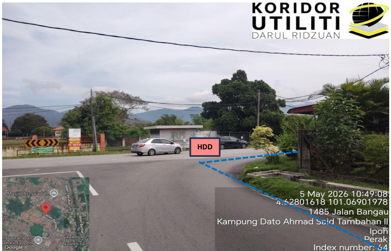
LOKASI KERJA KOREKAN HDD DI JALAN BANGAU
