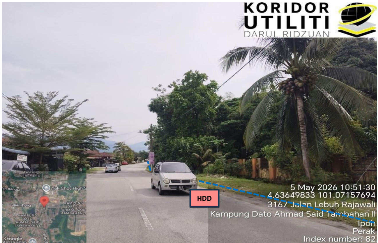
LOKASI KERJA KOREKAN HDD DI HALA JATI MERU 29
