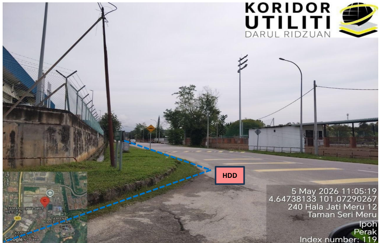
LOKASI KERJA KOREKAN HDD DI HALA JATI 12
