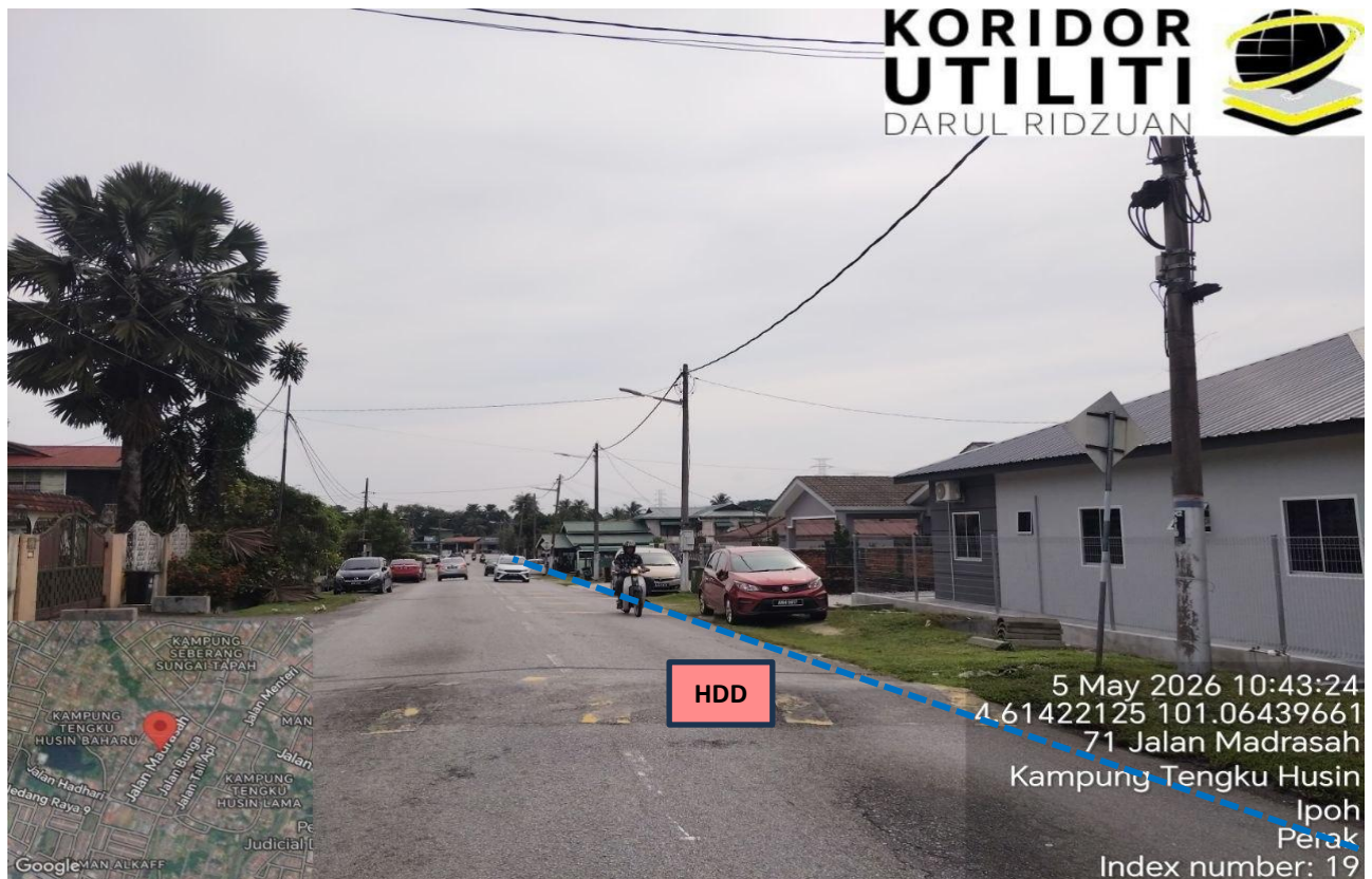
LOKASI KERJA KOREKAN HDD DI JALAN MADRASAH
