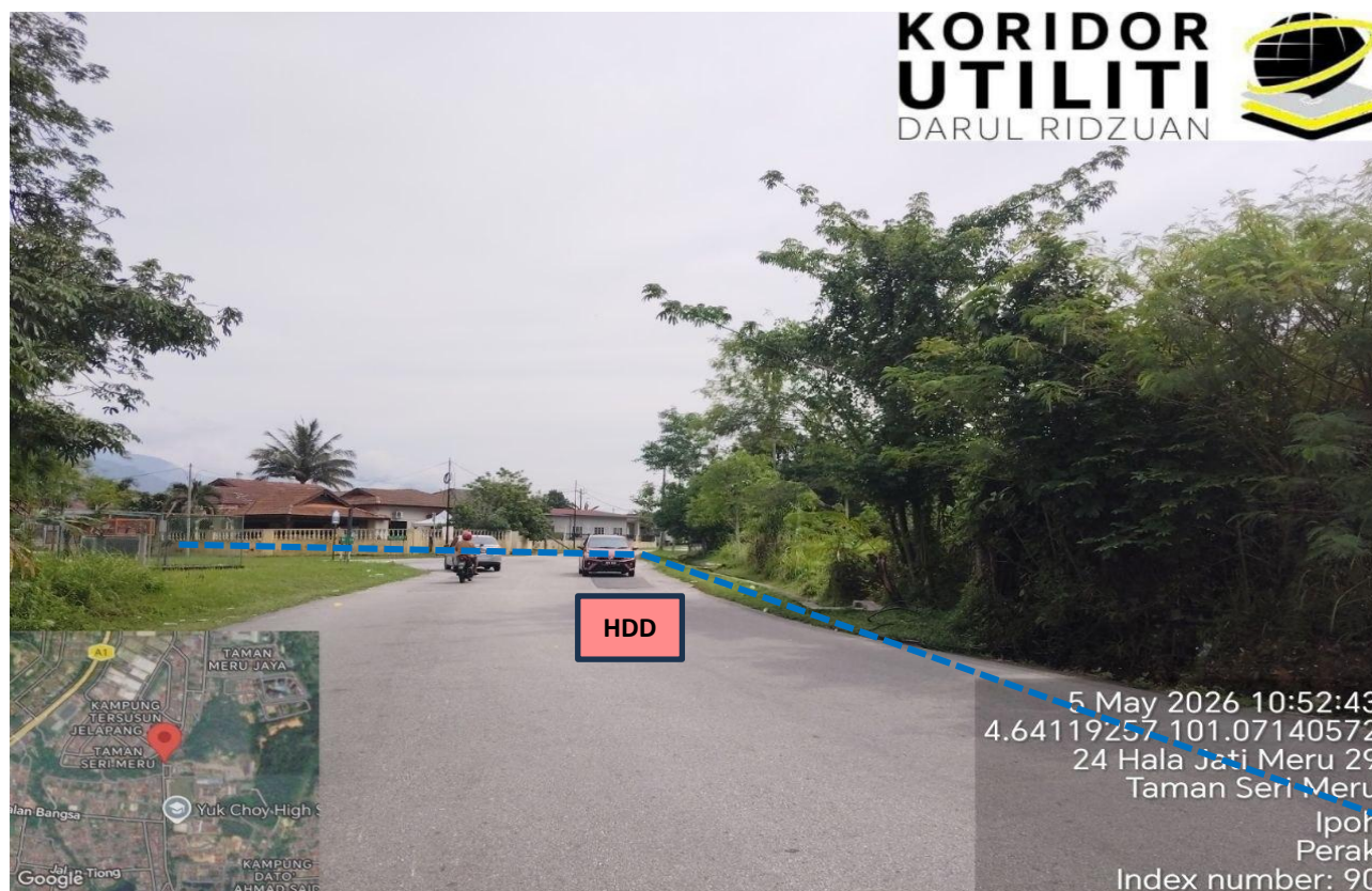
LOKASI KERJA KOREKAN HDD DI HALA JATI MERU 9
