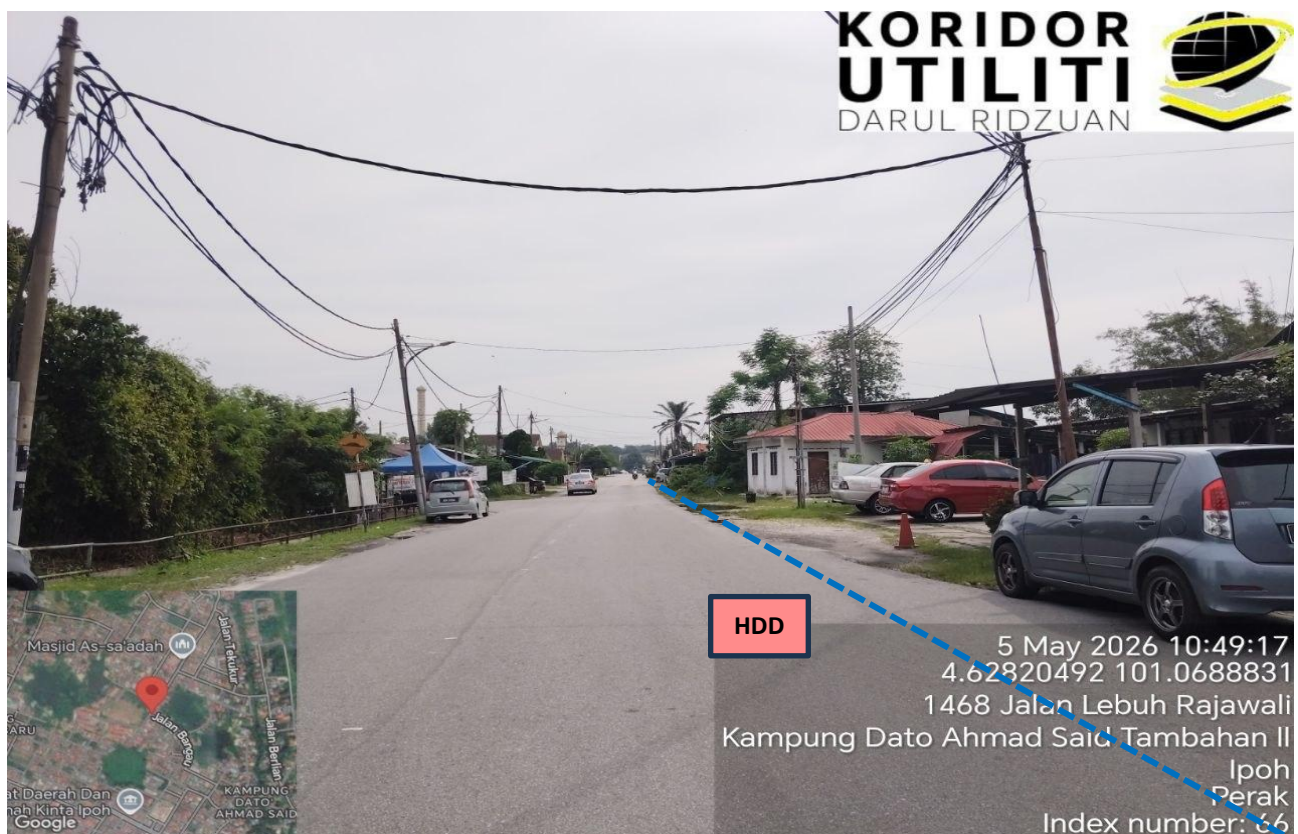
LOKASI KERJA KOREKAN HDD DI JALAN RAJAWALI
