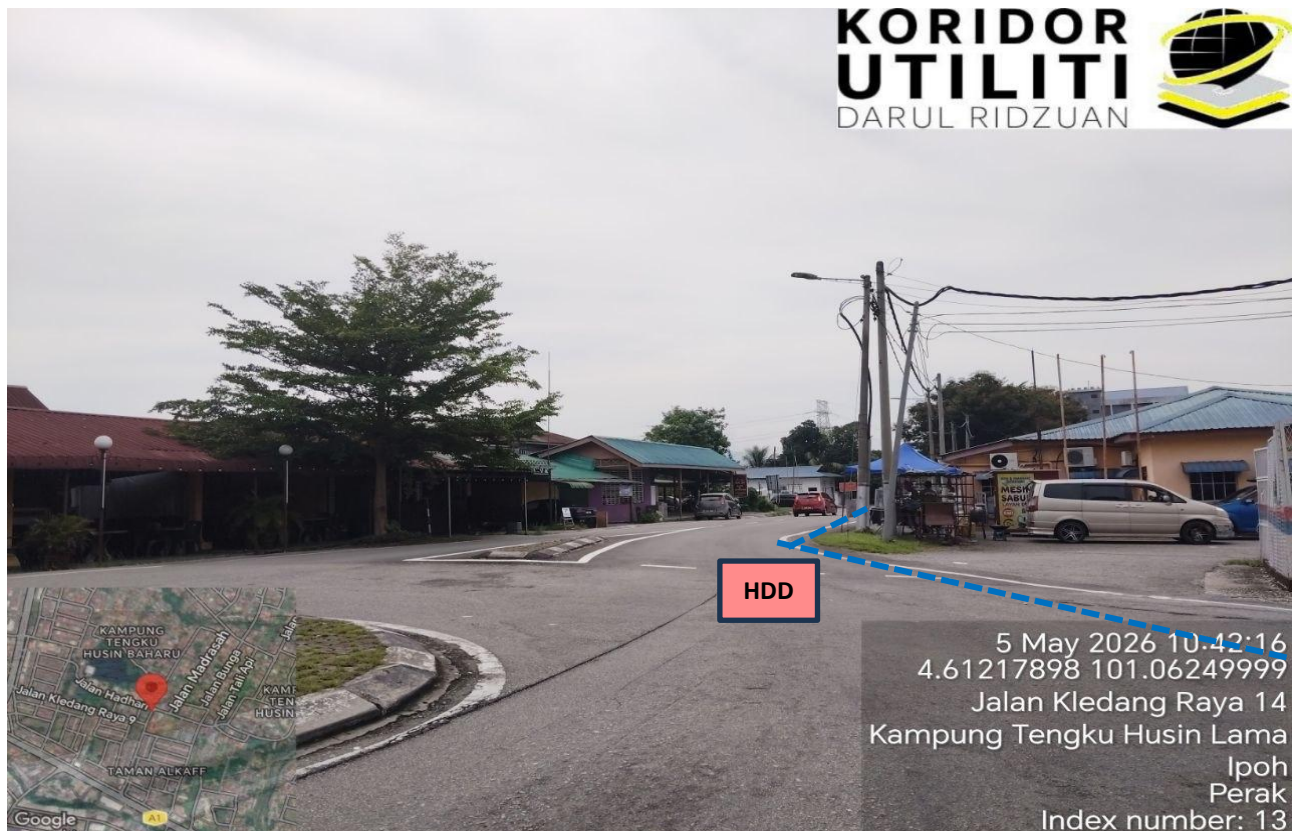
LOKASI KERJA KOREKAN HDD DI JALAN KLEDANG RAYA 14
