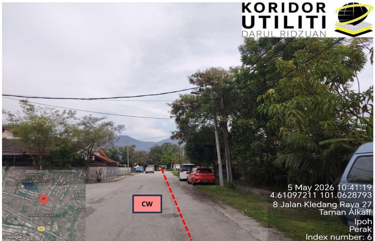
LOKASI KERJA KOREKAN TERBUKA DI JALAN KLEDANG RAYA 27
