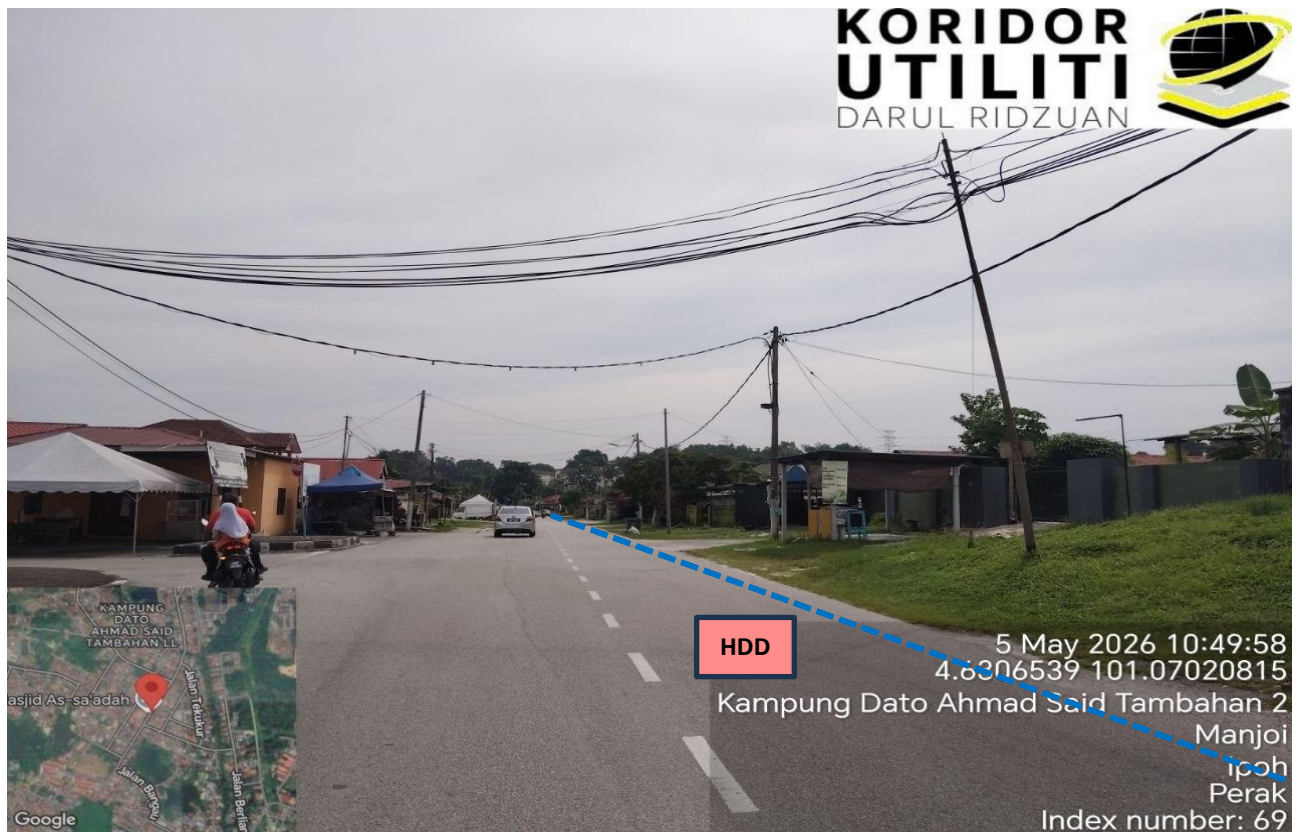
LOKASI KERJA KOREKAN HDD DI JALAN RAJAWALI
