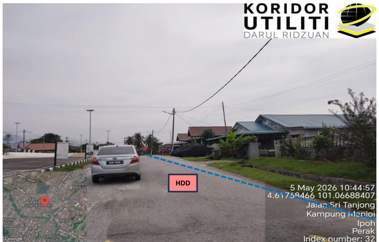
LOKASI KERJA KOREKAN HDD DI JALAN SRI TANJONG
