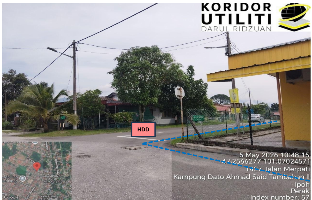
LOKASI KERJA KOREKAN HDD DI JALAN MERPATI
