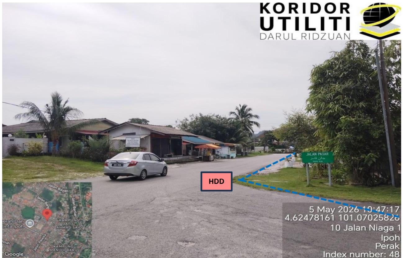
LOKASI KERJA KOREKAN HDD DI JALAN PASAR
