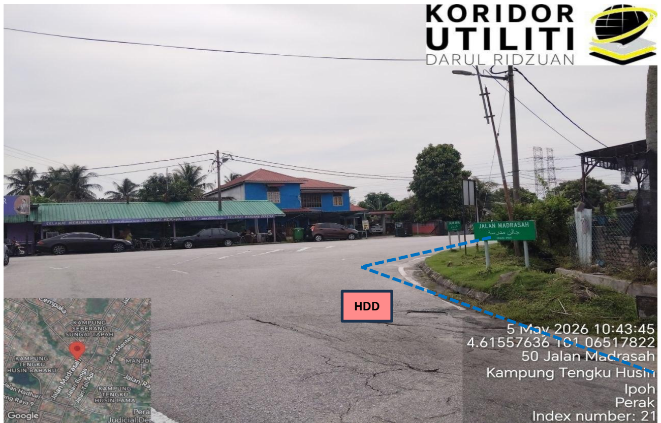
LOKASI KERJA KOREKAN HDD DI JALAN MADRASAH
