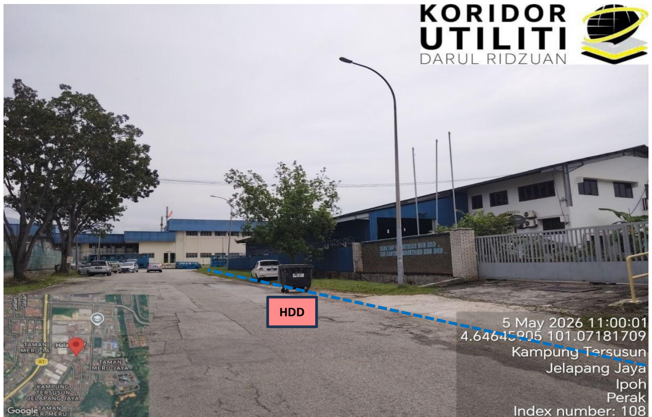
LOKASI KERJA KOREKAN HDD DI HALA JATI MERU 10
