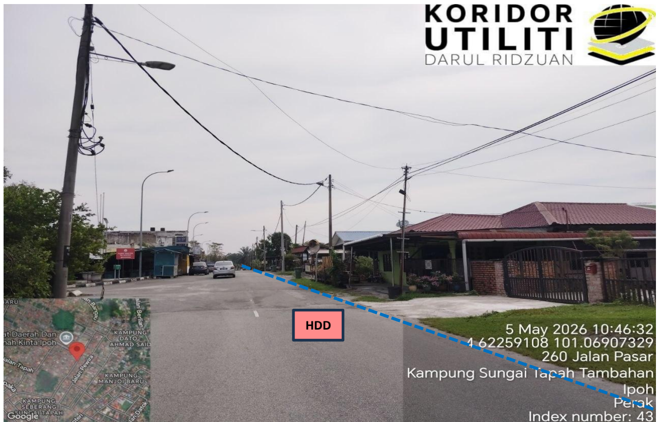
LOKASI KERJA KOREKAN HDD DI JALAN PASAR
