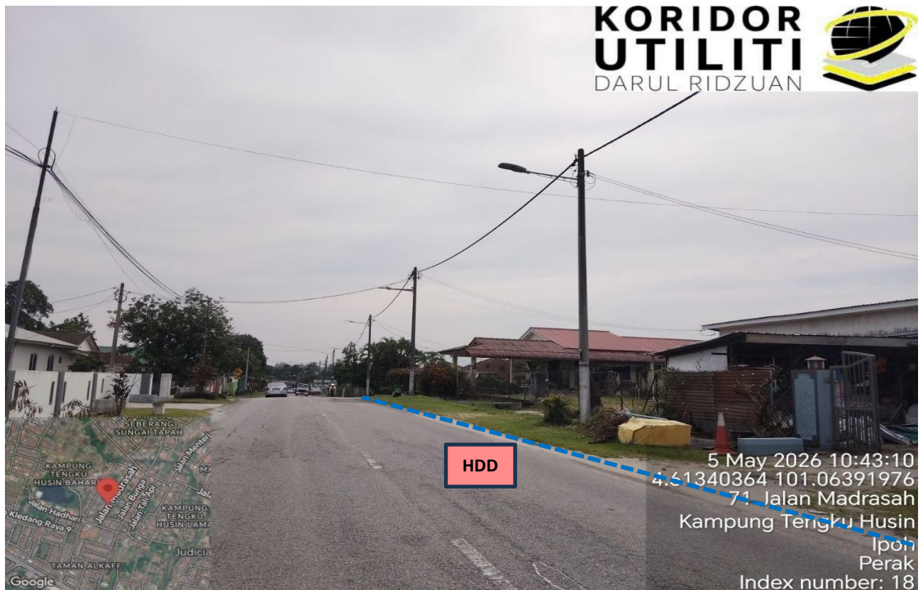
LOKASI KERJA KOREKAN HDD DI JALAN MADRASAH
