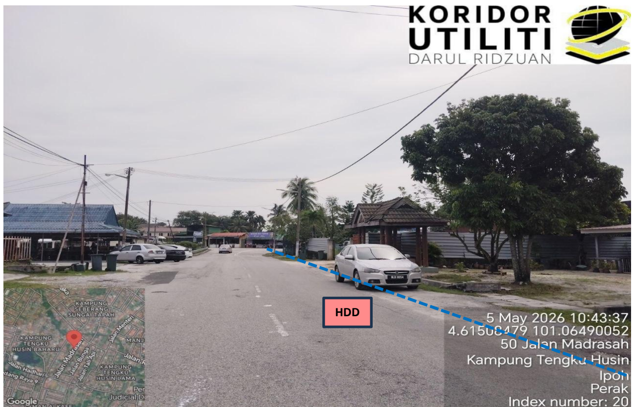
LOKASI KERJA KOREKAN HDD DI JALAN MADRASAH
