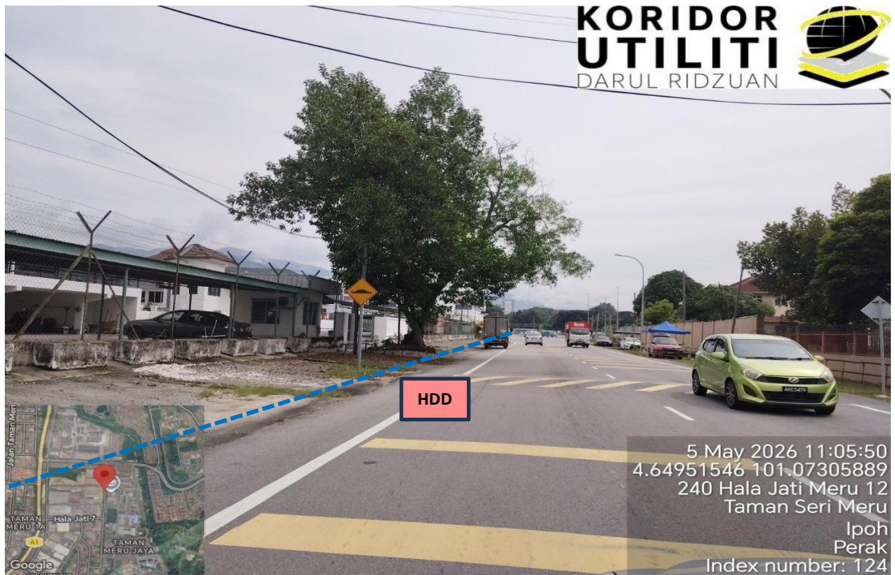
LOKASI KERJA KOREKAN HDD DI HALA JATI 12
