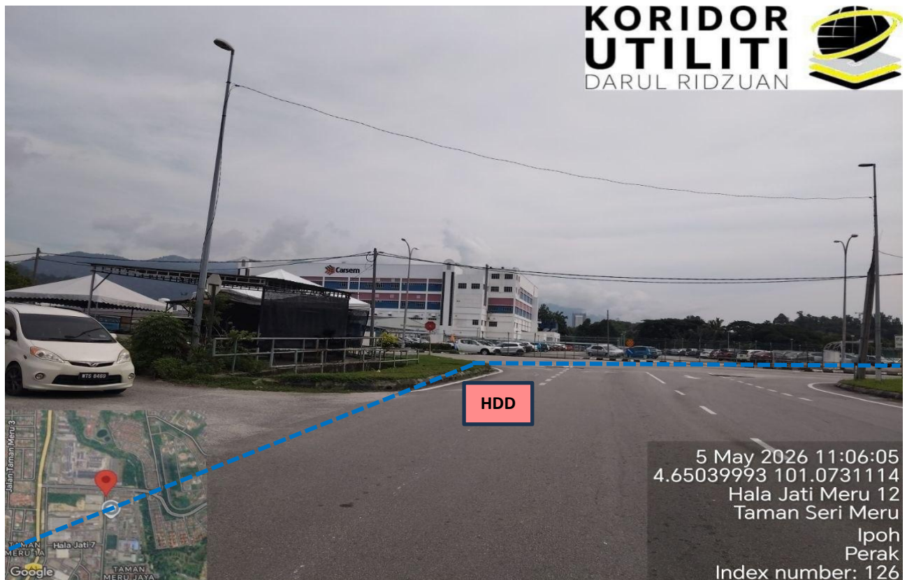
LOKASI KERJA KOREKAN HDD DI HALA JATI 12
