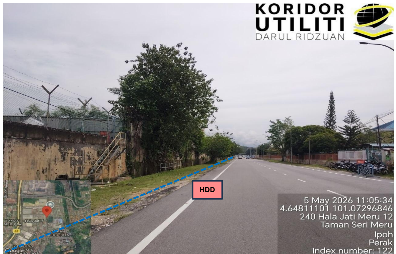
LOKASI KERJA KOREKAN HDD DI HALA JATI 12
