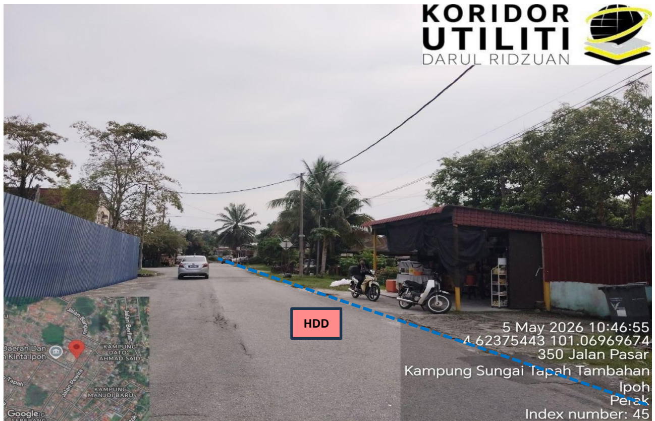
LOKASI KERJA KOREKAN HDD DI JALAN PASAR
