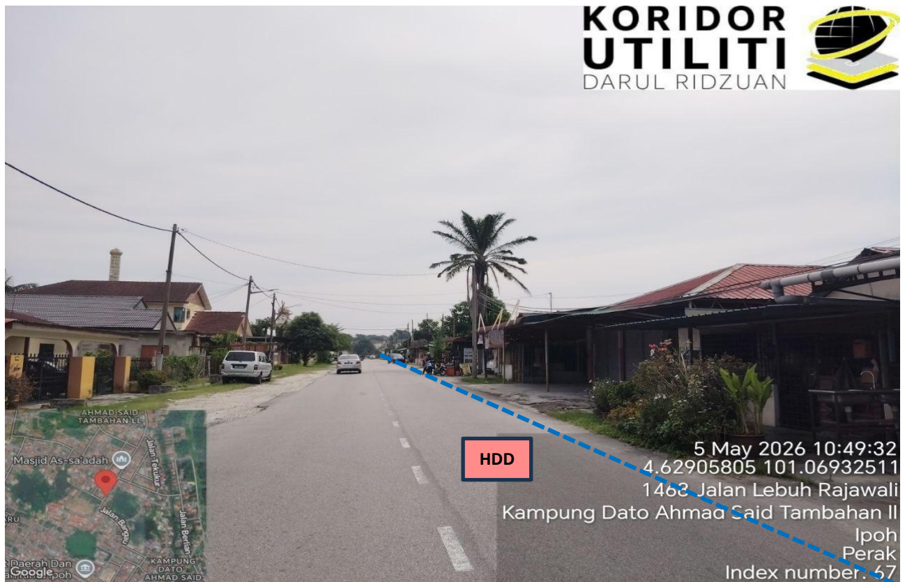
LOKASI KERJA KOREKAN HDD DI JALAN RAJAWALI
