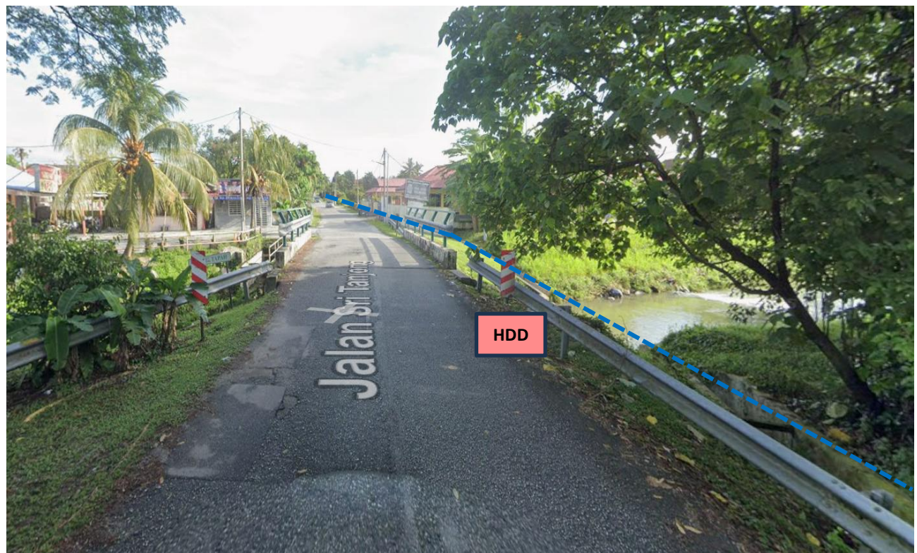
LOKASI KERJA KOREKAN HDD DI JALAN SRI TANJONG
