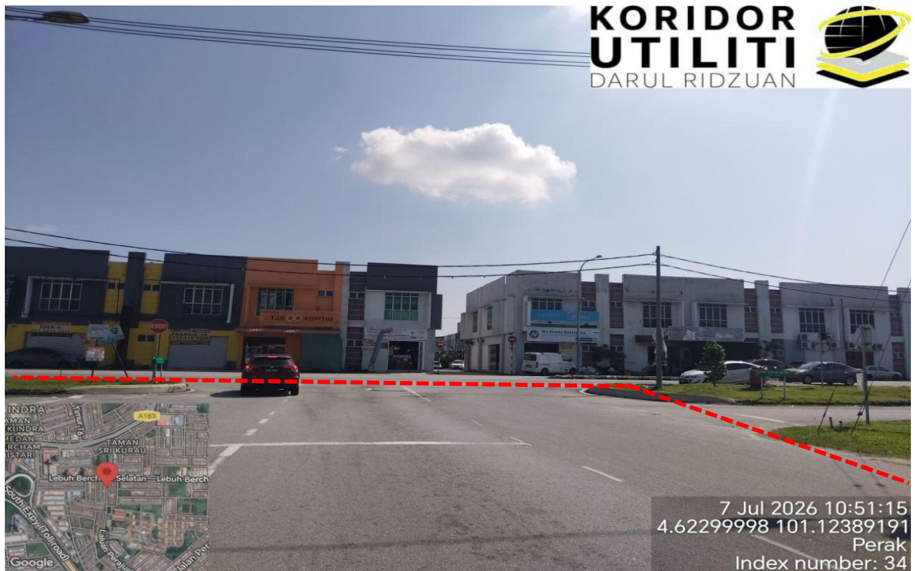
LOKASI KERJA KOREKAN HDD DI LALUAN PRAJURIT 1
