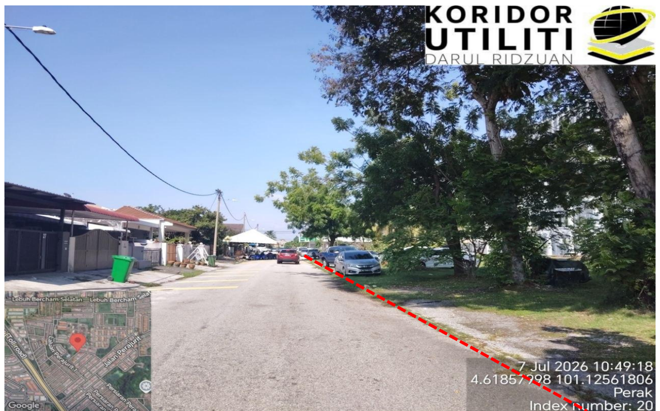
LOKASI KERJA KOREKAN HDD DI LINTASAN PRAJURIT 10
