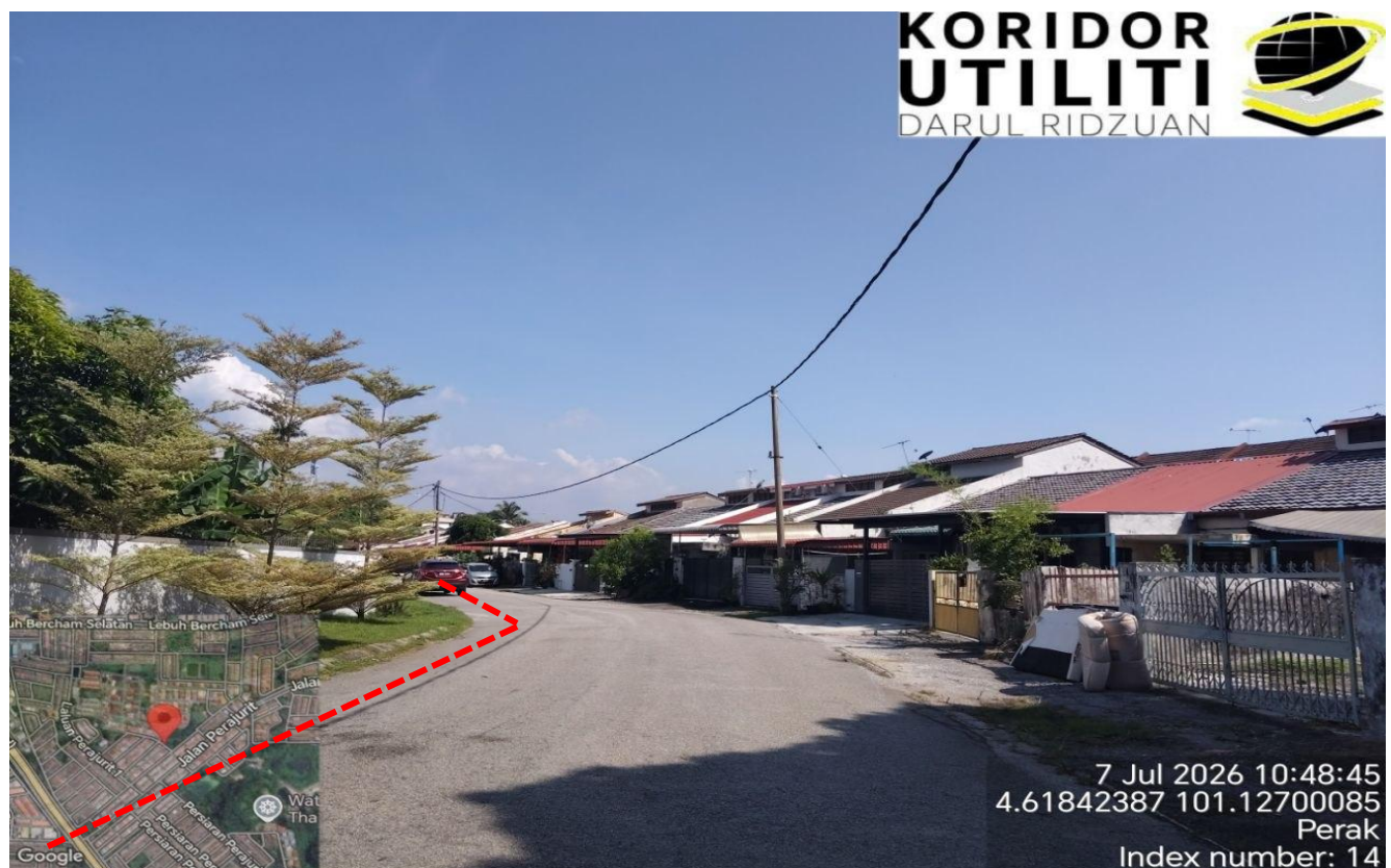
LOKASI KERJA KOREKAN HDD DI LENGKUK PRAJURIT
