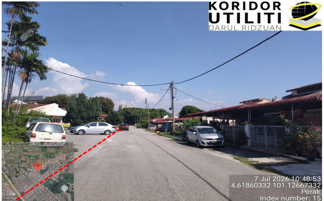
LOKASI KERJA KOREKAN HDD DI LENGKUK PRAJURIT
