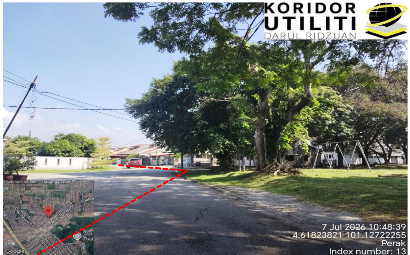
LOKASI KERJA KOREKAN HDD DI LENGKUK PRAJURIT
