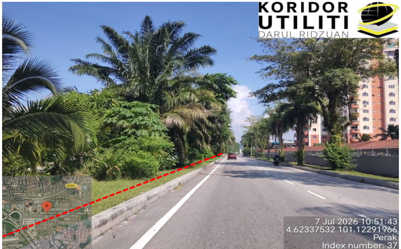
LOKASI KERJA KOREKAN HDD DI LEBUH BERCHAM SELATAN
