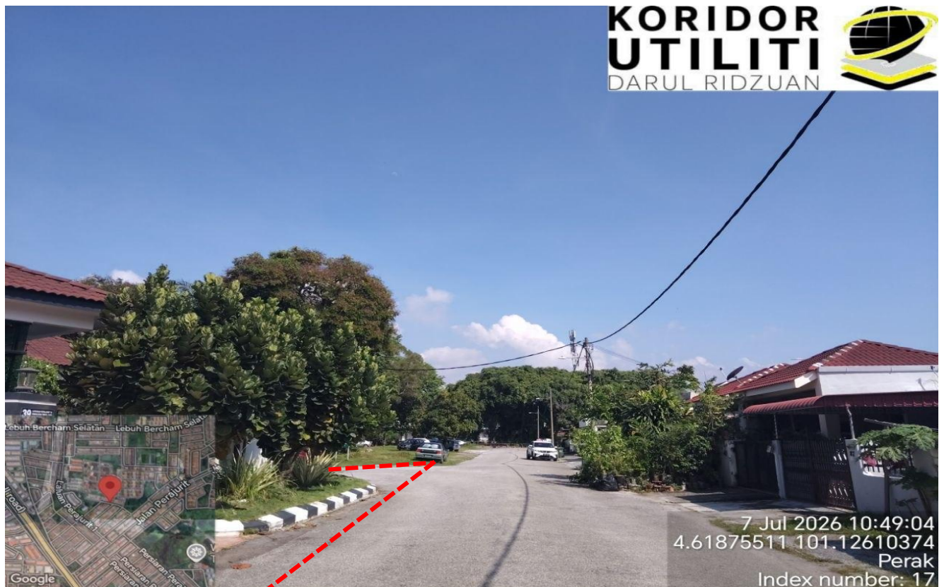
LOKASI KERJA KOREKAN HDD DI LENGKUK PRAJURIT
