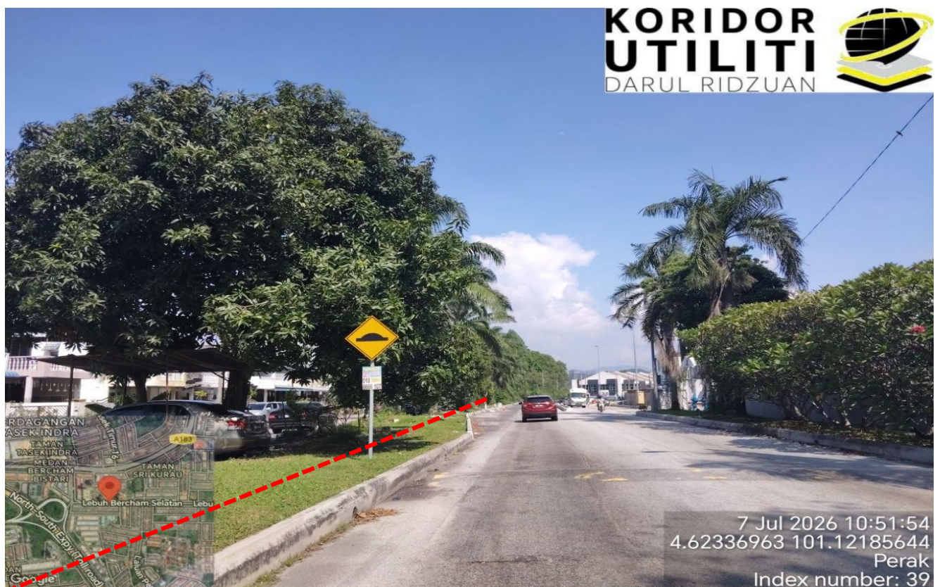
LOKASI KERJA KOREKAN HDD DI LEBUH BERCHAM SELATAN
