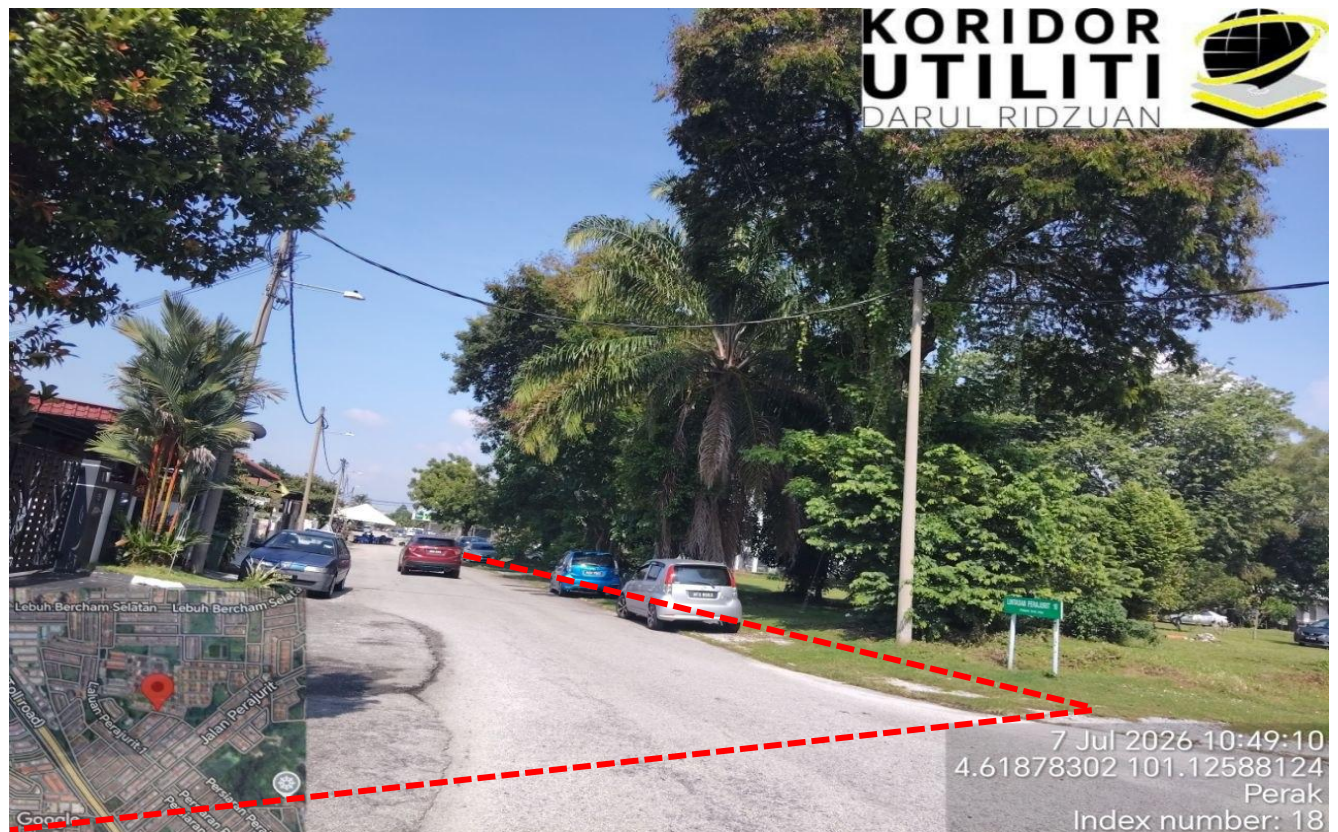
LOKASI KERJA KOREKAN HDD DI LENGKUK PRAJURIT
