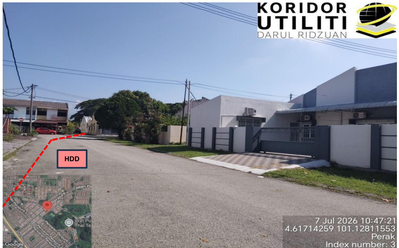
LOKASI KERJA KOREKAN HDD DI LEBUH PRAJURIT 2
