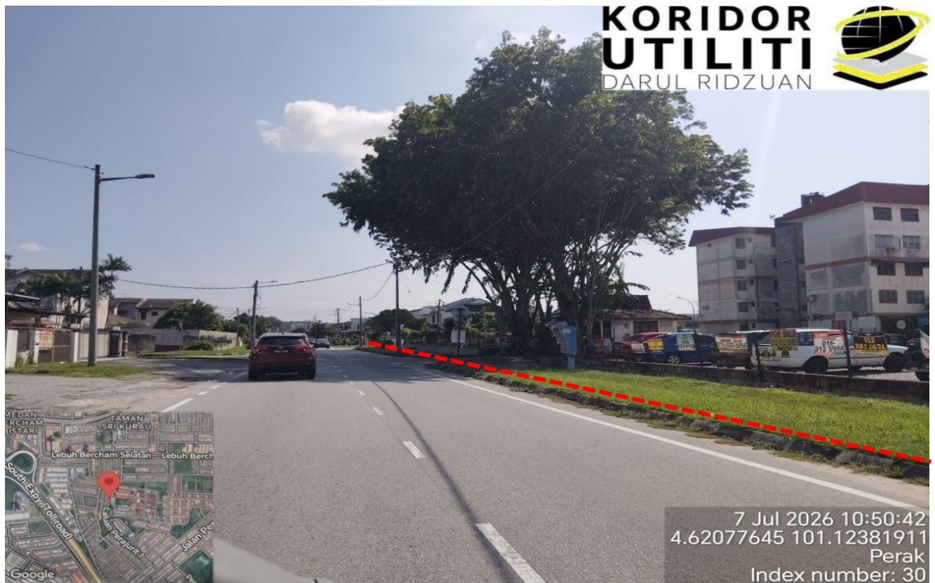
LOKASI KERJA KOREKAN HDD DI LALUAN PRAJURIT 1
