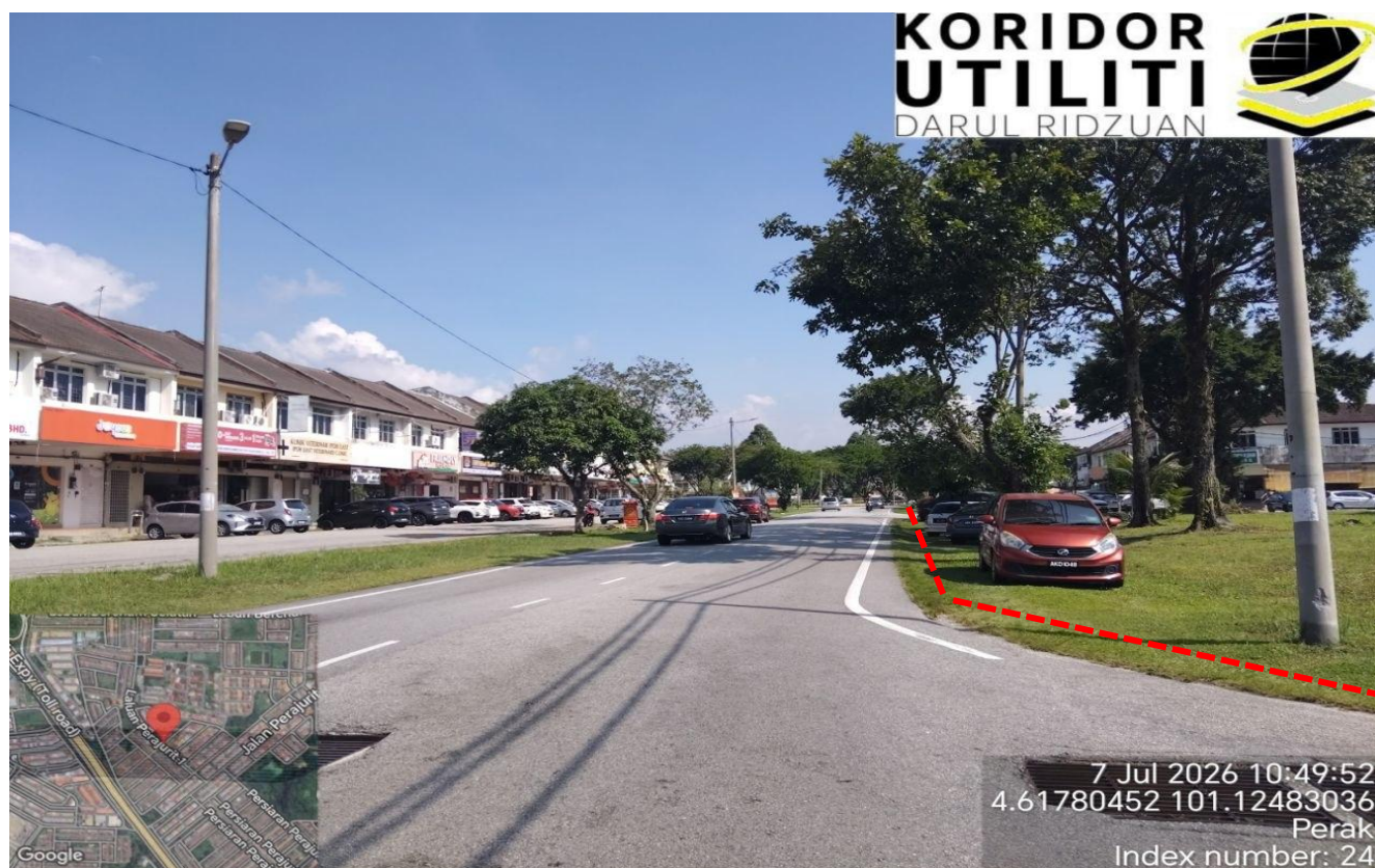
LOKASI KERJA KOREKAN HDD DI LALUAN PRAJURIT 1
