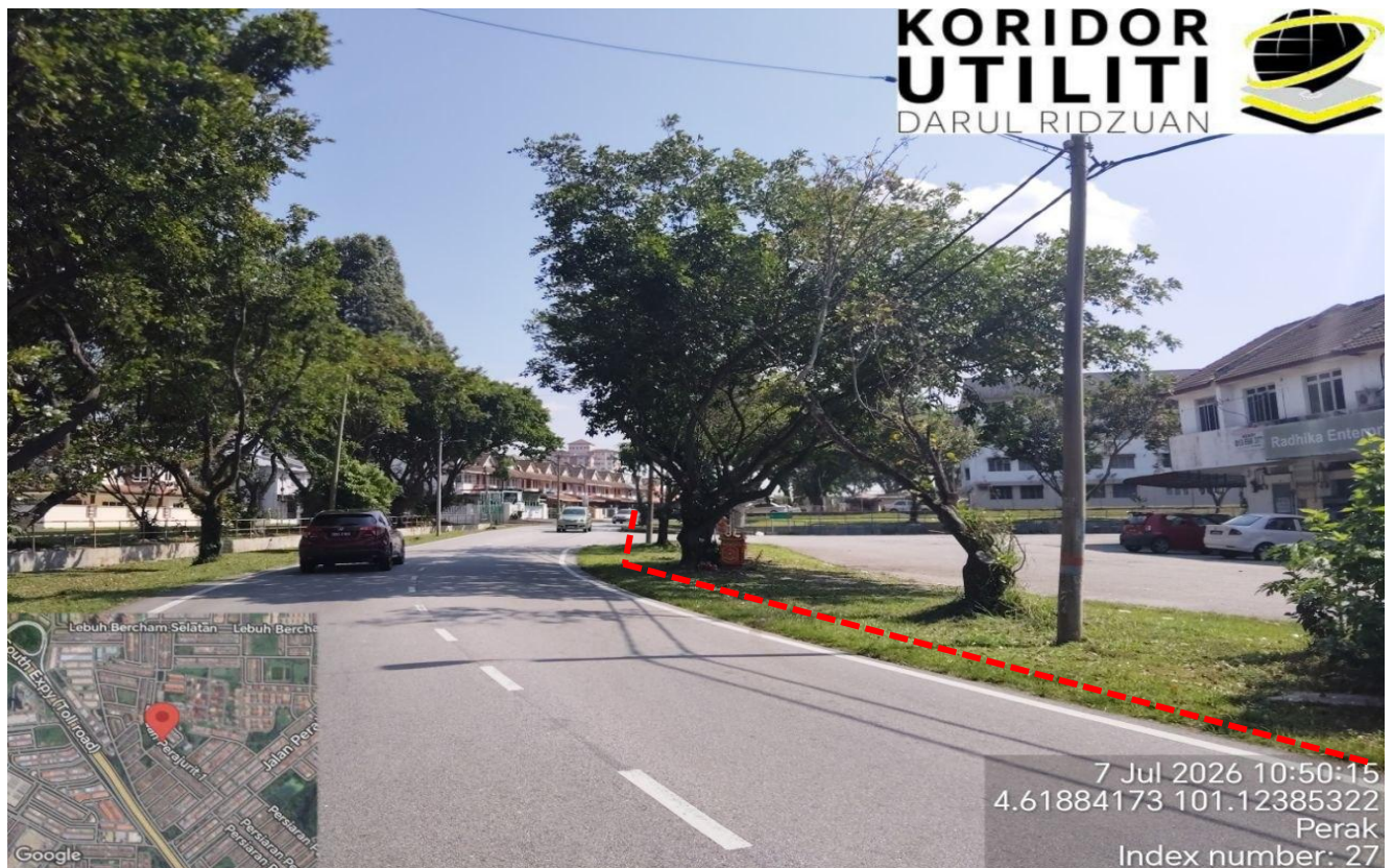
LOKASI KERJA KOREKAN HDD DI LALUAN PRAJURIT 1
