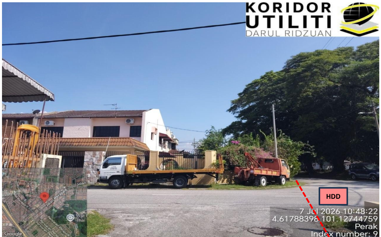
LOKASI KERJA KOREKAN HDD TRENCHING DI LEBUH PRAJURIT 3
