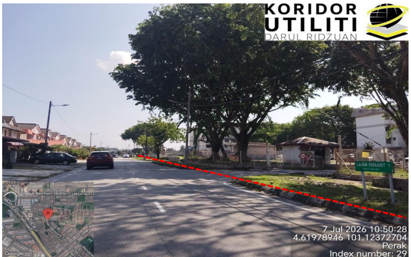
LOKASI KERJA KOREKAN HDD DI LALUAN PRAJURIT 1
