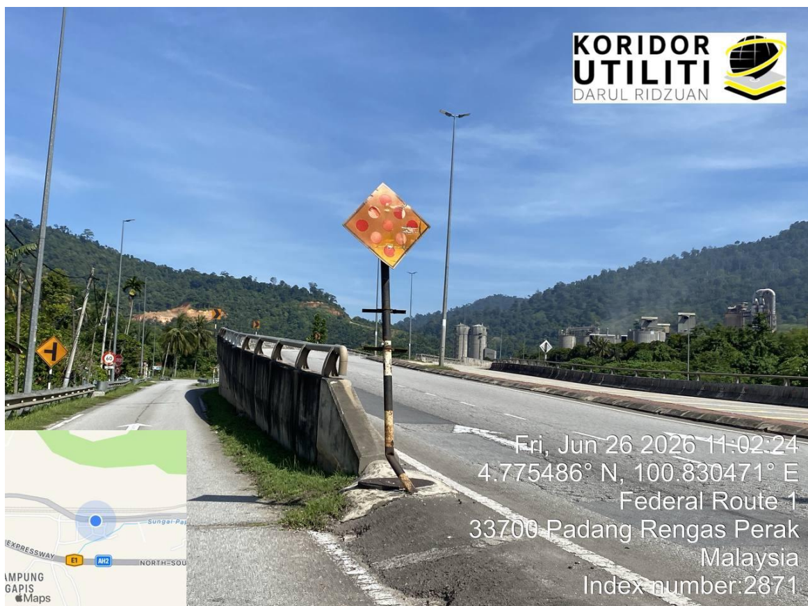
LOKASI DI JALAN IPOH – BUTTERWORTH (FT001)
