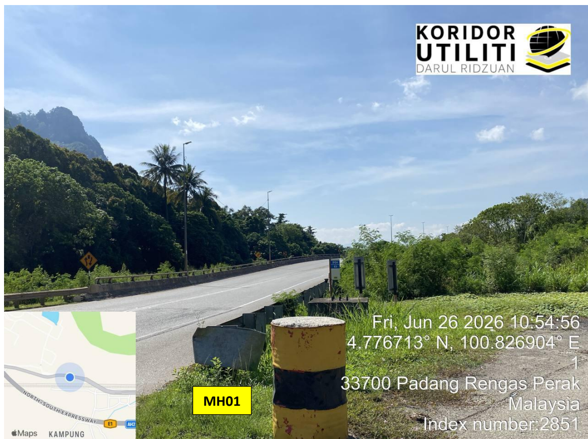
LOKASI DI JALAN IPOH – BUTTERWORTH (FT001)
