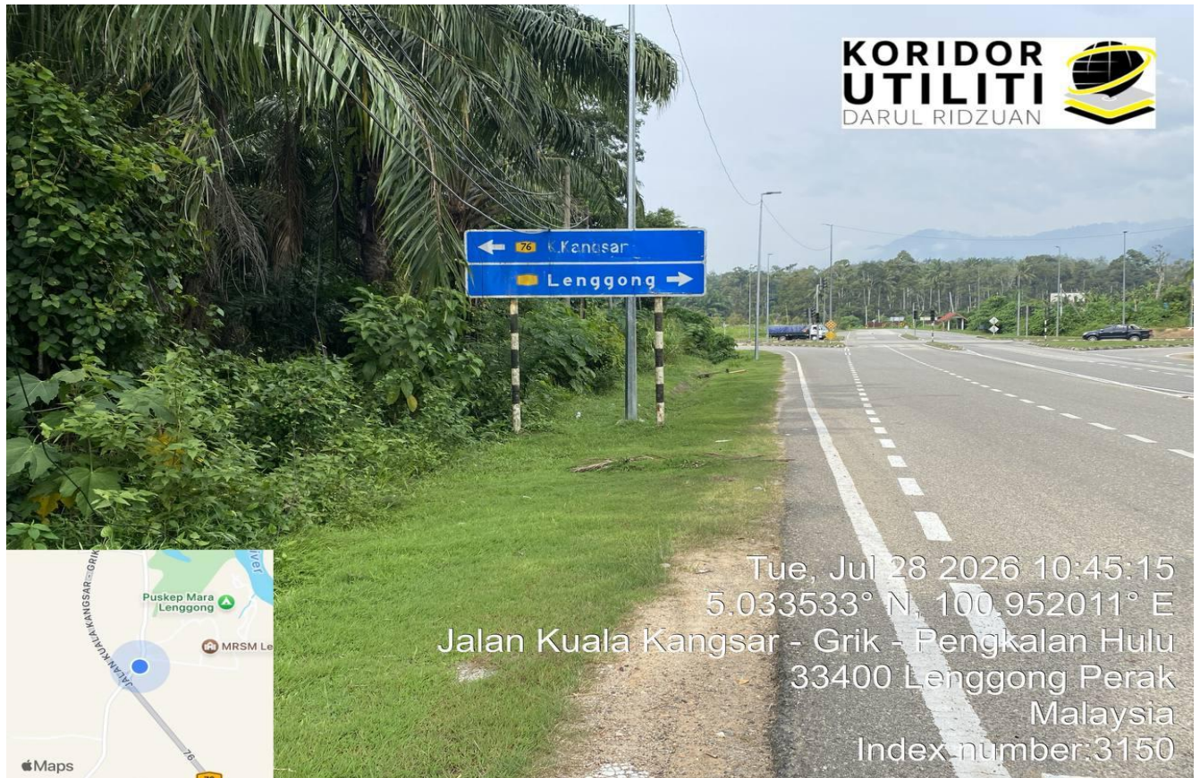
LOKASI DI JALAN LAMA SAUK – LENGGONG (A078)
