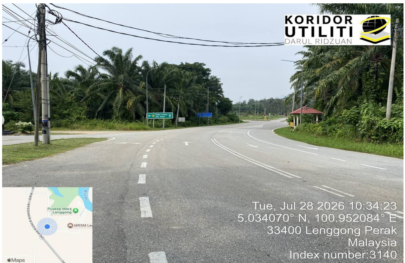
LOKASI DI JALAN LAMA SAUK – LENGGONG (A078)
