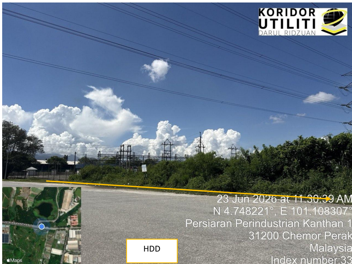
LOKASI DI PERSIARAN PERINDUSTRIAN KANTHAN 1
