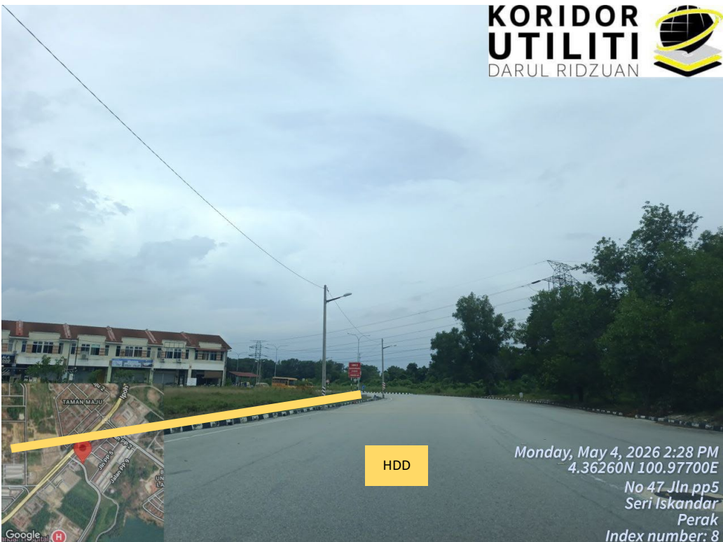
LOKASI JAJARAN HDD DI JALAN SERI ISKANDAR PERAK
