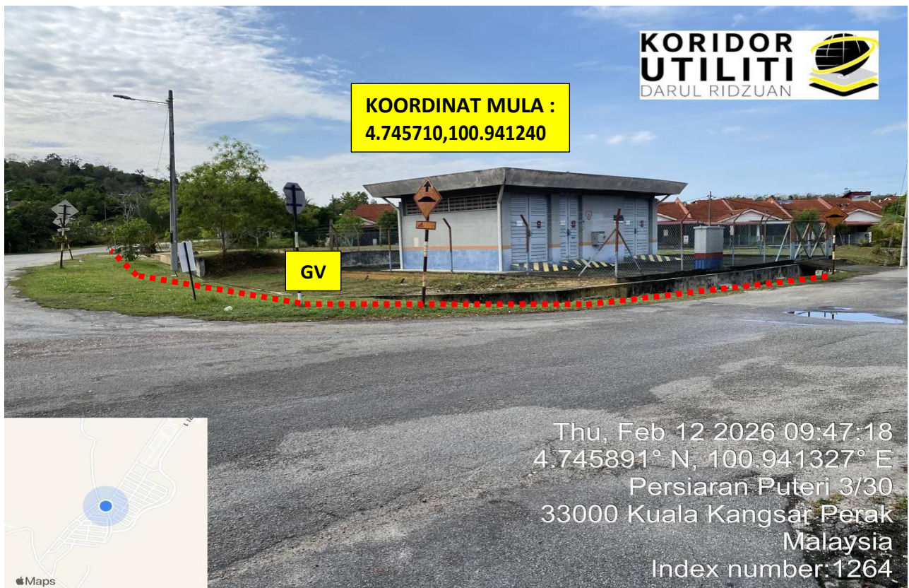
LOKASI DI PENCAWANG ELEKTRIK SEDIA ADA
