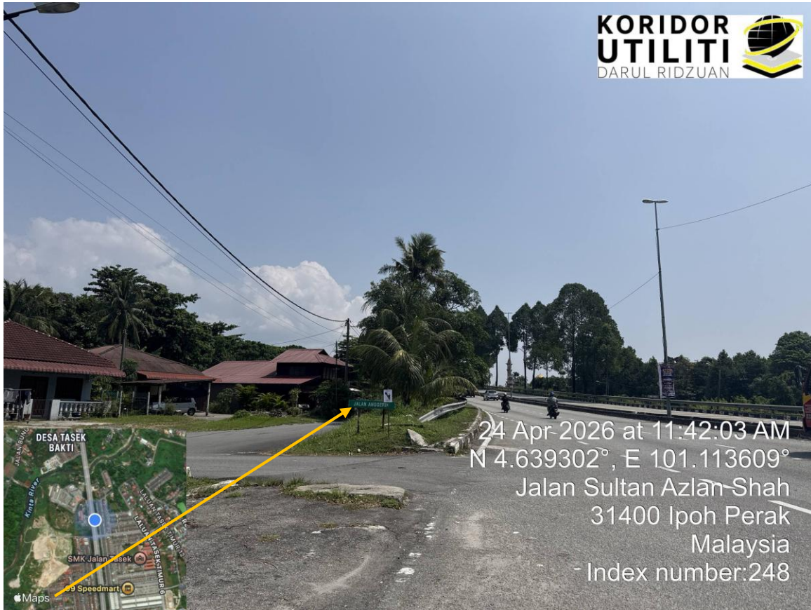
HDD MASUK KE JALAN SELIAAN MBI
