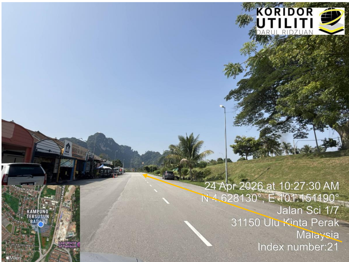
LOKASI DI JALAN SCI 1/2
