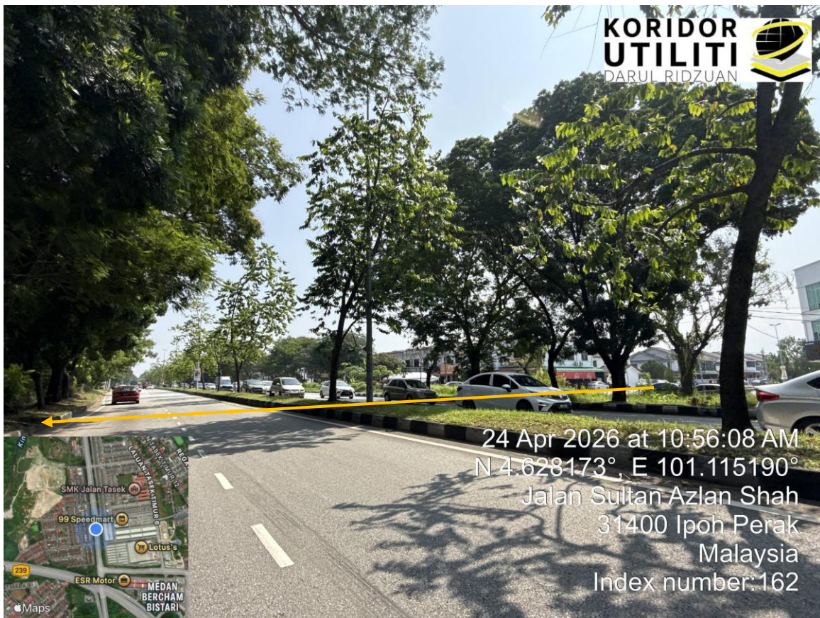
HDD MERENTASI JALAN SULTAN AZLAN SHAH FT01 (JKR)
