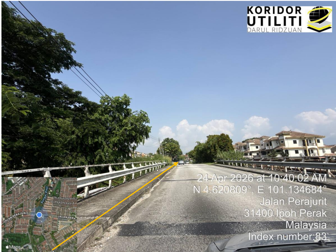
TERLIBAT JPS SUNGAI PINJI
