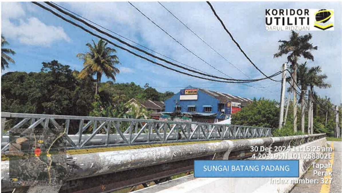
KAEDAH HDD DIGUNAKAN BAGI MERENTASI SUNGAI
