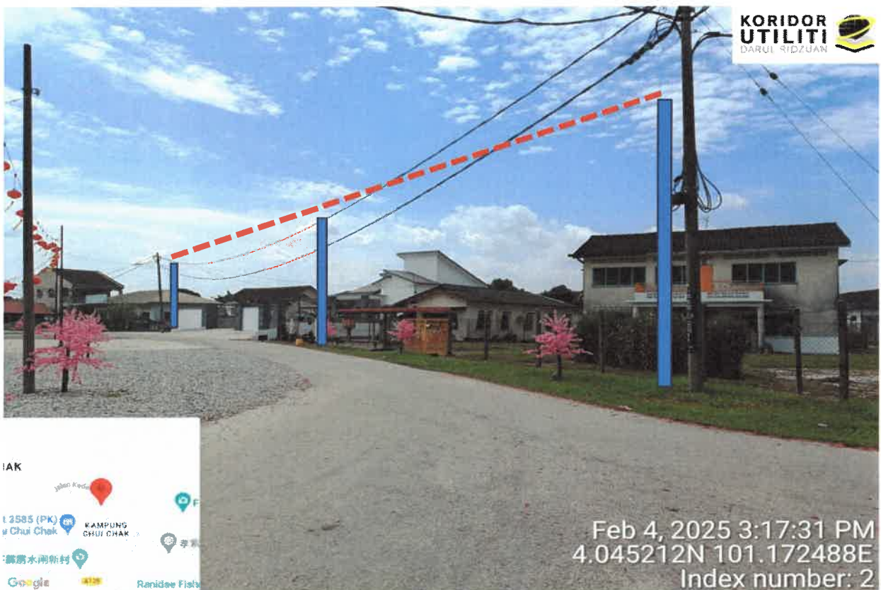
LOKASI DI JALAN PAHANG
