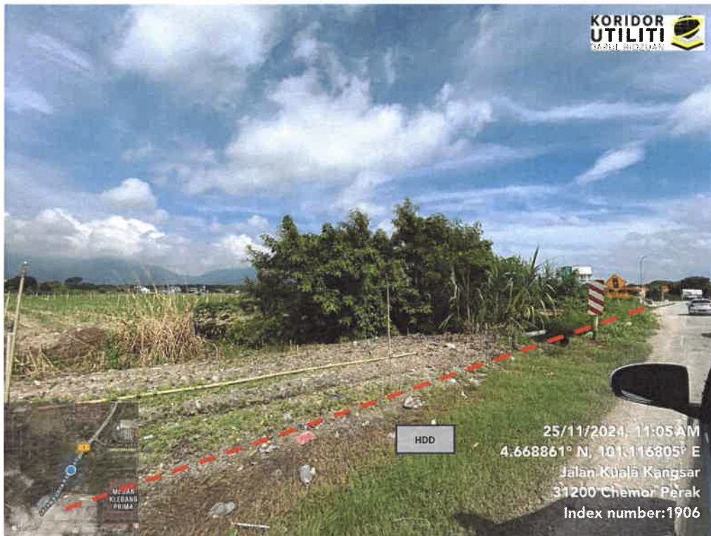
AJARAN KERJA HDD DI JALAN KUALA KANGSAR
