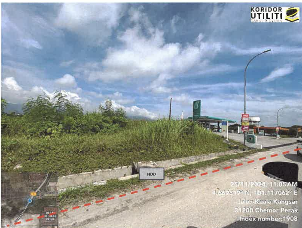
AJARAN KERJA HDD DI JALAN KUALA KANGSAR
