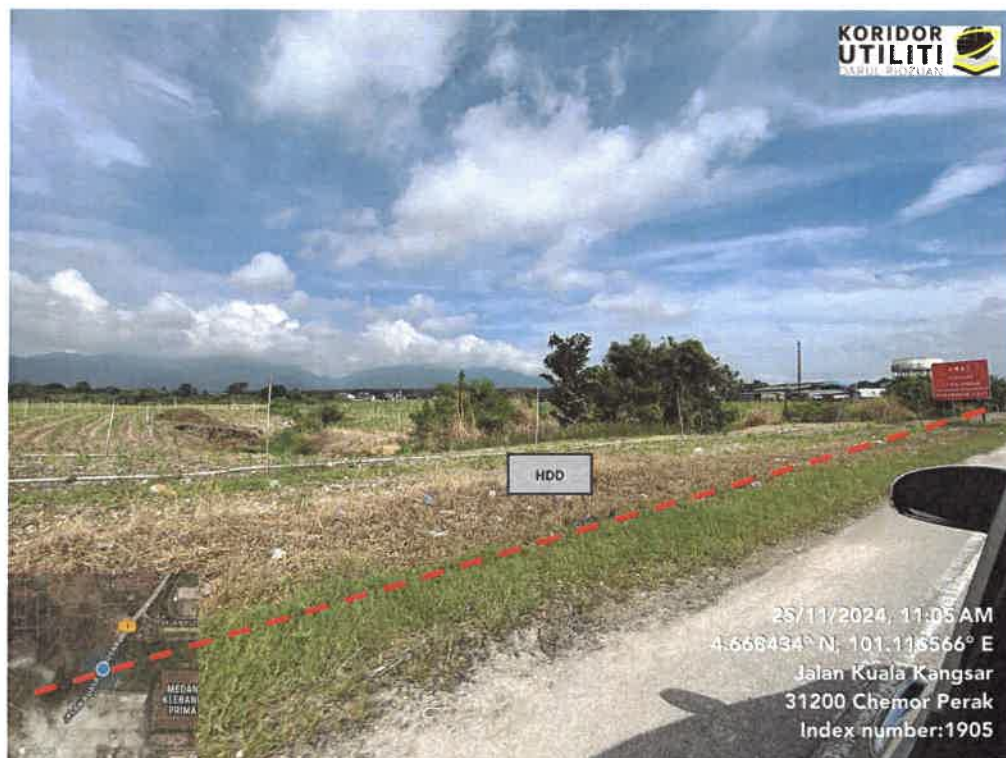
JAJARAN KERJA HDD DI JALAN KUALA KANGSAR
