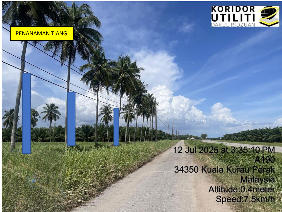
LOKASI DI JALAN GULA
