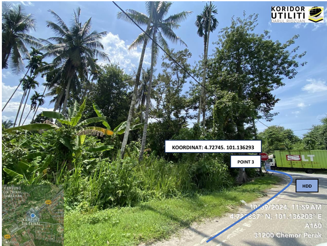
LOKASI KOREKAN HDD DI JALAN CHEMOR – ULU KUANG (JALAN MILIK JKR)
