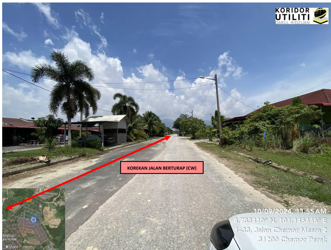
LOKASI KOREKAN JALAN BERTURAP (CW) DI JALAN CHEMOR MESRA (JALAN MILIK MBI)
