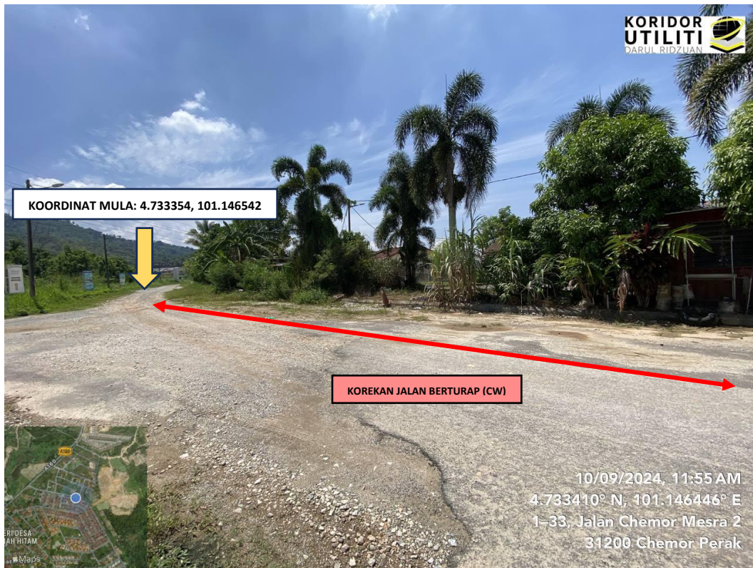
LOKASI KOREKAN JALAN BERTURAP (CW) DI JALAN CHEMOR MESRA (JALAN MILIK MBI)
