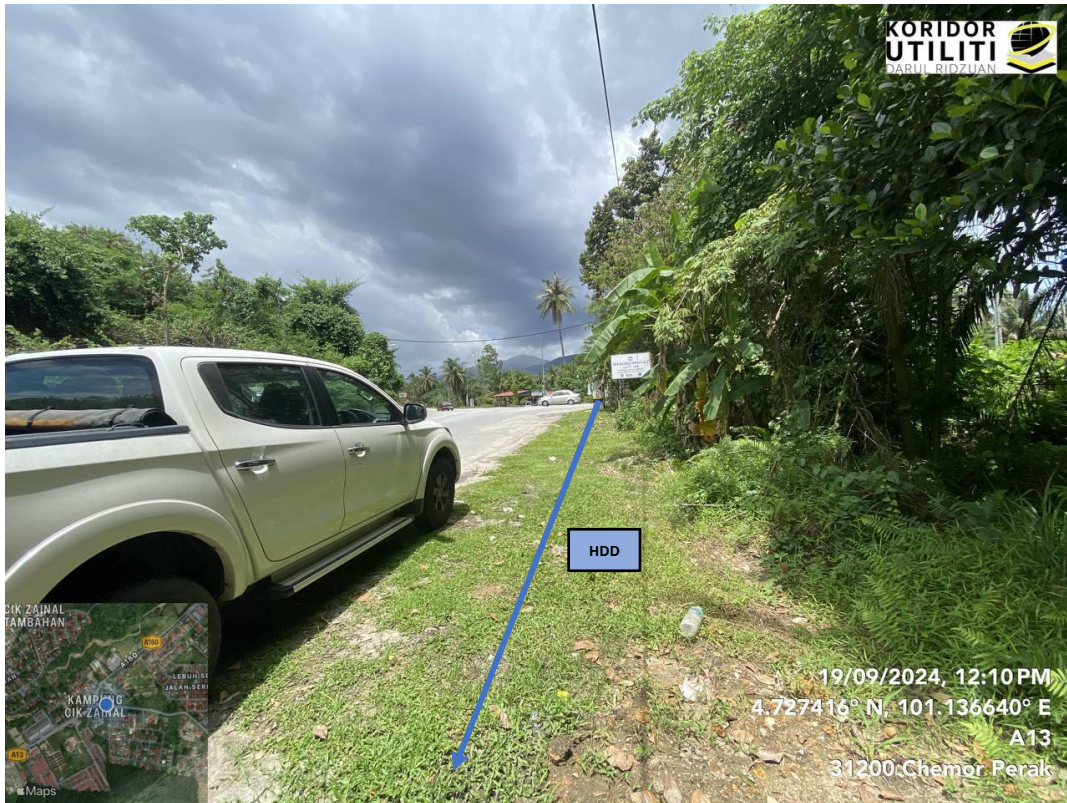
LOKASI KOREKAN HDD DI JALAN IPOH – TAMBUN (JALAN MILIK JKR)
