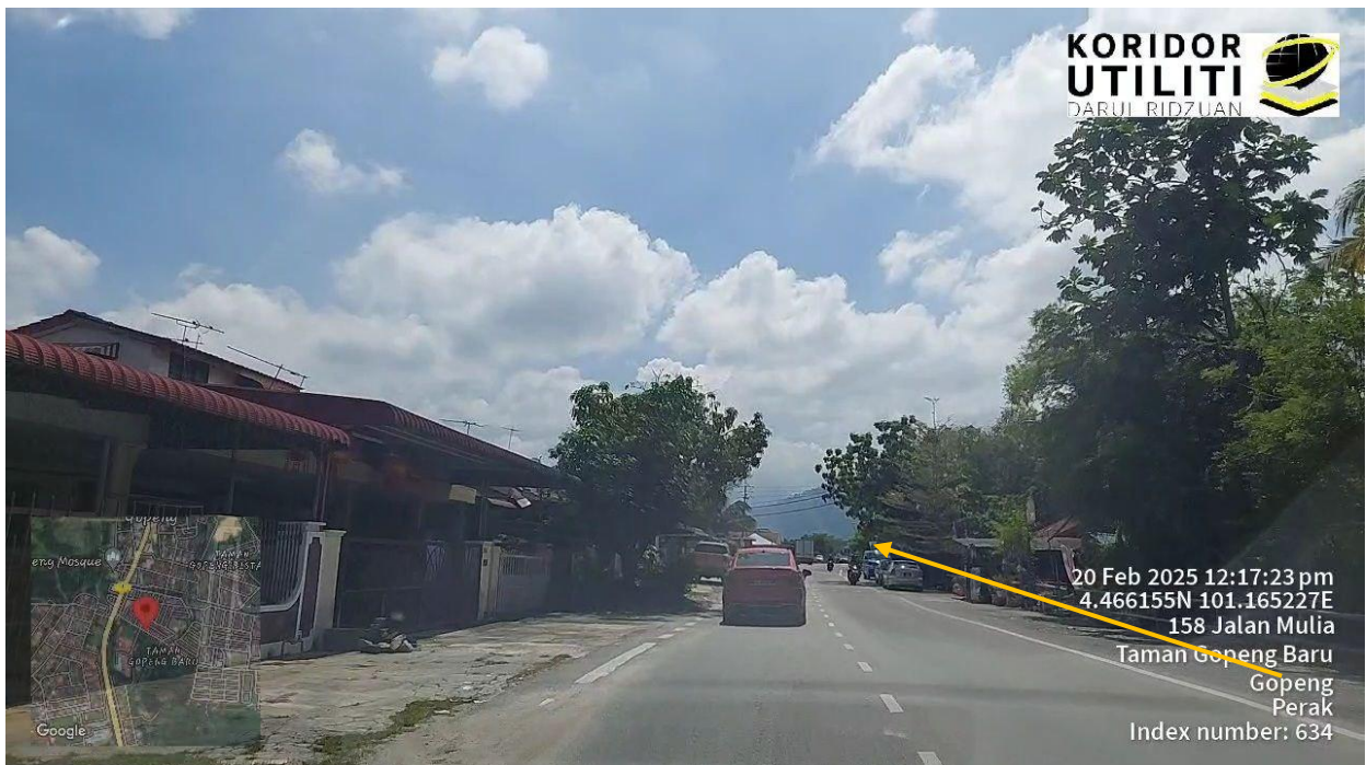
JAJARAN PEMASANGAN UTILITI DI JAJARAN SEBELAH KANAN
