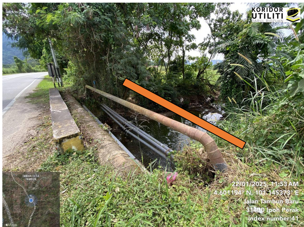
JAJARAN KAEDAH GI DI JALAN TAMBUN (Tambatan kabel akan dibuat menggunakan kaedah GI)
