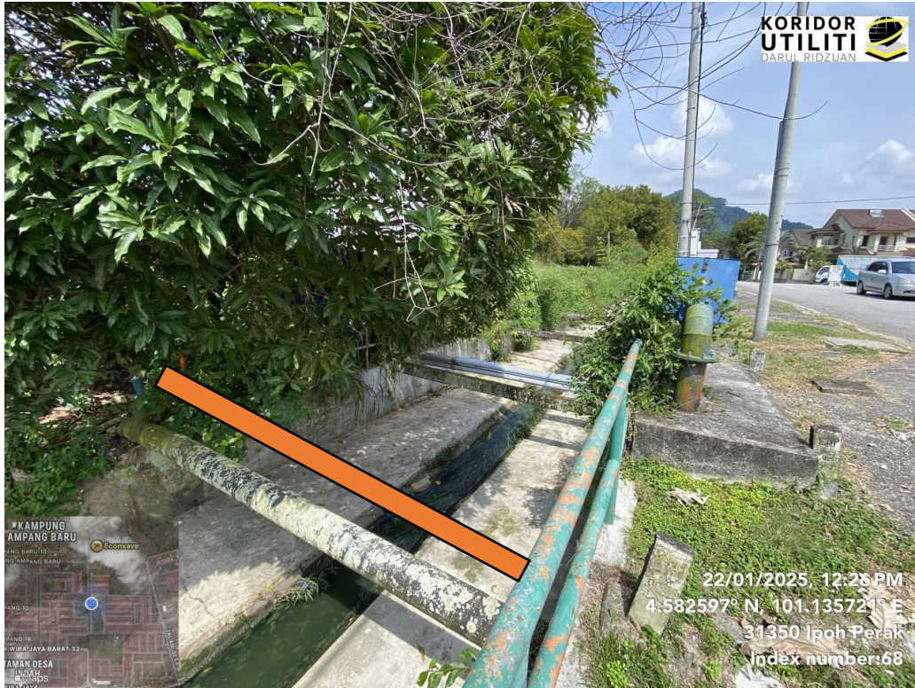
JAJARAN KAEDAH GI DI JALAN TAMBUN (Tambatan kabel akan dibuat menggunakan kaedah GI)
