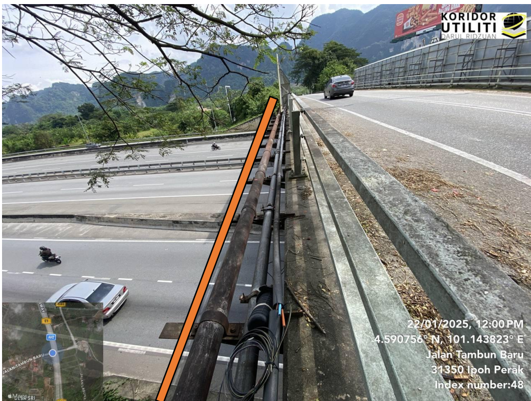
AJARAN KAEDAH GI DI JALAN TAMBUN (Crossing: Struktur penampung kabel perlu dibuat)
