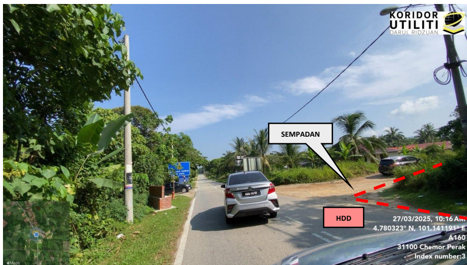
JAJARAN KERJA HDD DI JALAN CHEMOR – ULU KUANG (A160) (Sempadan masuk ke Kampung Ulu Kuang, Chemor)
