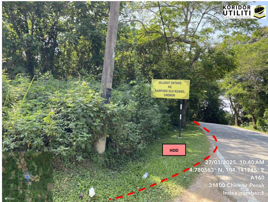
JAJARAN KERJA HDD DI JALAN CHEMOR – ULU KUANG (A160)
