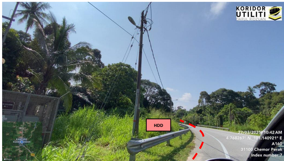
JAJARAN KERJA HDD DI JALAN CHEMOR – ULU KUANG (A160)
