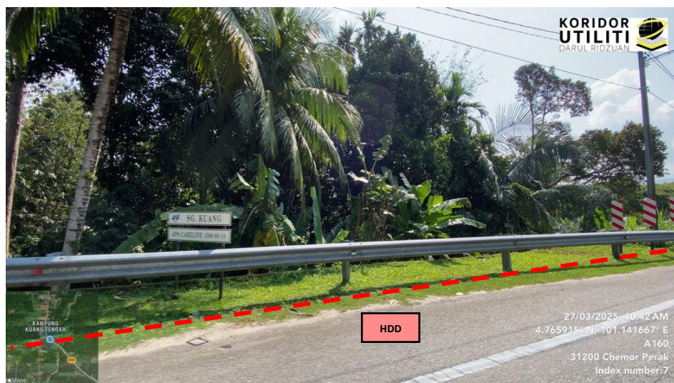
JAJARAN KERJA HDD DI JALAN CHEMOR – ULU KUANG (A160) (Kerja HDD melalui Sungai Kuang)
