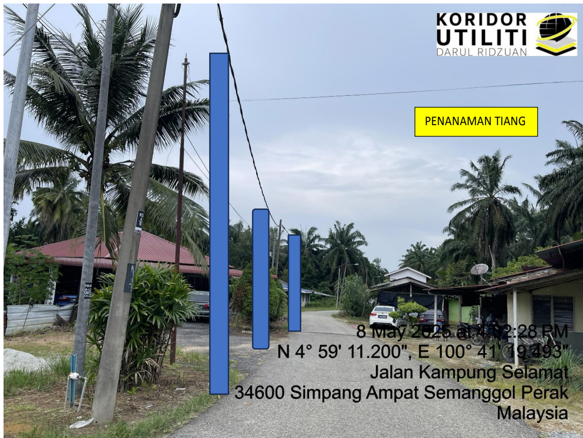
LOKASI DI JALAN KAMPUNG SELAMAT
