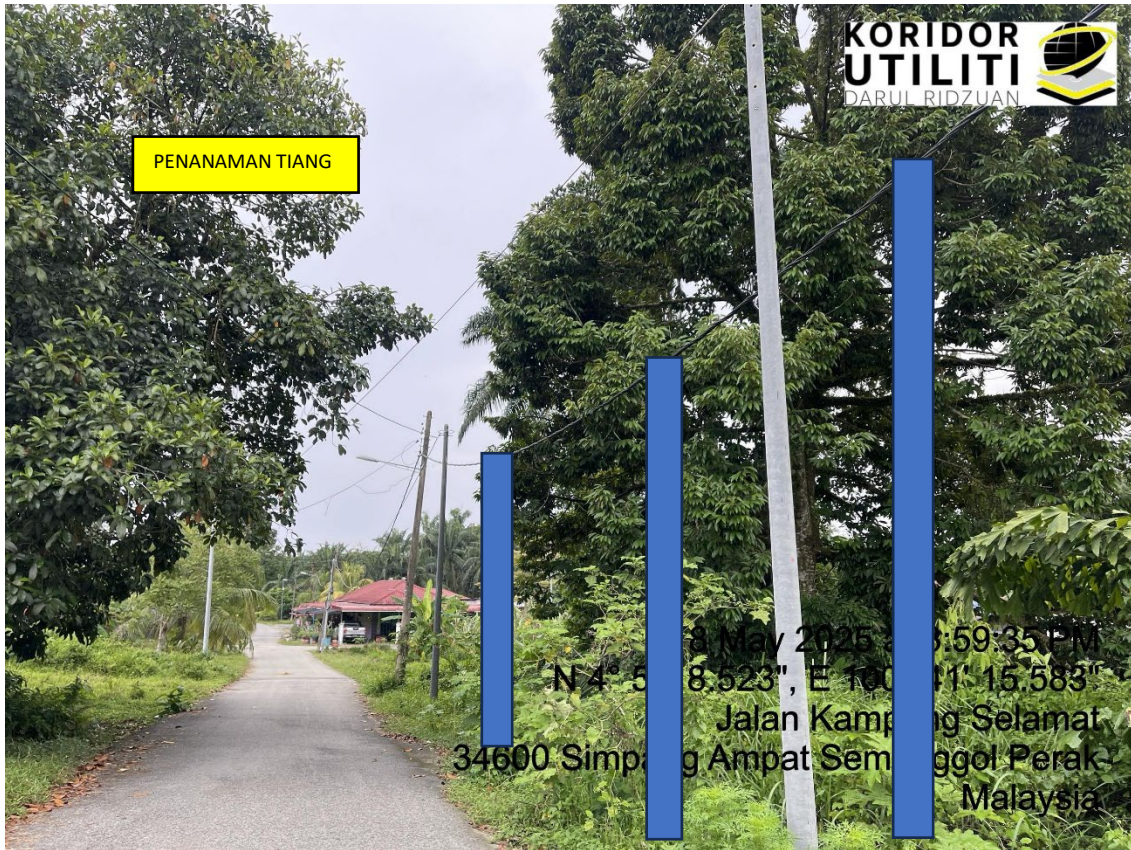
LOKASI DI JALAN KAMPUNG SELAMAT
