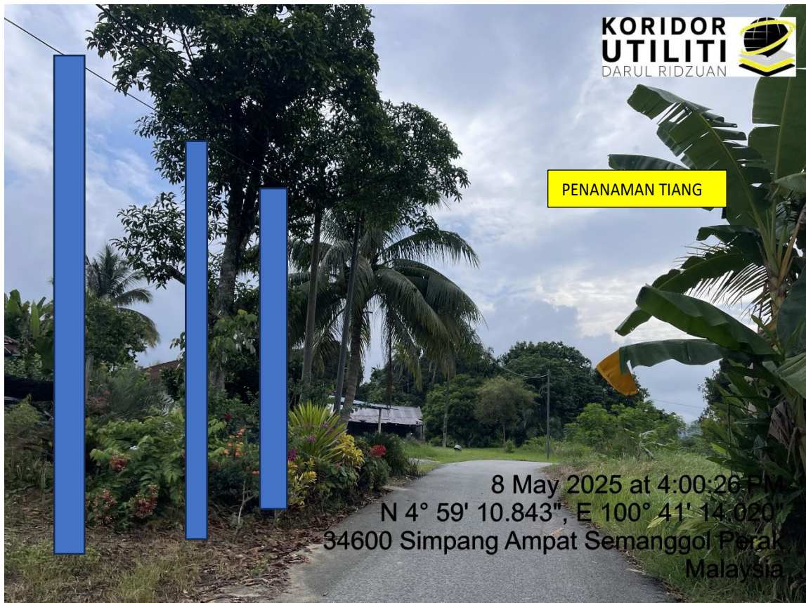
LOKASI DI JALAN KAMPUNG SELAMAT
