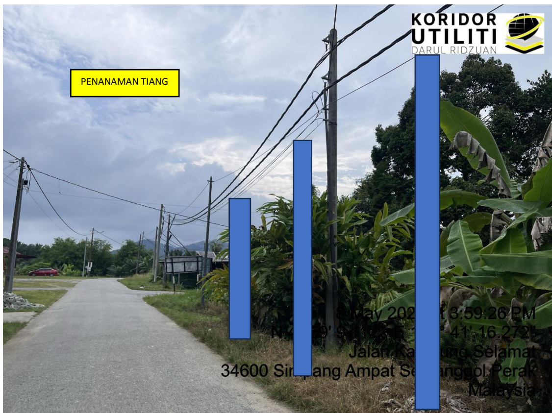
LOKASI DI JALAN KAMPUNG SELAMAT
