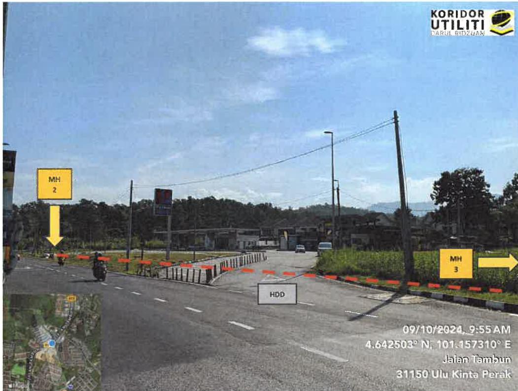
LOKASI CADANGAN MANHOLE BARU 3 DAN KERJA HDD DI JALAN IPOH – TAMBUN (A013)
