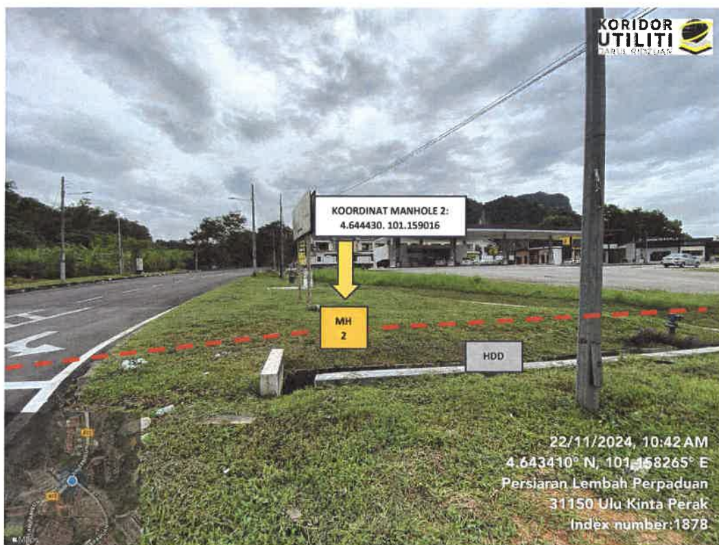
LOKASI CADANGAN MANHOLE BARU 2 DAN KERJA HDD DI JALAN IPOH – TAMBUN (A013)
