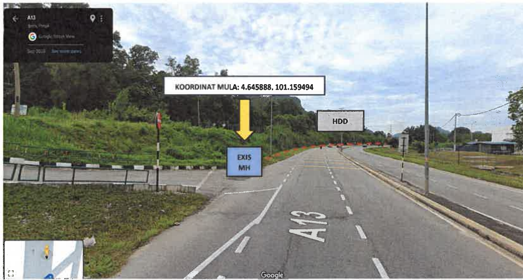
KOORDINAT MULA KERJA HDD DI JALAN IPOH – TAMBUN (A013) (NEW JOINT DI MANHOLE SEDIA ADA)
