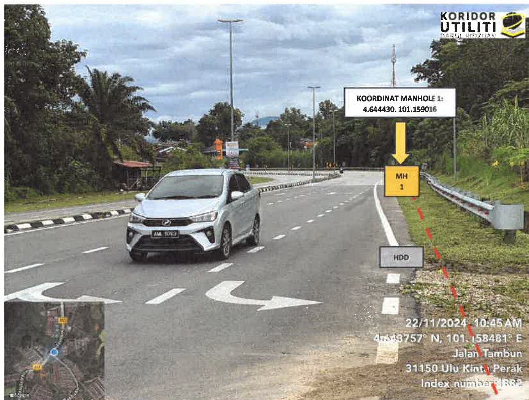
LOKASI CADANGAN MANHOLE BARU 1 DAN KERJA HDD DI JALAN IPOH – TAMBUN (A013)
