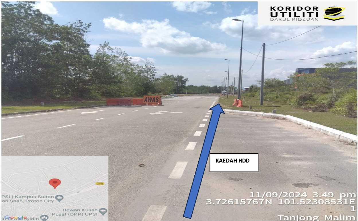
Kordinat: 3.72615767 101.52308531 Lokasi:Jalan Jelawai 5
