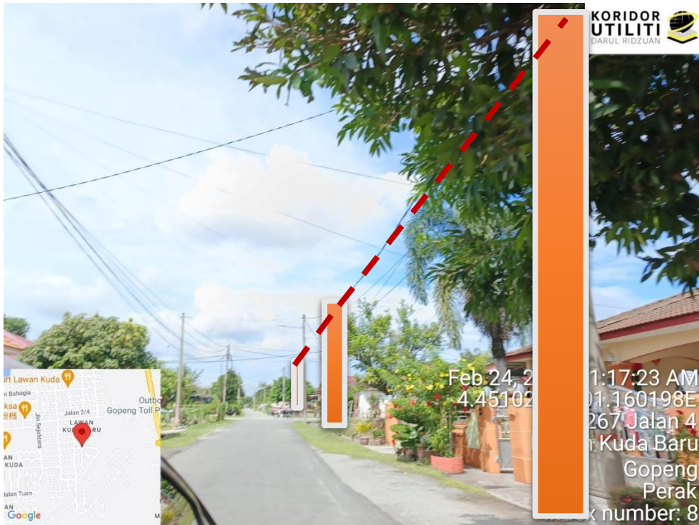
LOKASI DI JALAN 4, PENANAMAN TIANG
