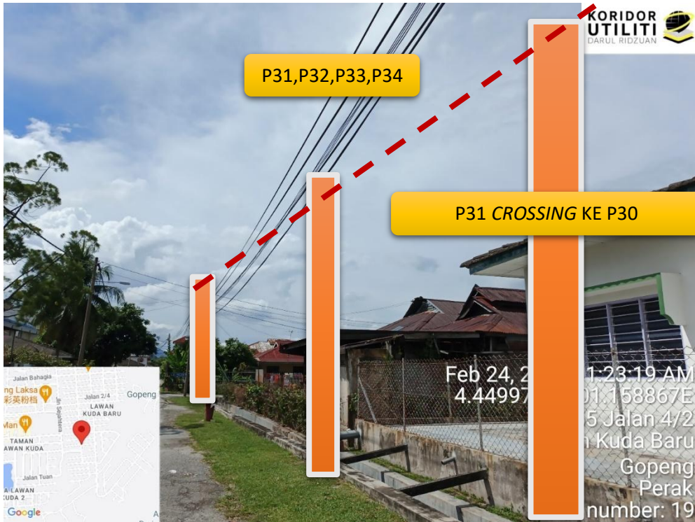
LOKASI DI JALAN 4/2, PENANAMAN TIANG
