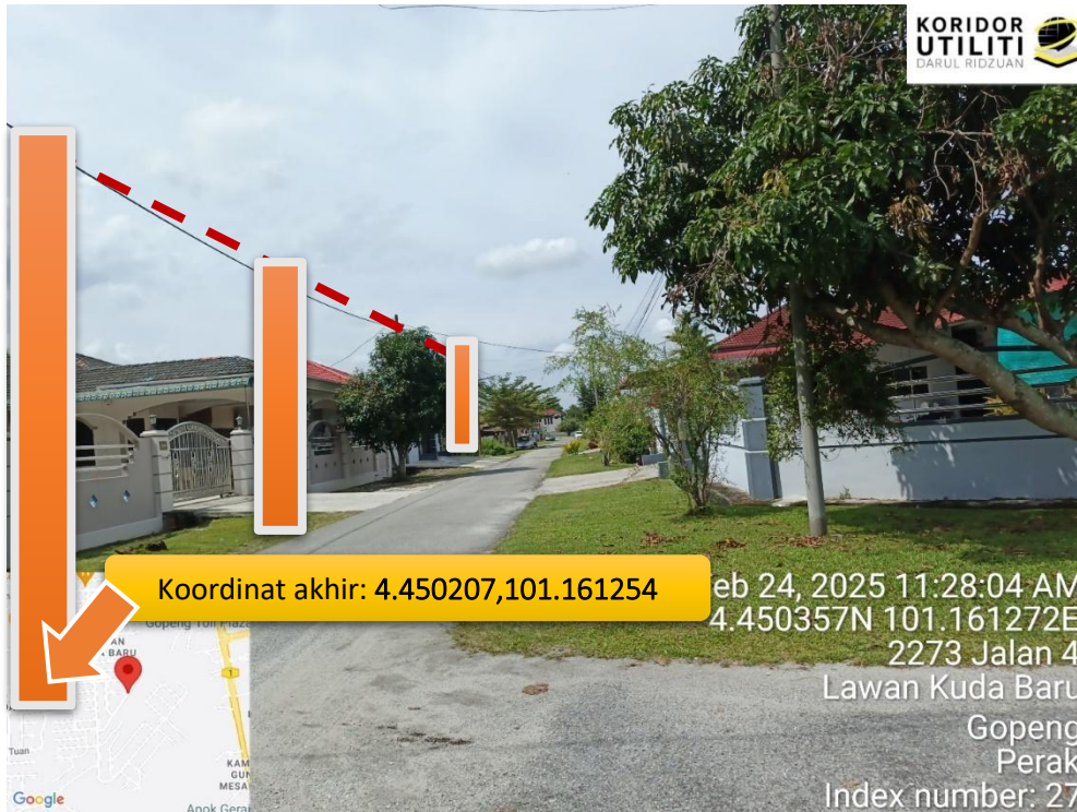
LOKASI DI JALAN 4, PENANAMAN TIANG
