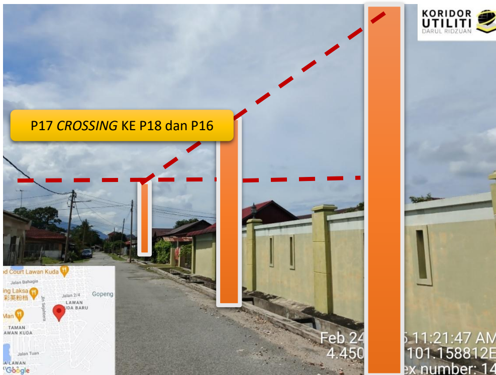
LOKASI DI JALAN 4, PENANAMAN TIANG
