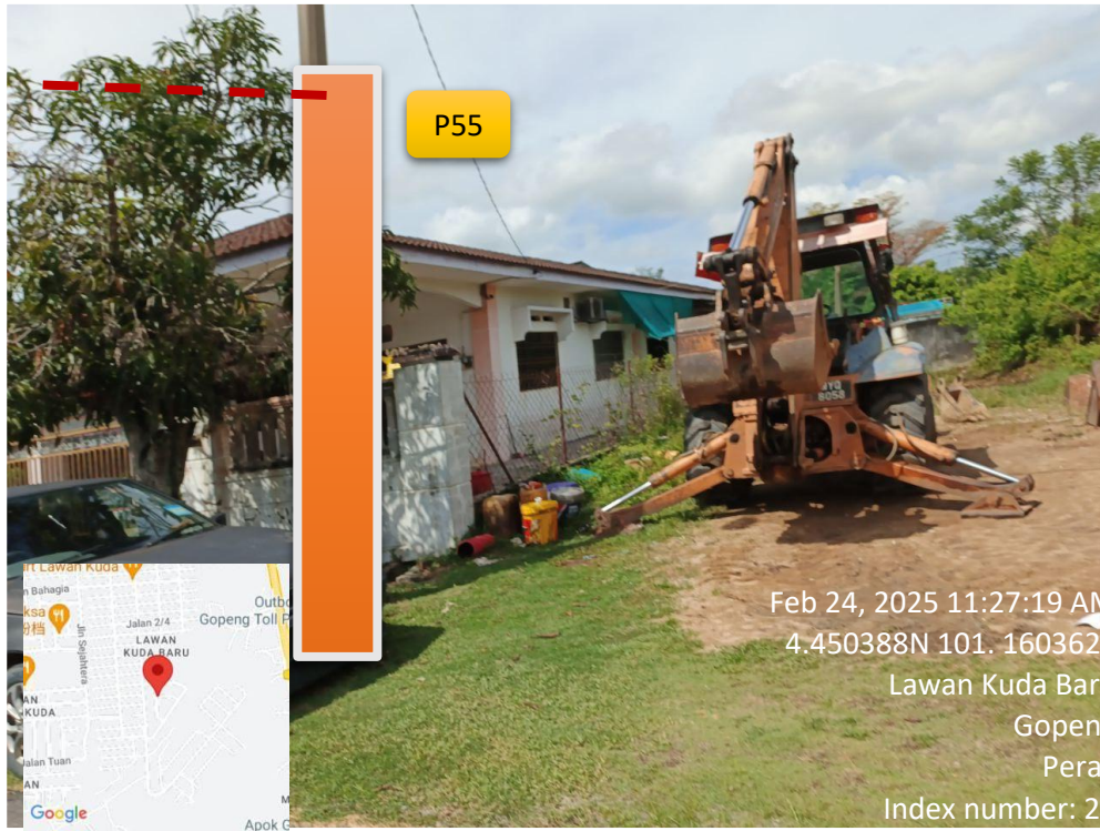
LOKASI DI JALAN 4, PENANAMAN TIANG
