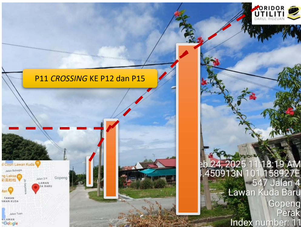
LOKASI DI JALAN 4, PENANAMAN TIANG
