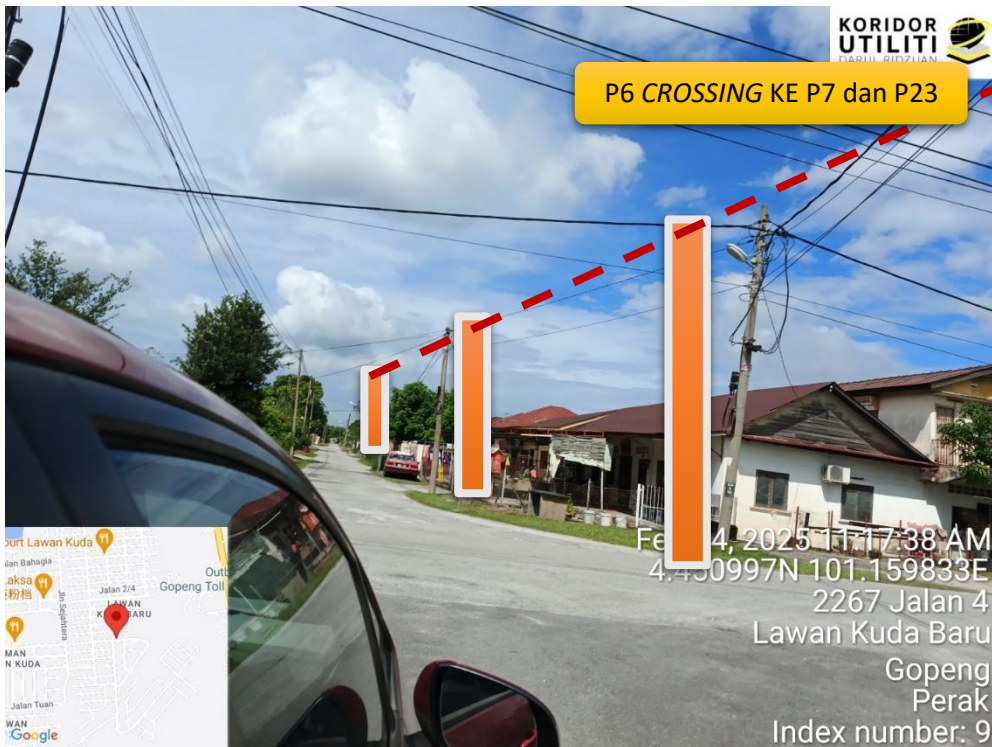
LOKASI DI JALAN 4, PENANAMAN TIANG
