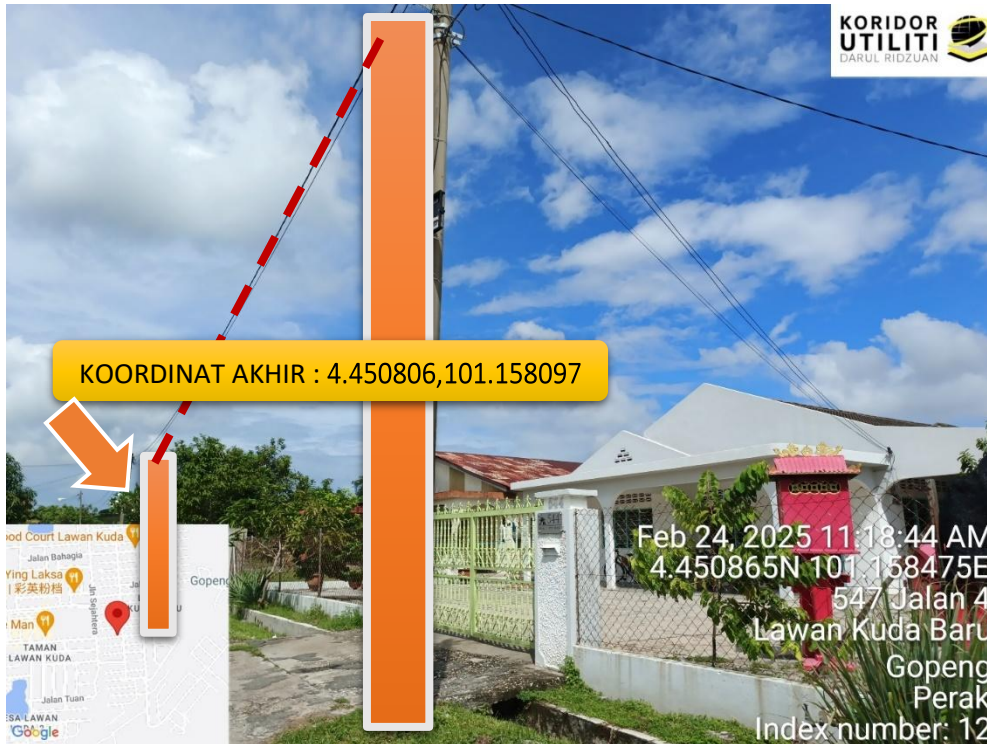
LOKASI DI JALAN 4, PENANAMAN TIANG
