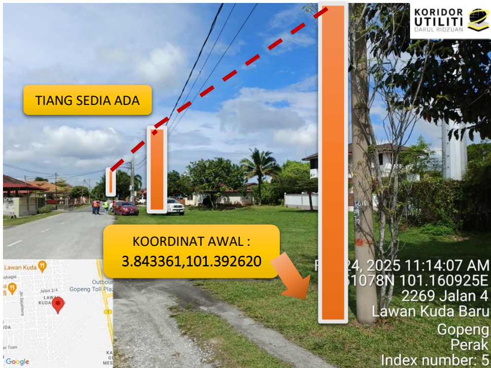
LOKASI DI JALAN 4, KOORDINAT AWAL PENANAMAN TIANG
