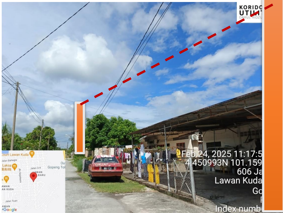
LOKASI DI JALAN 4, PENANAMAN TIANG
