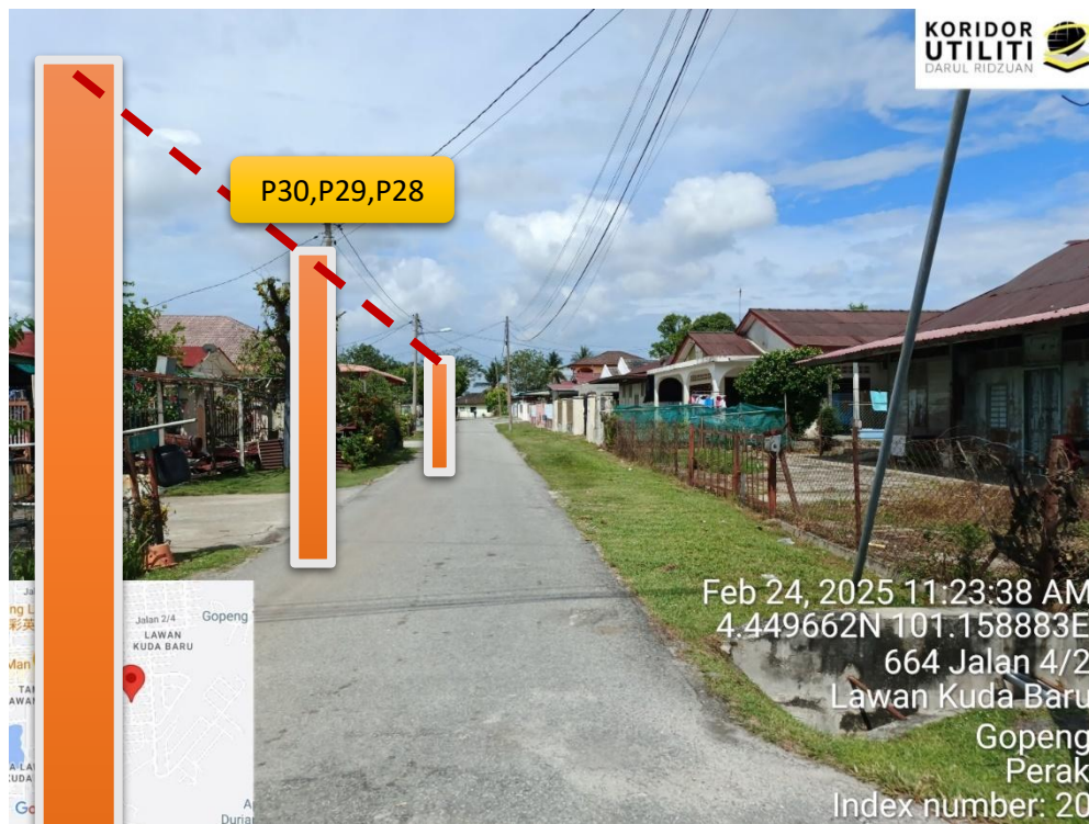
LOKASI DI JALAN 4/2, PENANAMAN TIANG
