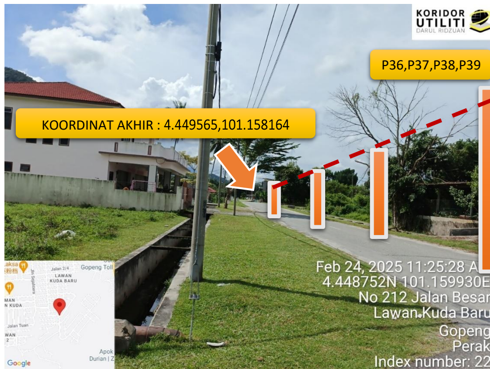
LOKASI DI JALAN 4, PENANAMAN TIANG
