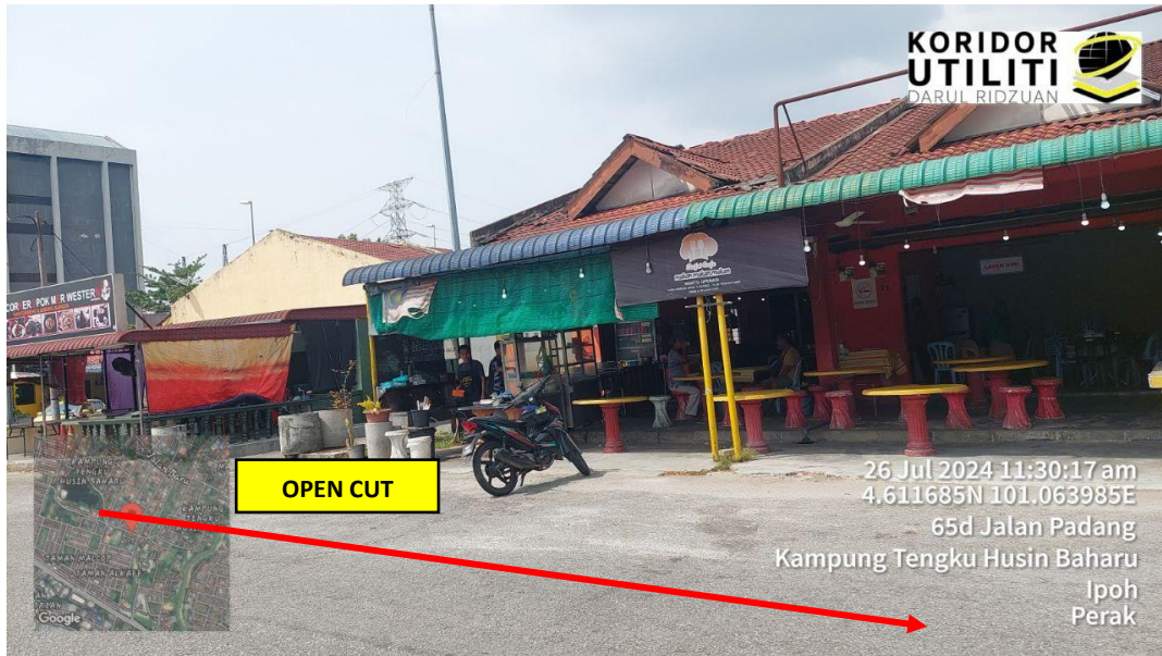
LOKASI DI JALAN PADANG
