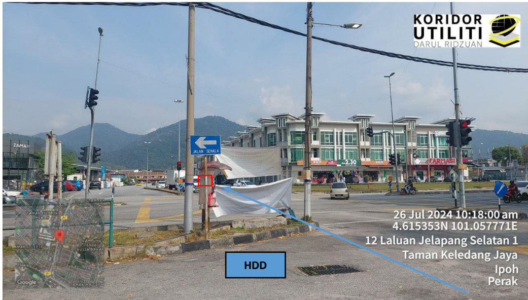
LOKASI DI PERSIMPANGAN LAMPU ISYARAT JALAN KLEDANG RAYA 1
