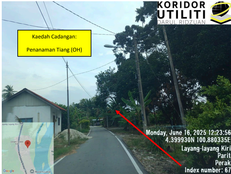
LOKASI: Jalan Layang – Layang Kiri
