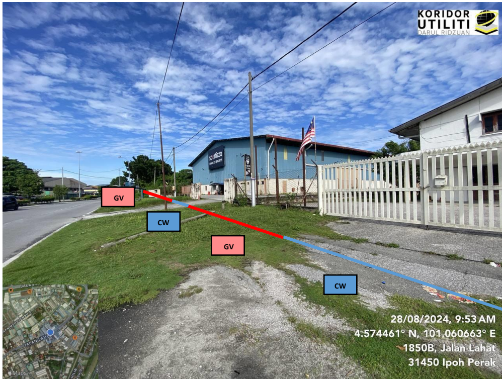
LOKASI KOREKAN GV DAN CW DI JALAN LAHAT
