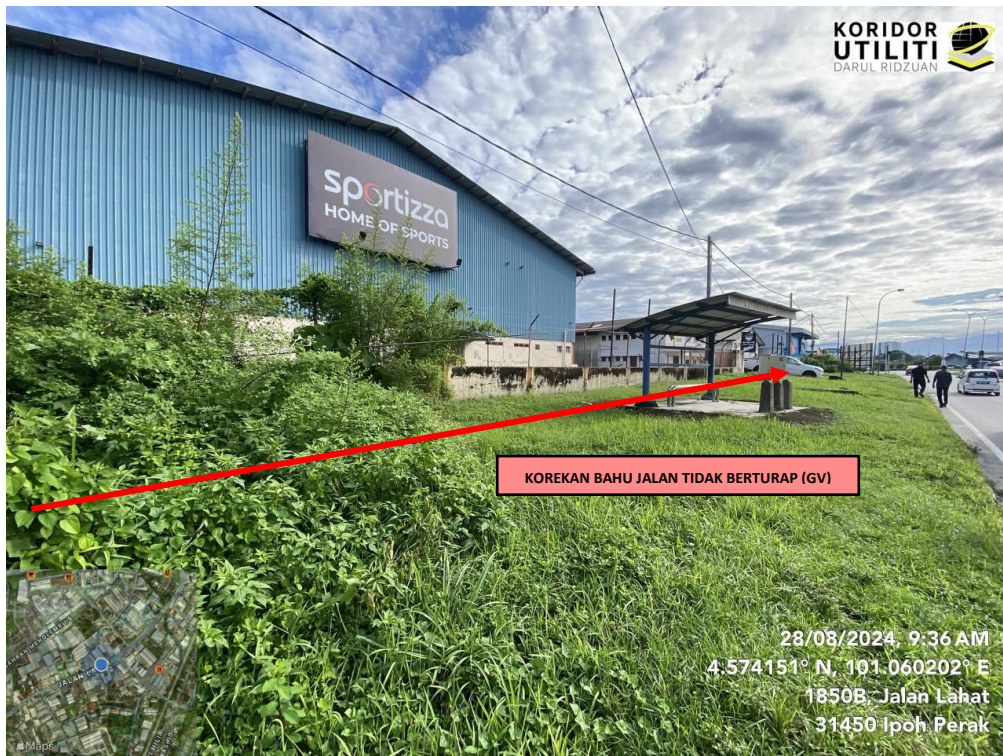
LOKASI KOREKAN GV DI JALAN LAHAT
