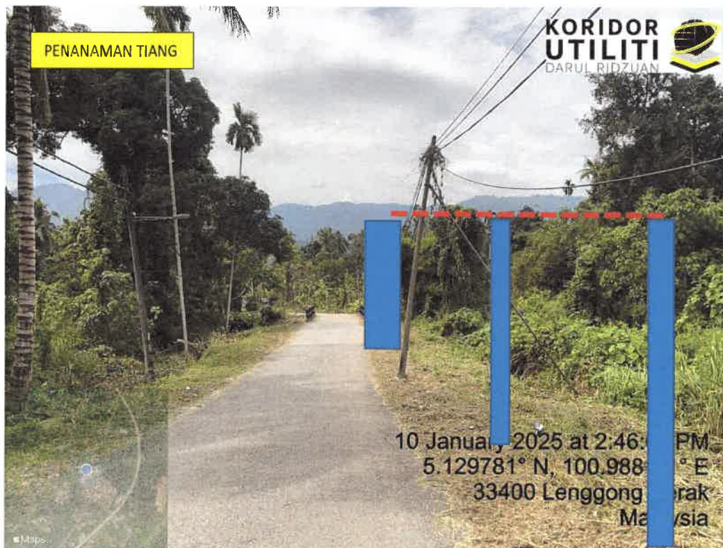
LOKASI DI JALAN UTAMA KAMPUNG GELOK
