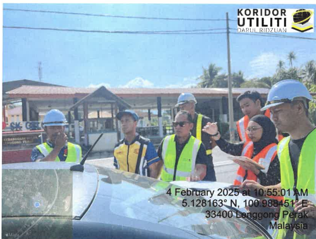
LOKASI DI JALAN UTAMA KAMPUNG GELOK
