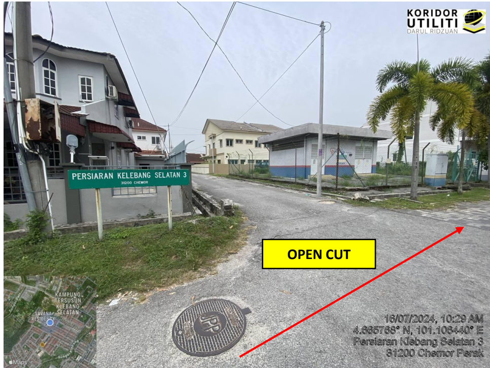
LOKASI DI PERSIARAN KLEBANG SELATAN 3
