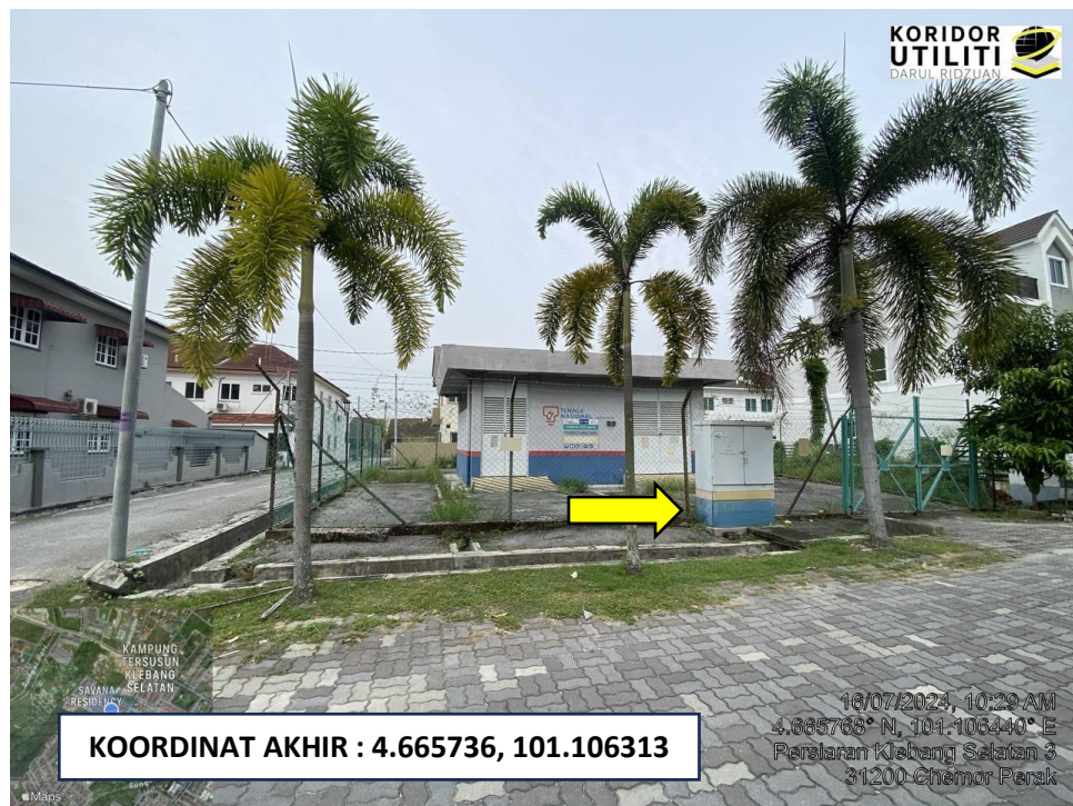
LOKASI DI PERSIARAN KLEBANG SELATAN 3
