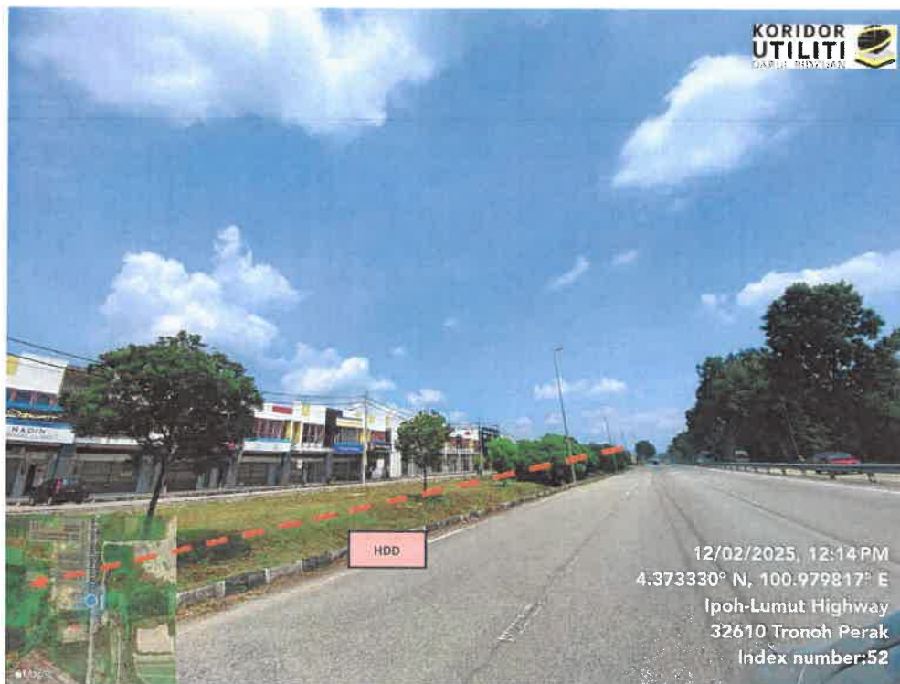
JAJARAN PENANAMAN UTILITI SECARA HDD DI LEBUHRAYA IPOH – LUMUT (FT005)
