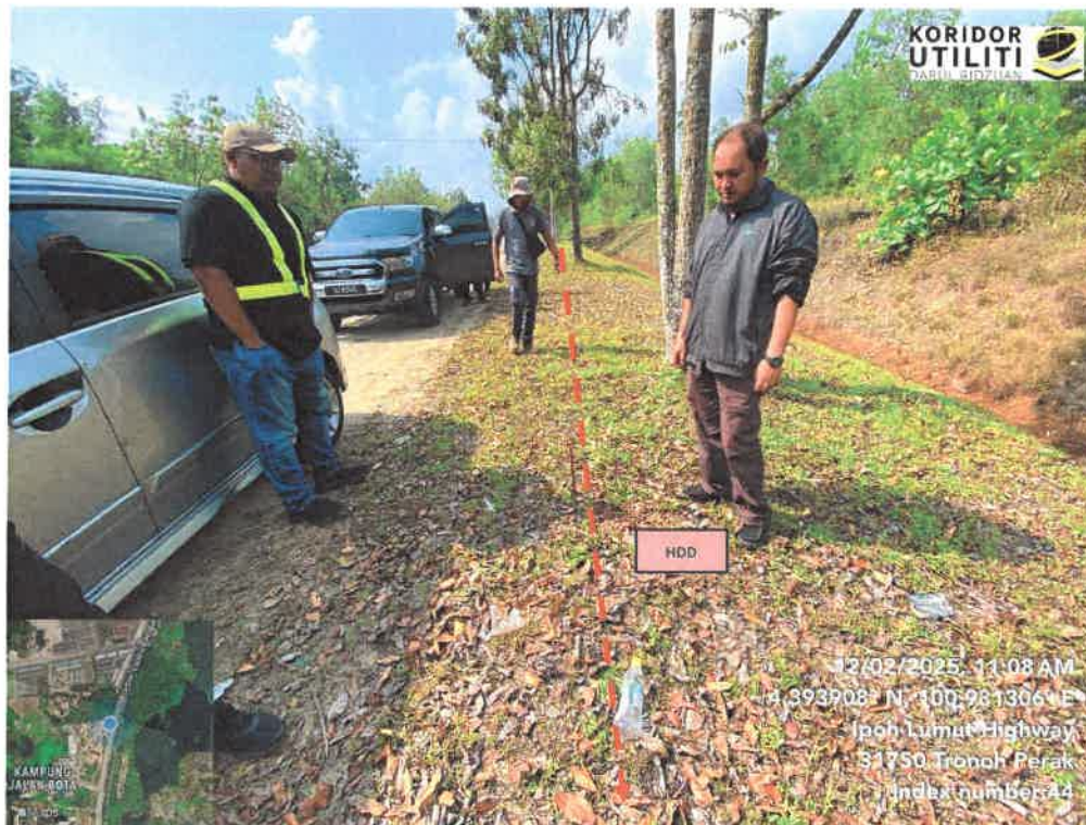
JAJARAN PENANAMAN UTILITI SECARA HDD DI LEBUHRAYA IPOH – LUMUT (FT005)
