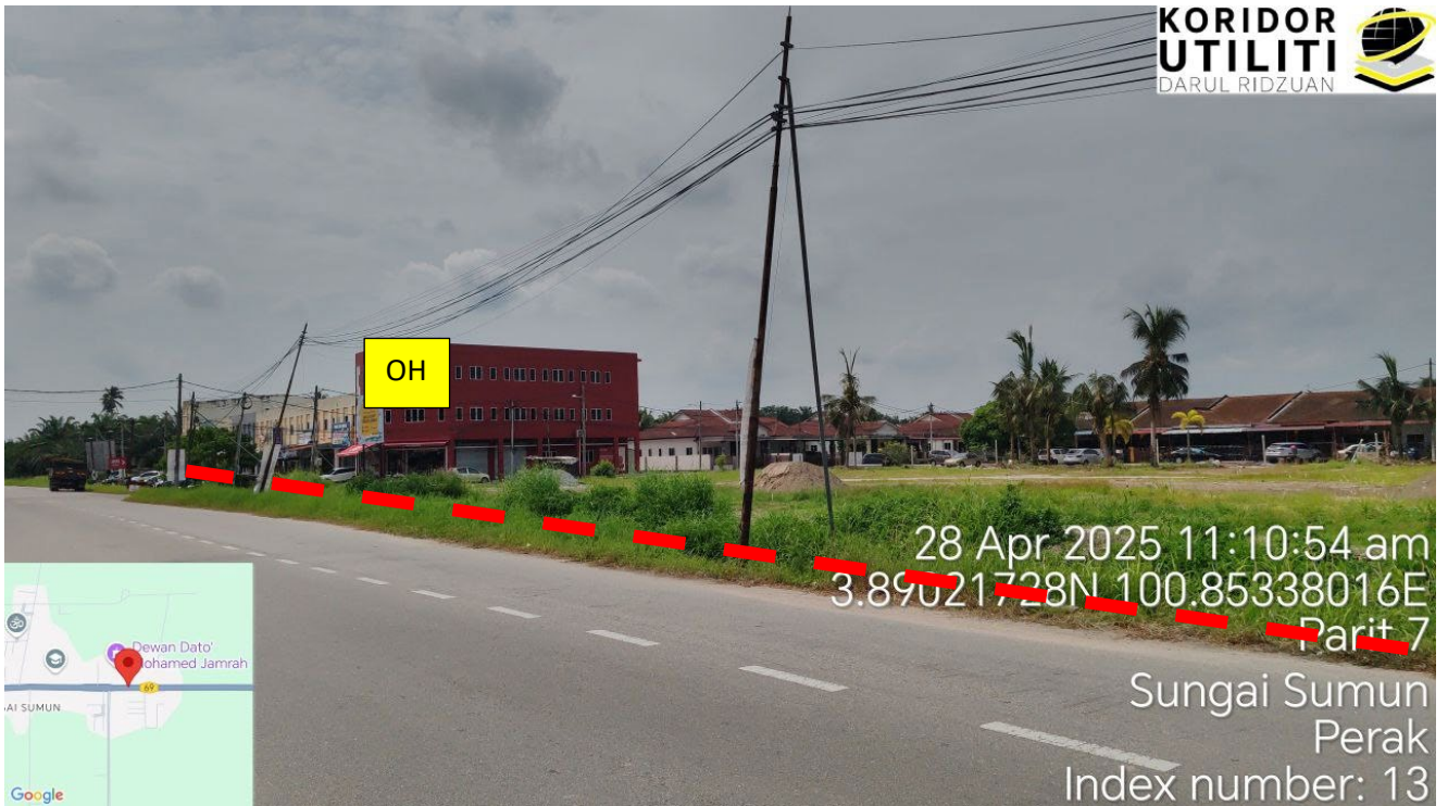
Jalan Simpang Empat – Bagan Datuk
