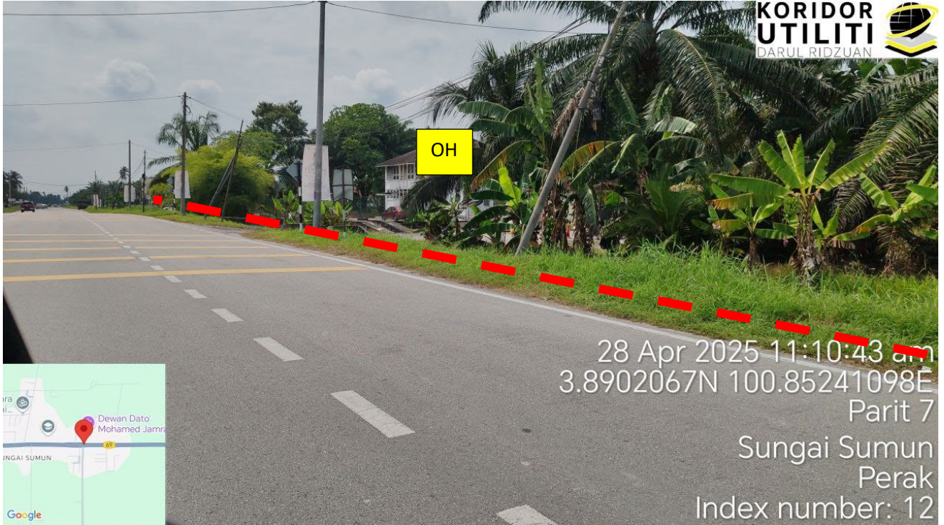
Jalan Simpang Empat – Bagan Datuk
