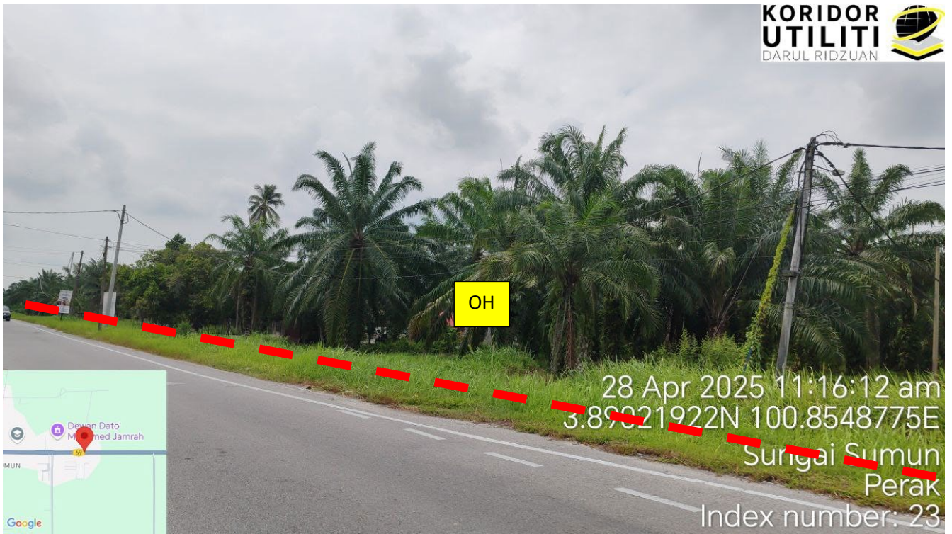
Jalan Simpang Empat – Bagan Datuk
