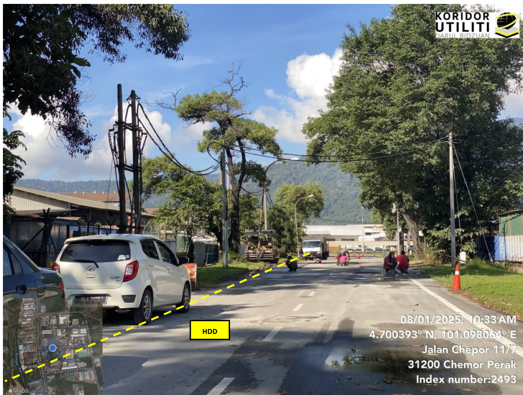
JAJARAN KOREKAN HDD DI JALAN CHEPOR 11/7
