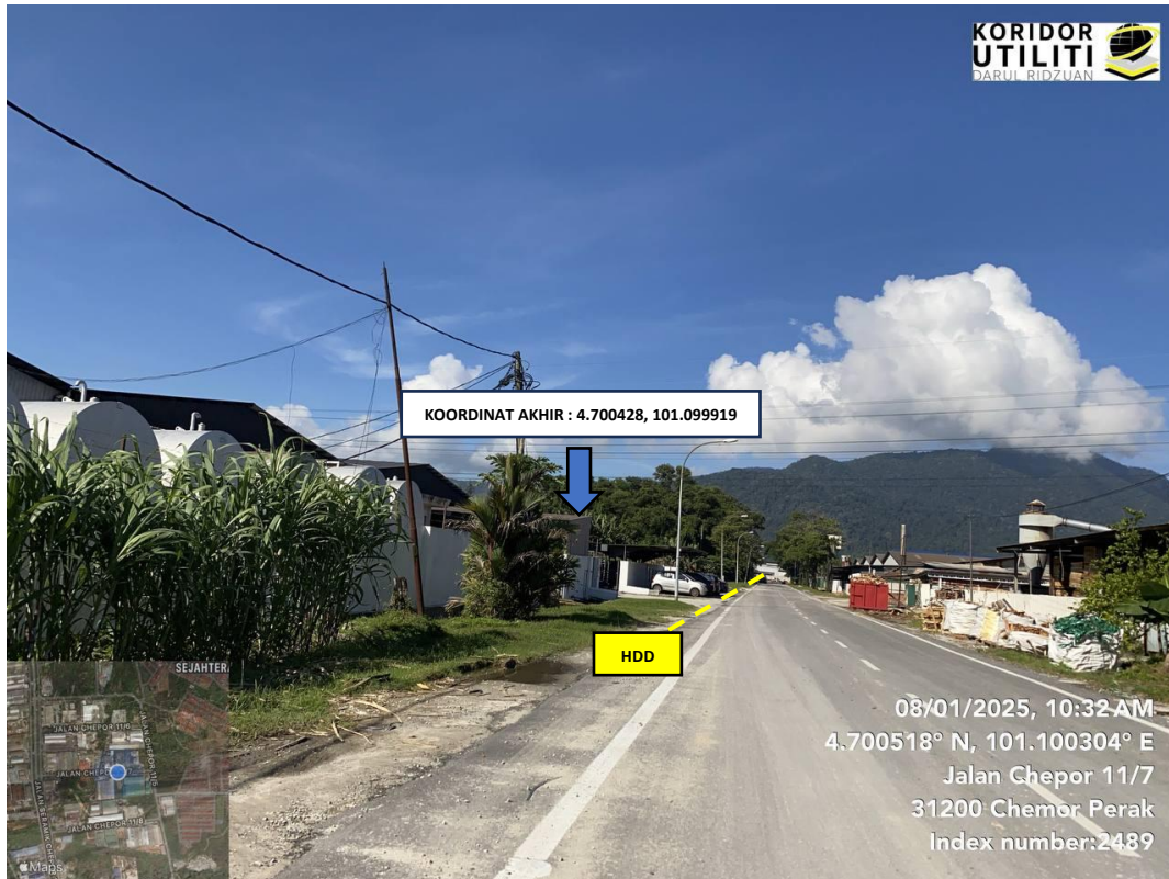
LOKASI KOORDINAT AKHIR KOREKAN HDD DI JALAN CHEPOR 11/7 (Sambungan akan dibuat ke P/E Sin Thai Seng)
