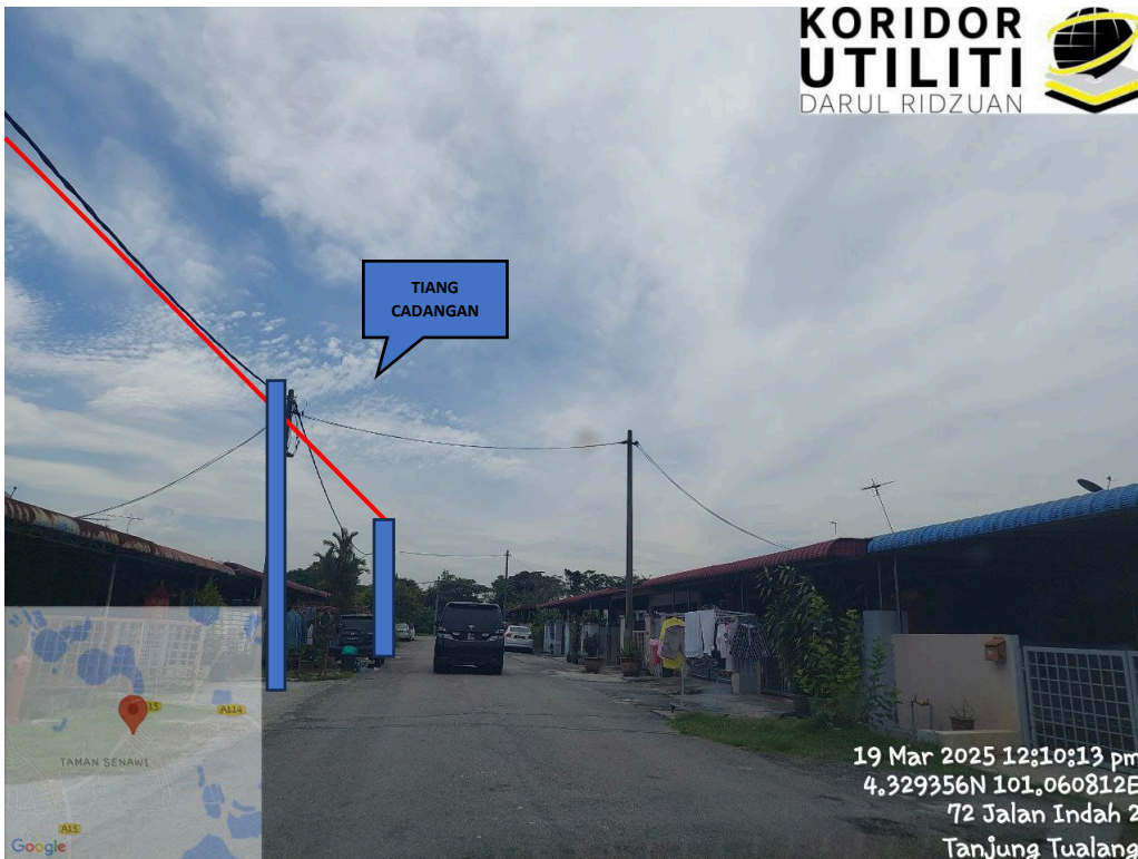
AJARAN PENANAMAN TIANG DI JALAN INDAH 4
