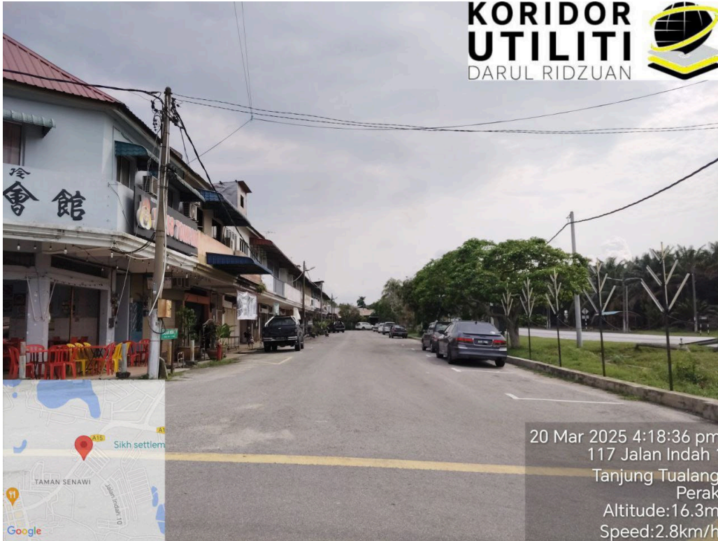
JAJARAN PENANAMAN TIANG DI JALAN INDAH 1
