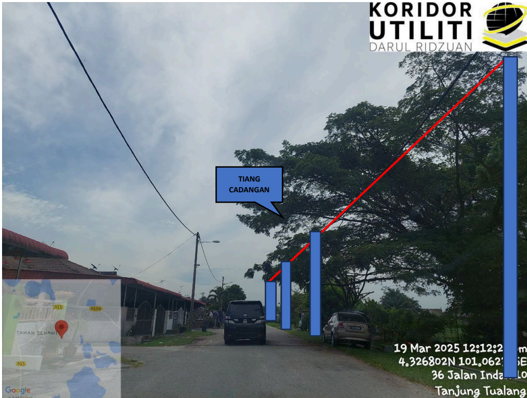
JAJARAN PENANAMAN TIANG DI JALAN INDAH 10
