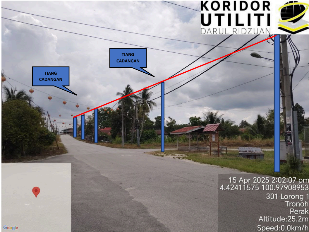
PENANAMAN TIANG DI JALAN KAMPONG NALLA
