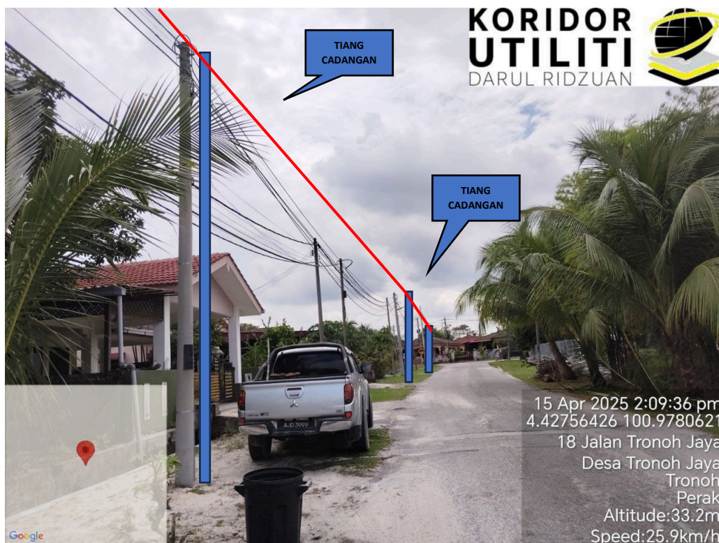
JAJARAN PENANAMAN TIANG DI JALAN TRONOH JAYA
