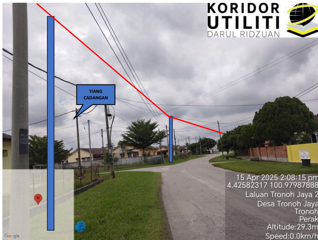
JAJARAN PENANAMAN TIANG DI JALAN TRONOH JAYA
