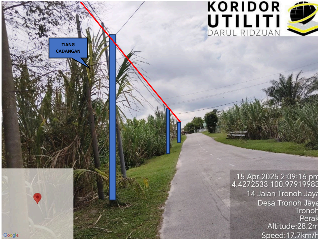
JAJARAN PENANAMAN TIANG DI JALAN TRONOH JAYA
