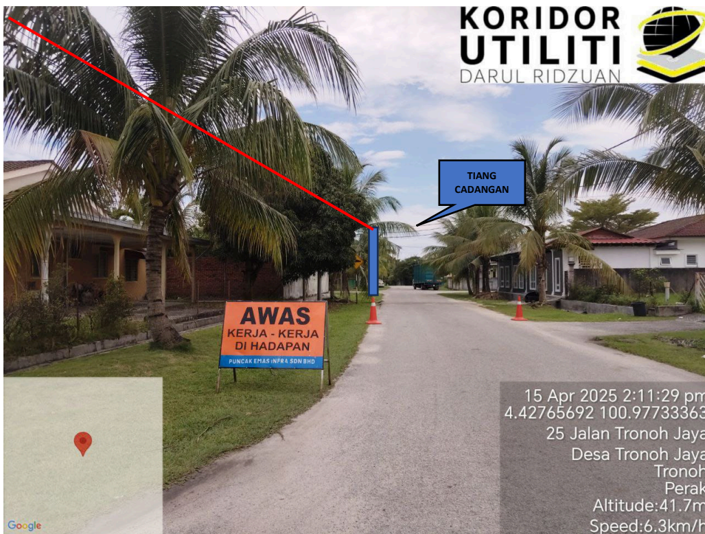
JAJARAN PENANAMAN TIANG DI JALAN TRONOH JAYA
