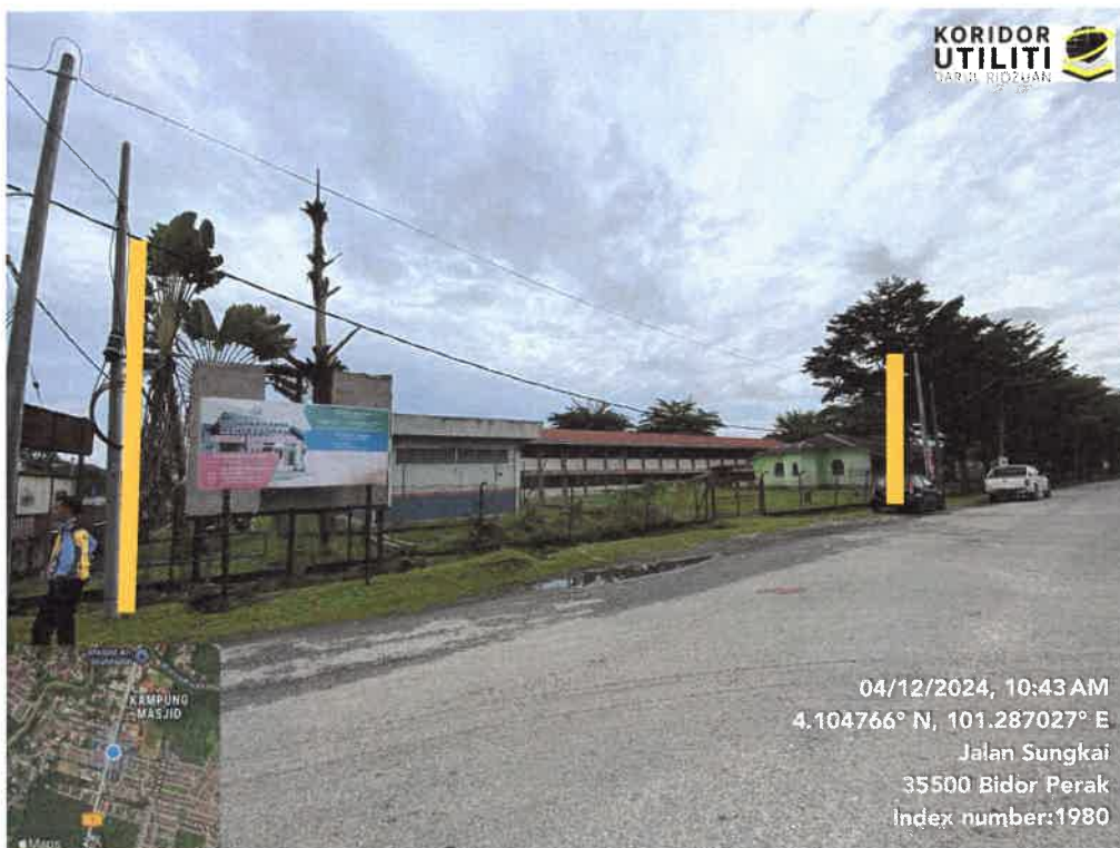
JAJARAN PEMASANGAN TIANG
