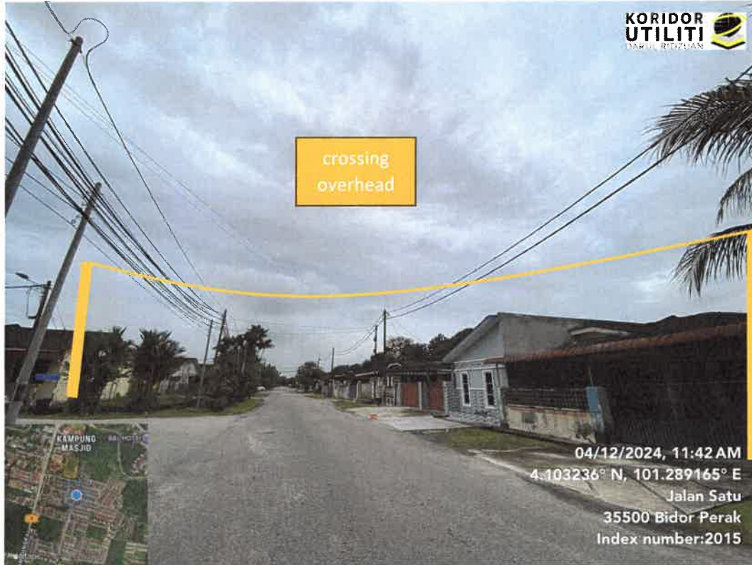
JAJARAN PEMASANGAN TIANG
