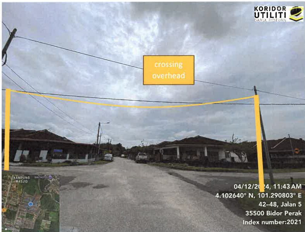
JAJARAN PEMASANGAN TIANG
