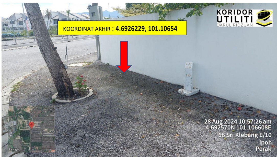
LOKASI DI JALAN SRI KLEBANG E/9 BANDAR BARU SRI KLEBANG
