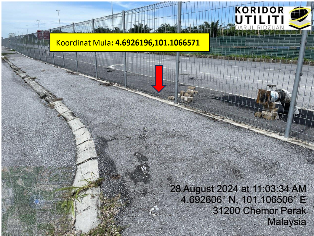
LOKASI DI JALAN SRI KLEBANG E/9 BANDAR BARU SRI KLEBANG
