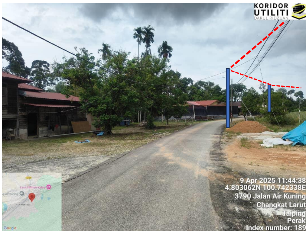
CADANGAN PENANAMAN TIANG DI JALAN PDT
