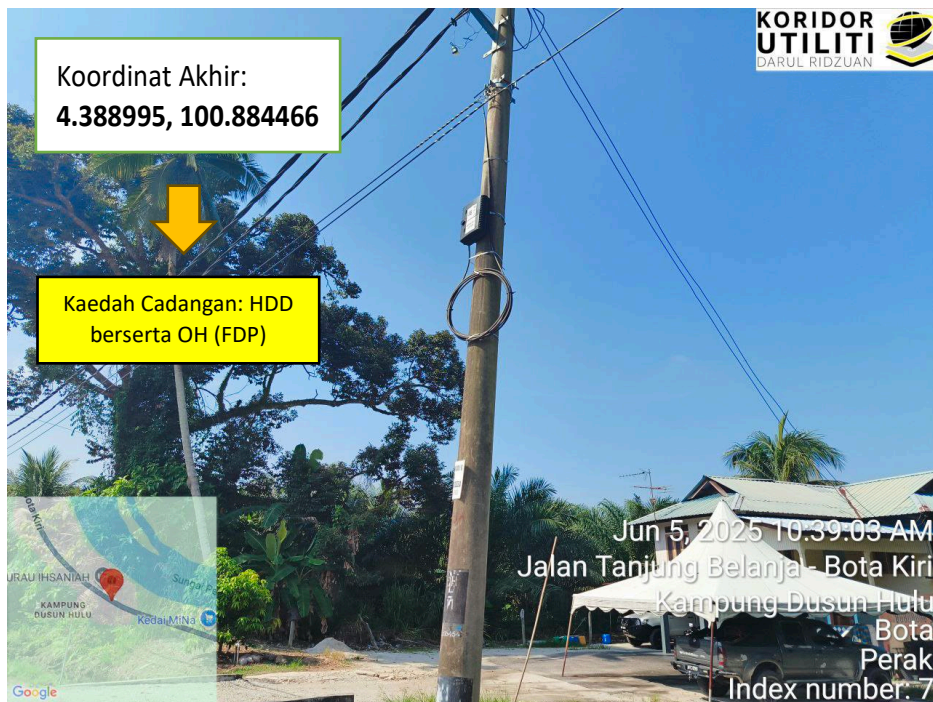
LOKASI: Jalan Tanjung Belanja – Bota Kiri (72)
