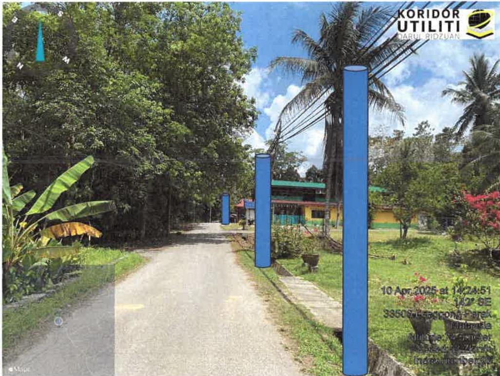
LOKASI DI JALAN BUKIT BUNGA
