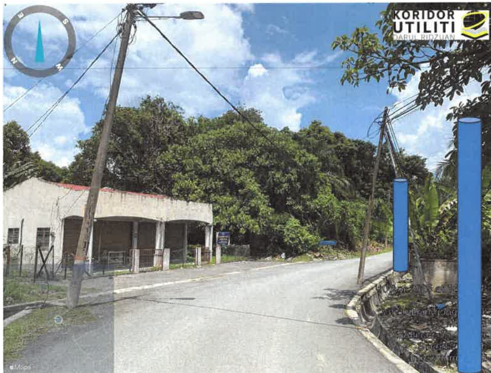
LOKASI DI JALAN BUKIT BUNGA
