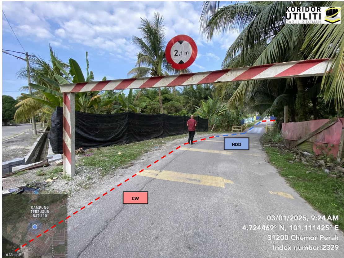
JAJARAN KOREKAN TERBUKA DAN HDD DI LALUAN CHEMOR MAJU 4 (Korekan HDD akan melalui Sungai Kuang)
