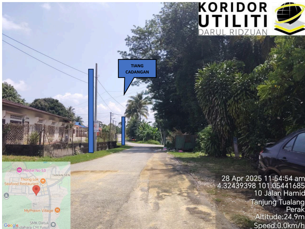
JAJARAN PENANAMAN TIANG DI JALAN KLINIK
