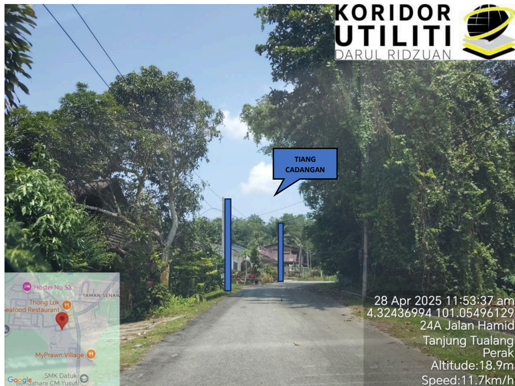
JAJARAN PENANAMAN TIANG DI JALAN ABDULLAH
