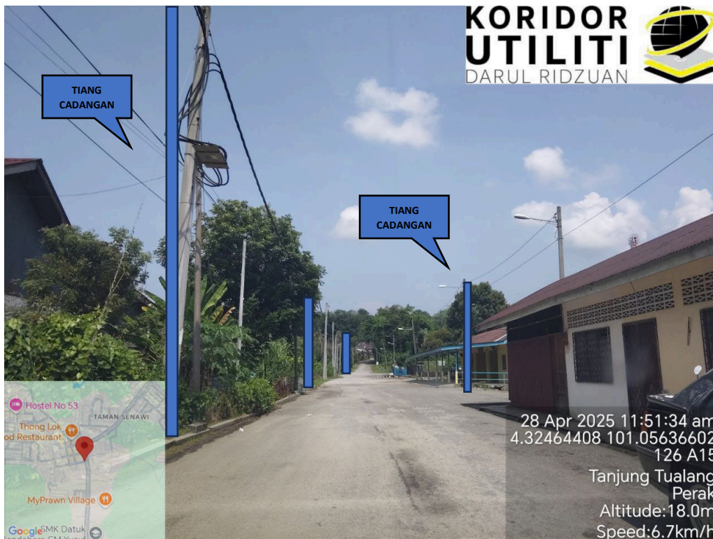
JAJARAN PENANAMAN TIANG DI JALAN ABDULLAH
