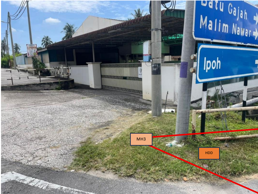
JAJARAN HDD DAN MANHOLE DI JALAN PUSING – TG TUALANG
