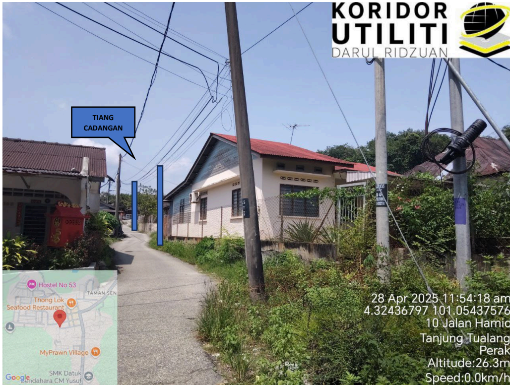
JAJARAN PENANAMAN TIANG DI JALAN PDT
