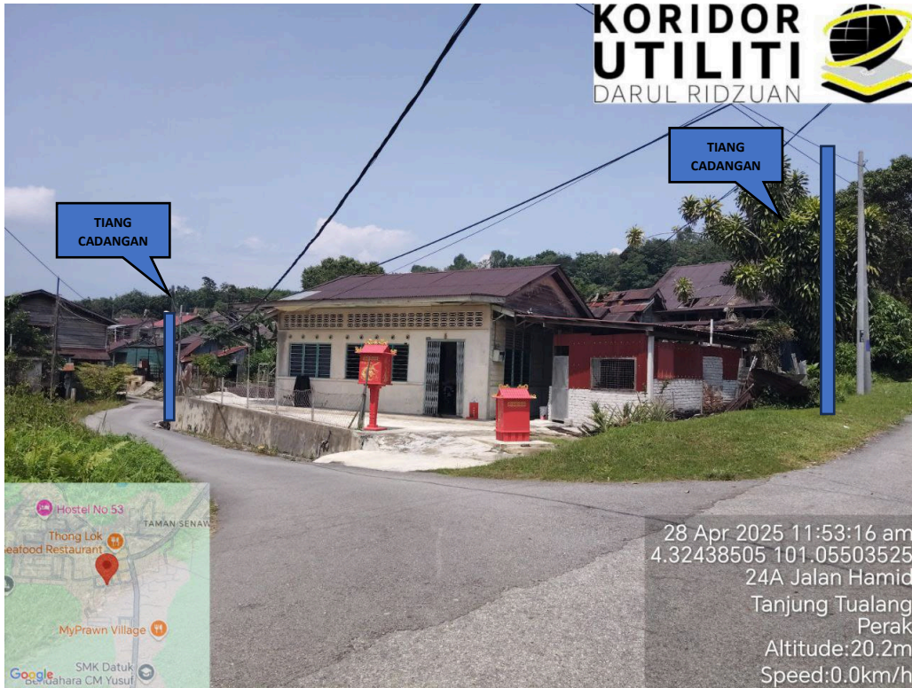
JAJARAN PENANAMAN TIANG DI JALAN ABDULLAH
