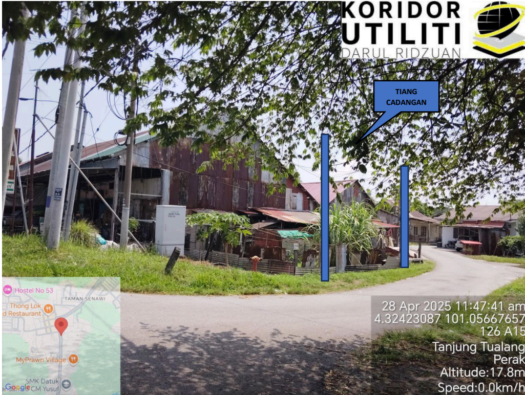
JAJARAN PENANAMAN TIANG DI JALAN TAMAN KWONG YIK
