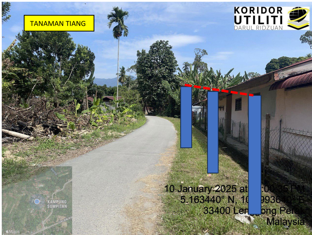
LOKASI DI JALAN KAMPUNG SUMPITAN
