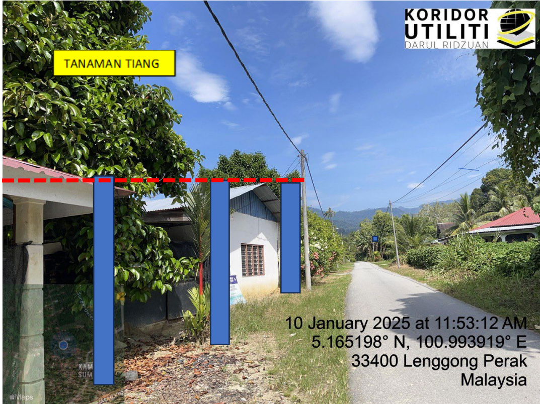
LOKASI DI JALAN KAMPUNG SUMPITAN
