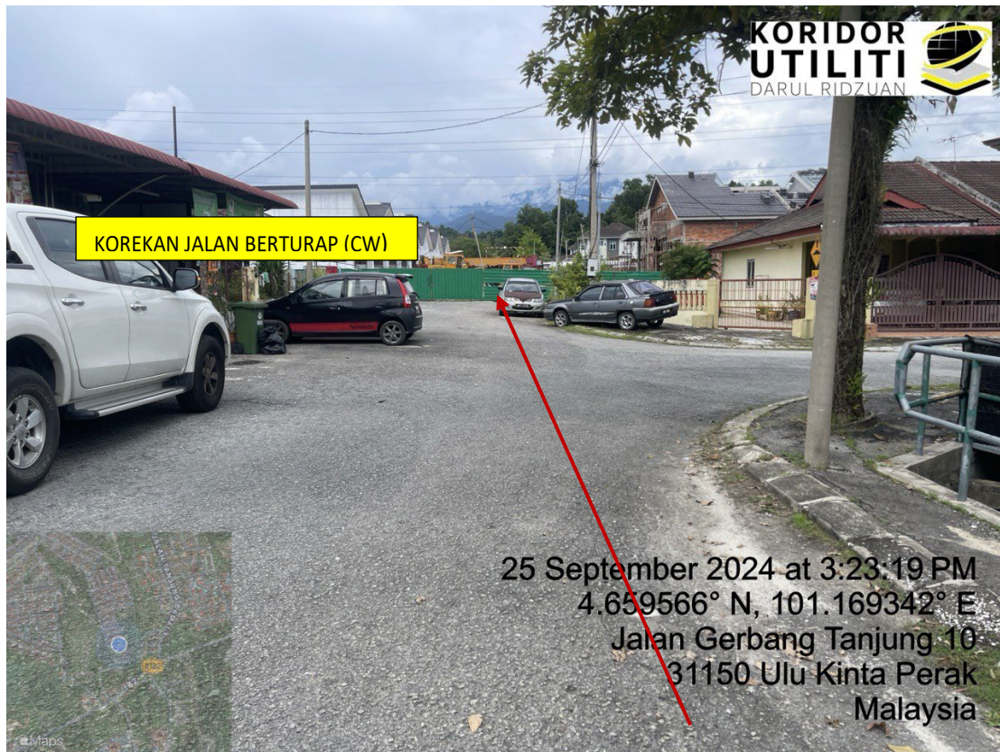
LOKASI DI JALAN GERBANG TANJUNG 10
