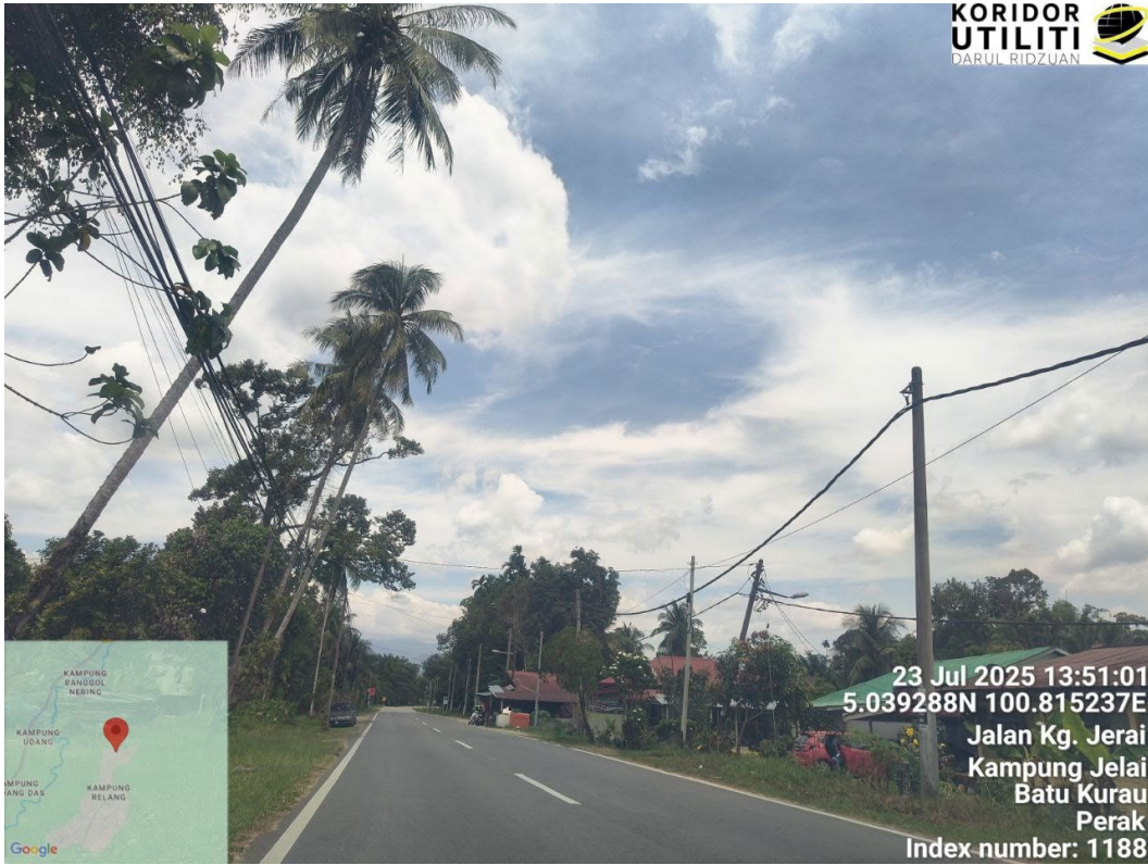
LALUAN PENANAMAN TIANG – JALAN JKR
