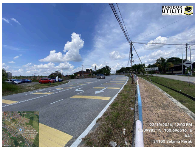
Cadangan pit Pertama pipe jacking
