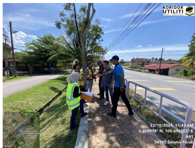
Perbincangan laluan kaedah pipe jacking.
