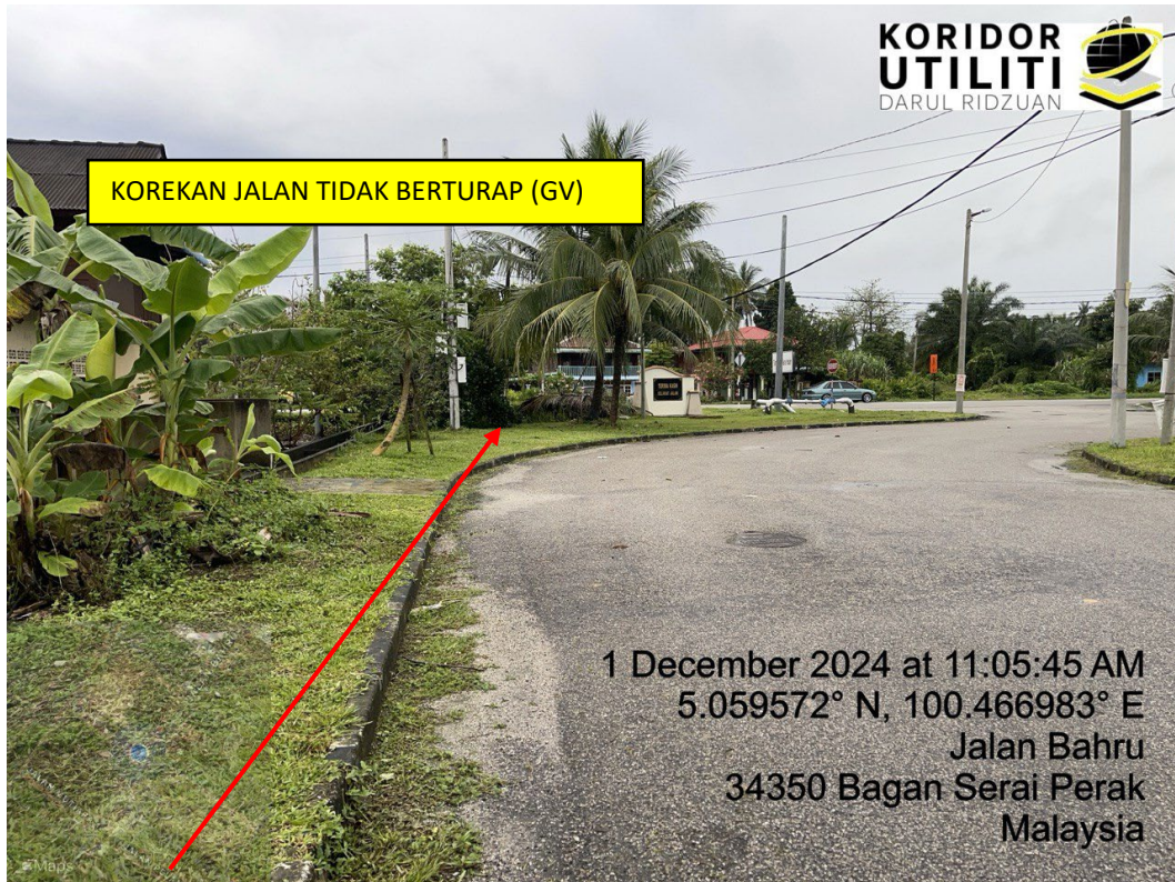
LOKASI DI JALAN INDAH 1
