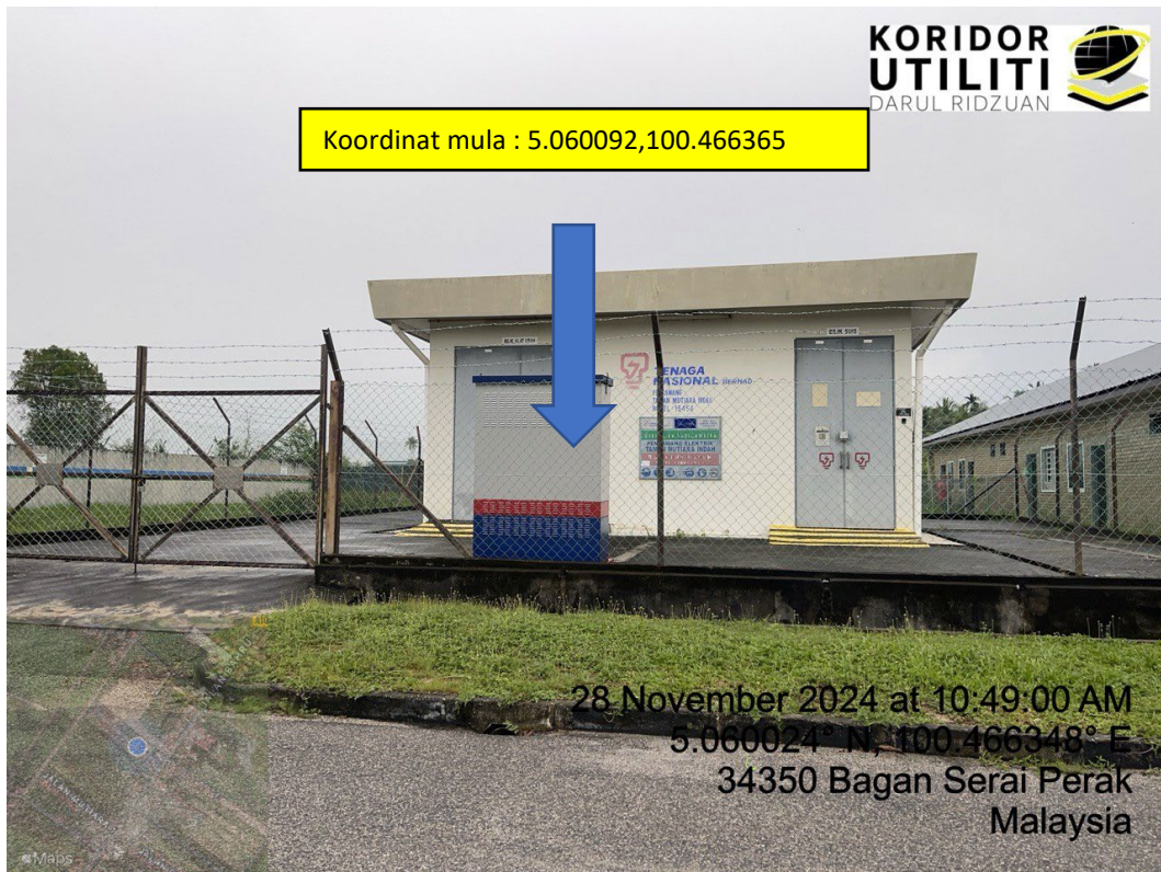
LOKASI DI JALAN INDAH 1
