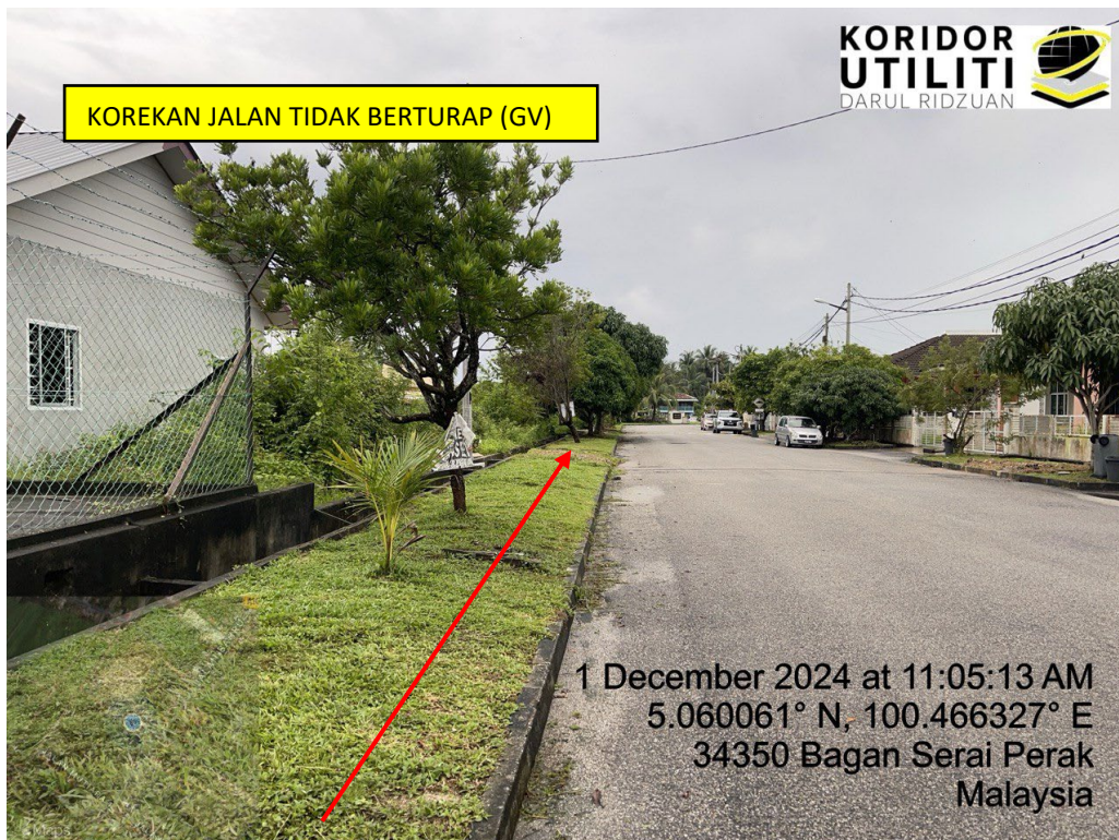
LOKASI DI JALAN INDAH 1
